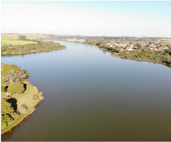
Figura 1. Lago formado pela Barragem no bairro do Patrimônio, Brotas/SP.
