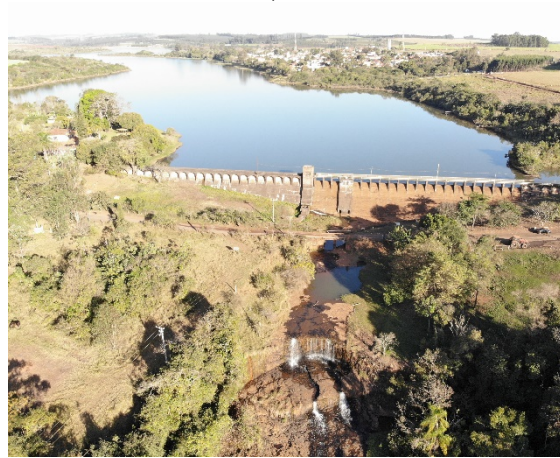
Figura 2. Vista aérea da Barragem no bairro Patrimônio, Brotas/SP.
