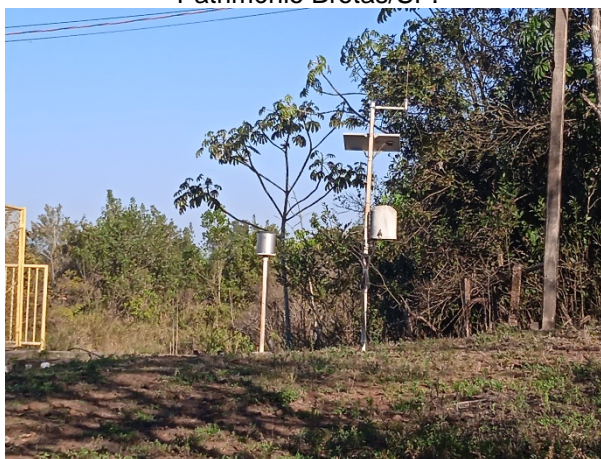
Figura 19. 3ª Estação Pluviométrica – Barragem Patrimônio Brotas/SP.
