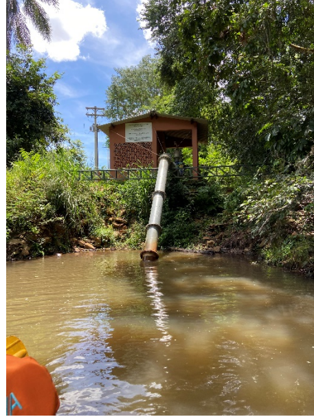
Figura 12. Captação existente outorgada.
