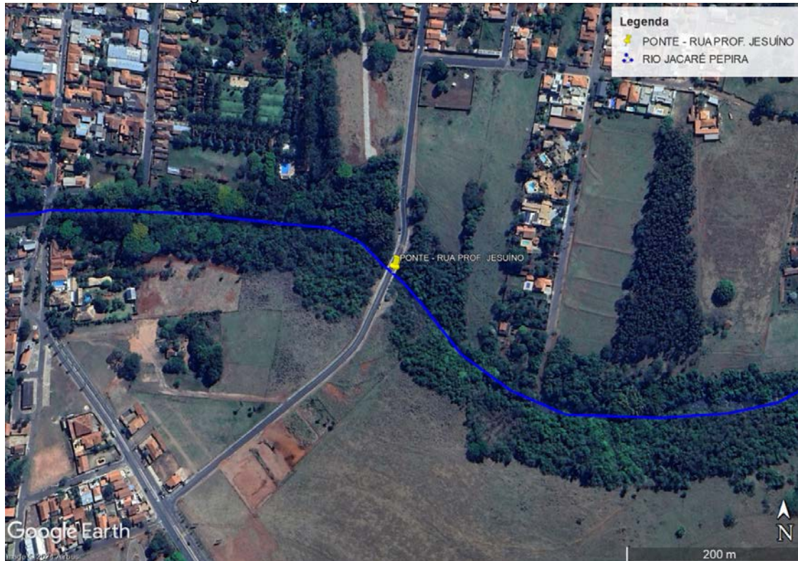
Figura 8. Vista aérea – Ponte Rua Professor Jesuíno.
