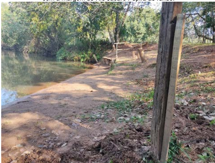
Figura 41. Régua de leitura do nível d'água utilizada pelas agências de turismo – vista lateral com a margem do Rio Jacaré Pepira ao fundo.
