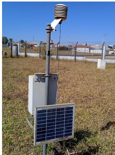
Figura 17. 1ª Estação Pluviométrica - desativada.
