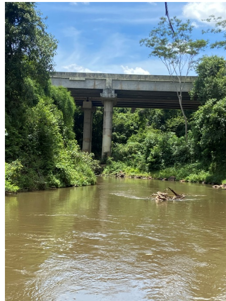
Fonte: Novaes Engenharia, 2024.
