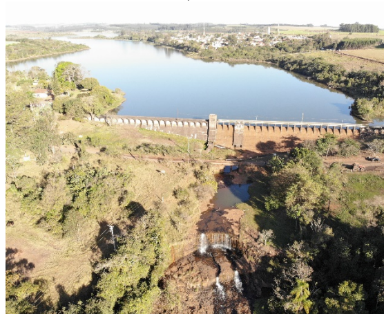
Figura 7. Vista aérea da Barragem no bairro Patrimônio, Brotas/SP.
