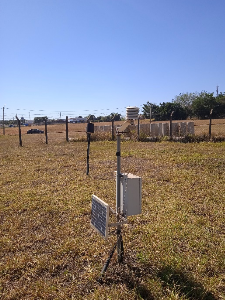
Figura 18. 1ª Estação Pluviométrica - desativada.
