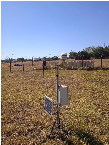
Figura 16. 1ª Estação Pluviométrica - desativada.
