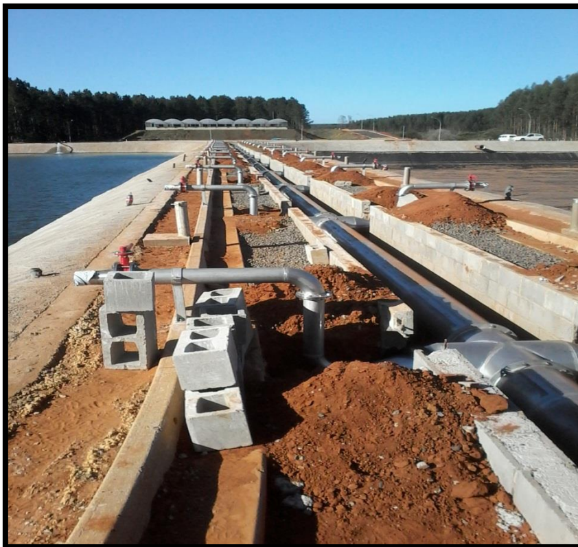
Figura 28 – Implantação do sistema de aeração
