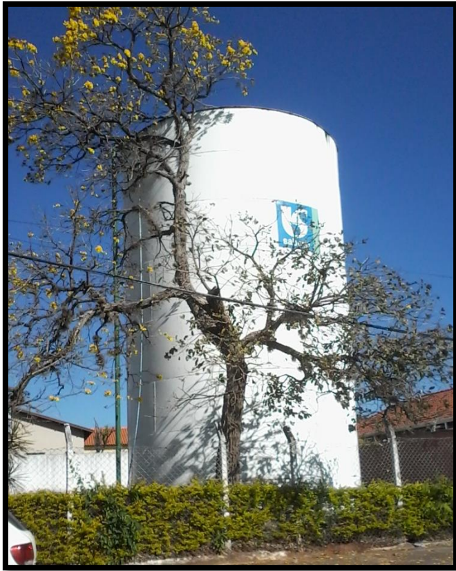
Figura 13 – Reservatório “Jardim Márcia”
