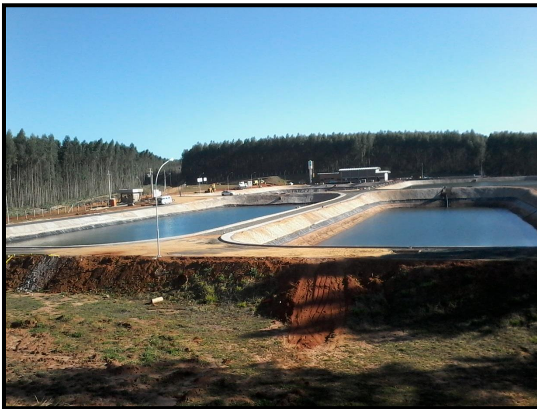
Figura 21 – Vista da ETE que está sendo implantada em Agudos
