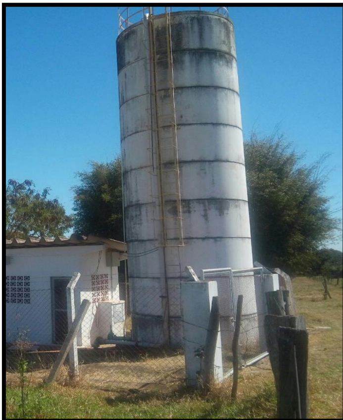
Figura 18 – Reservatório “Distrito de Domélia”
