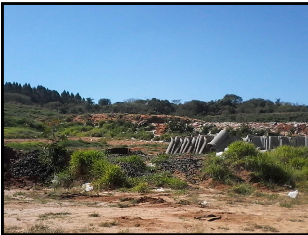
Figura 41 –Aterro sanitário do município
