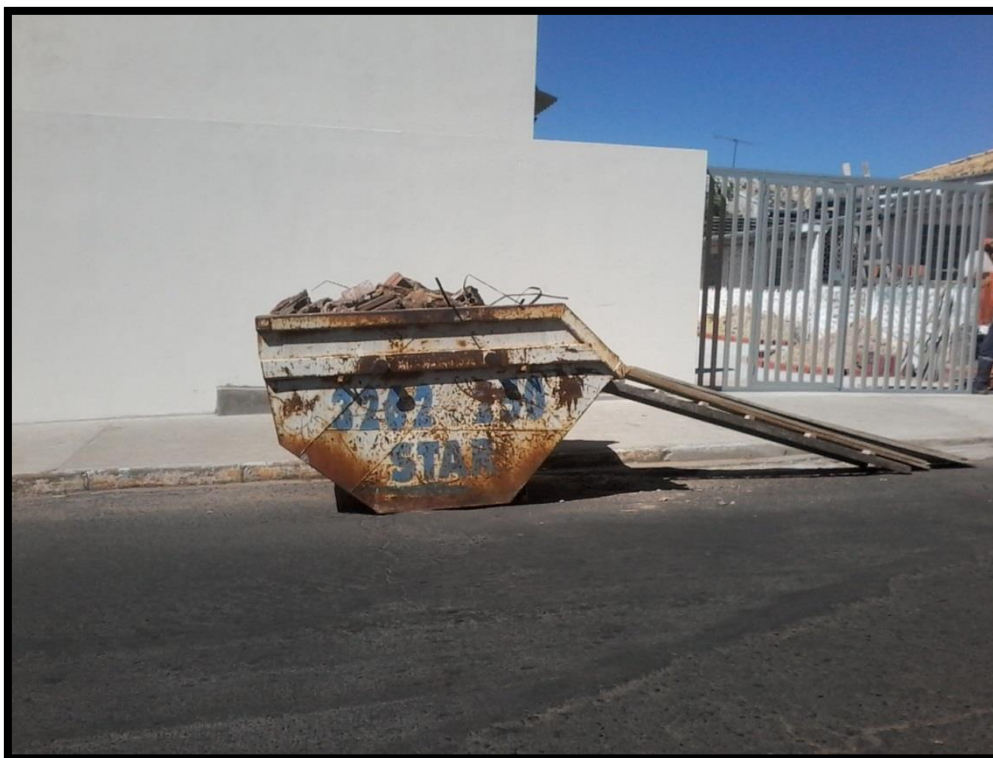
Figura 43 – Acondicionamento de RCC em caçambas alugadas
