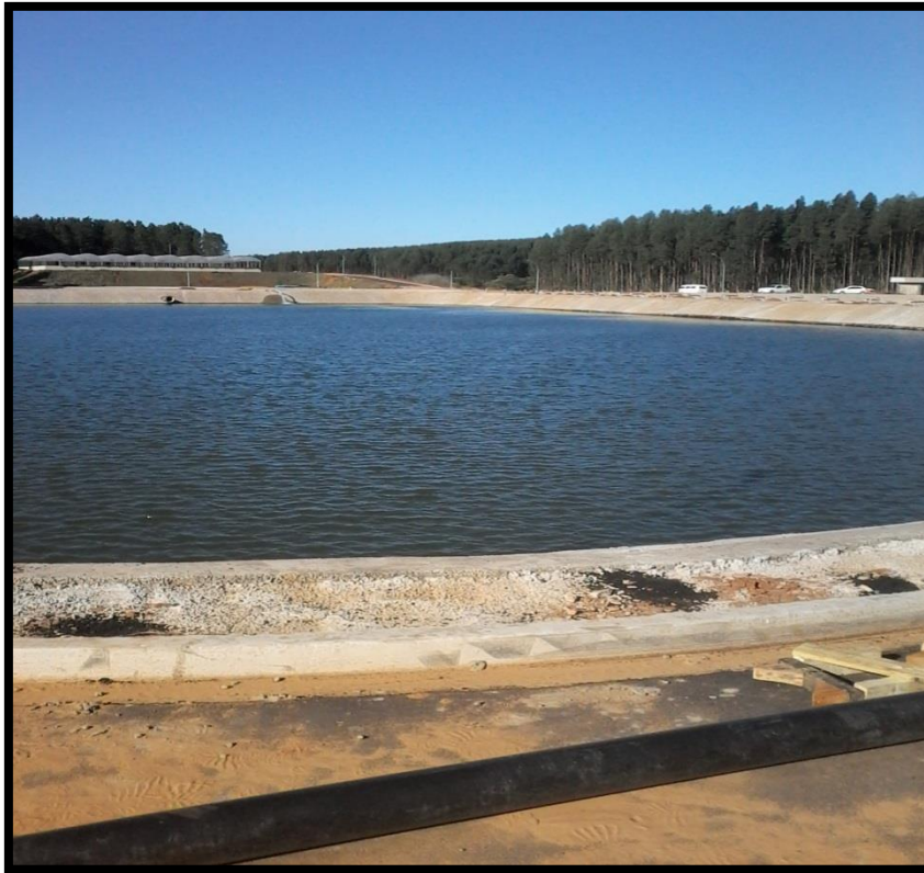
Figura 27 – Lagoa aerada com água da chuva
