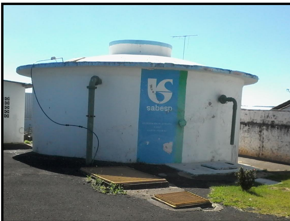
Figura 16 – Reservatório “Santa Cecília”
