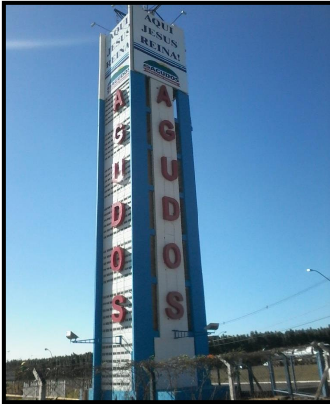
Figura 19 – Reservatório “Distrito Industrial”
