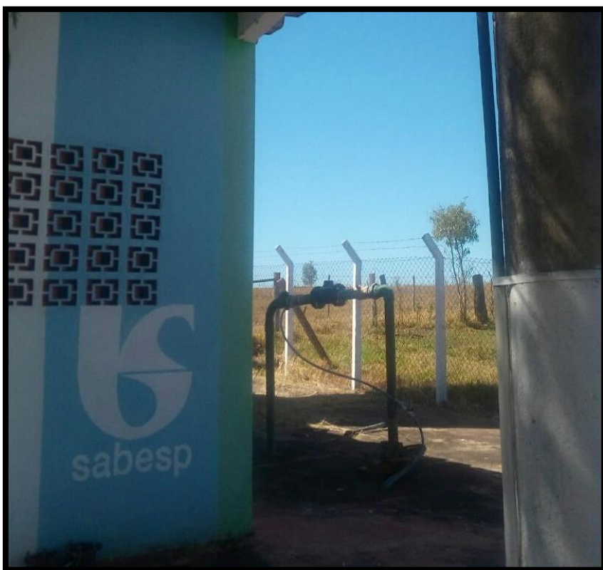
Figura 9 - Poço do Distrito de Domélia
