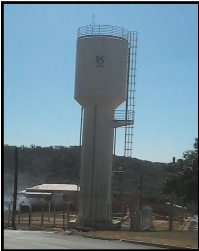
Figura 14 – Reservatório “Jardim Maria Luiza”
