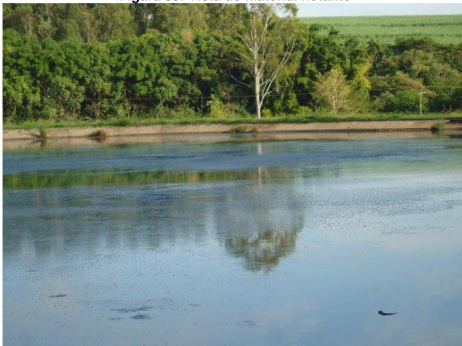
**Figura 40: Espuma no canal distribuidor de entrada da lagoa aeróbia**
