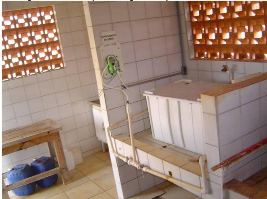
**Figura 19: Sistema de dosagem de ácido fluossilícico UT2**
