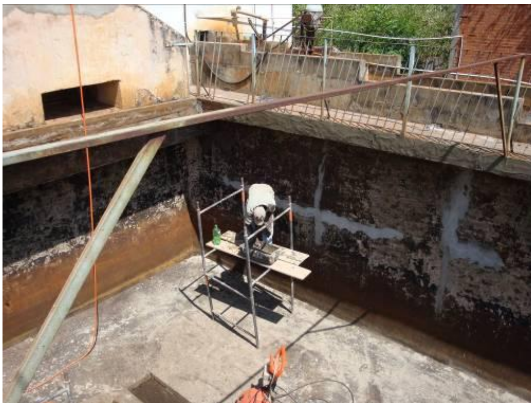
Figura 15. Registro fotográfico da situação atual da ETA de Ibitinga
