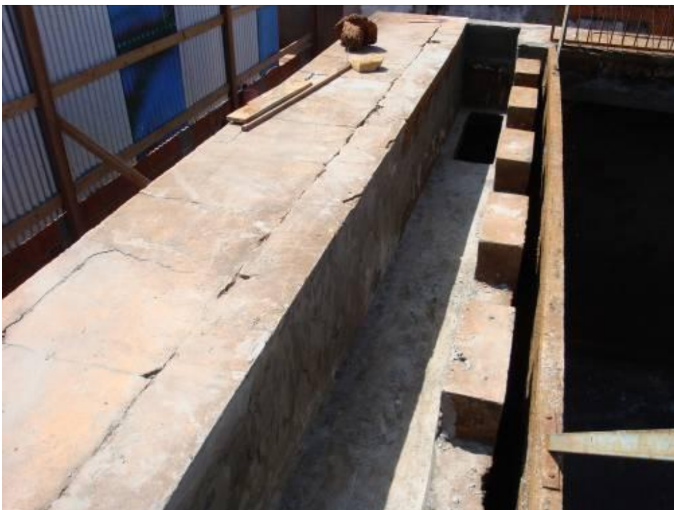
Figura 18. Registro fotográfico da situação atual da ETA de Ibitinga
