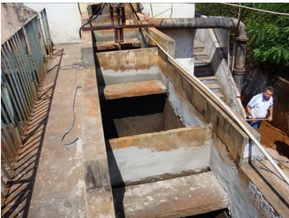
Figura 19. Registro fotográfico da situação atual da ETA de Ibitinga
