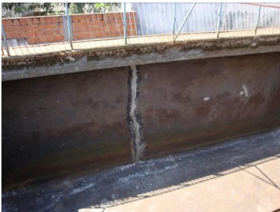
Figura 17. Registro fotográfico da situação atual da ETA de Ibitinga
