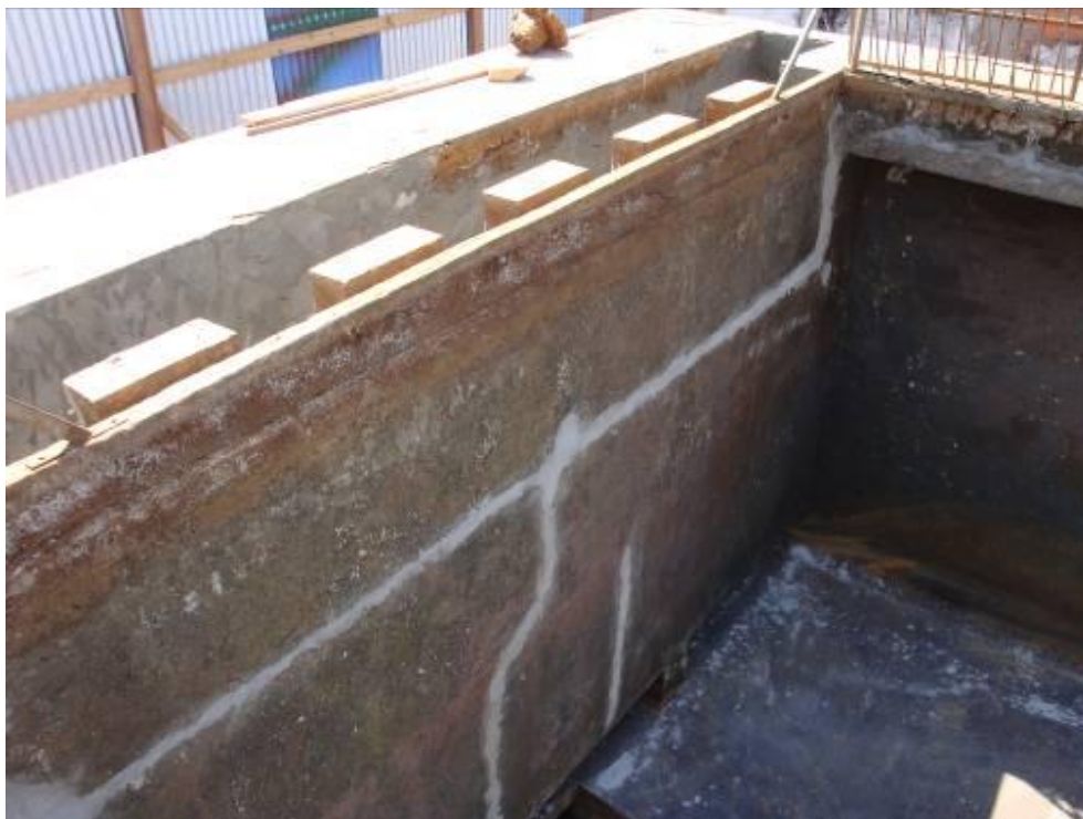
Figura 16. Registro fotográfico da situação atual da ETA de Ibitinga
