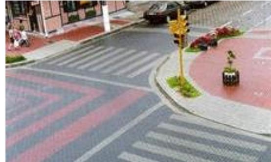
*Figura 120 - Modelo de pisos intertravados. Fonte: Polo Planejamento*
