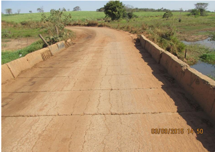
Figuras 49 e 50 – Ponte de concreto sobre o Ribeirão Doce, app não vegetada. Dimensões 12,00m x 4,00m x 4,00m.
