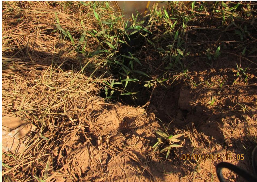
Figura 53 – Tubulação de 600mm de concreto.
