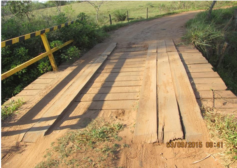
Figuras 22 e 23 – Ponte de madeira sobre o Ribeirão claro, a montante vegetada. Dimensões 5,30m x 3,50m x 2,10m.
