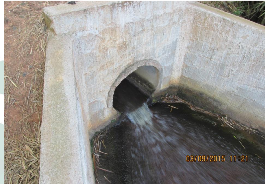
Figuras 39 e 40 – Tubulação de 400 mm de concreto e tubo de 1000mm de concreto, app parcialmente vegetada.
