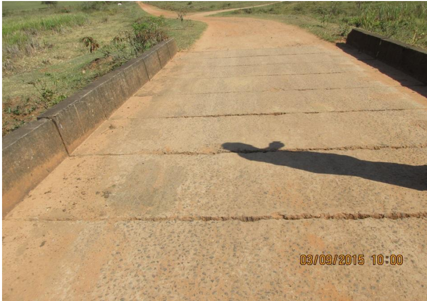
Figuras 33 e 34 – Ponte de concreto sobre o Córrego do areião, app pouco vegetada. Dimensões 8,00m x 4,00m x 3,60m.
