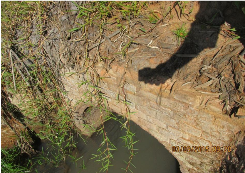
Figuras 28 e 29 - Duas tubulações de 1000mm de concreto com app bem vegetada.
