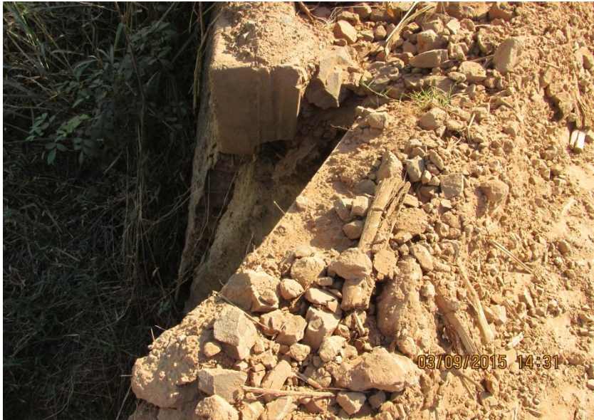
Figuras 47 e 48 – Ponte de concreto danificada, app não vegetada. Dimensões 10,00m x 4,00m x 4,00m.
