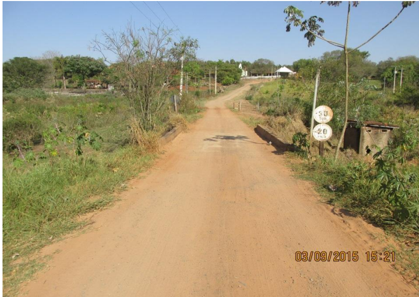
Figuras 56 e 57 – Ponte de concreto pouco vegetada a montante. Dimensões 8,00m x 4,00 x 3,60m.
