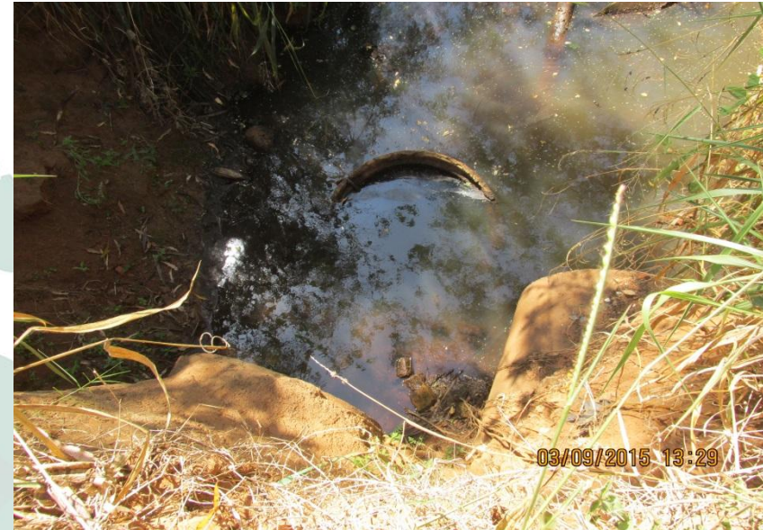
Figuras 43 e 44 – Tubulação não visível e dois tubos de 1500mm de concreto. App parcialmente vegetada.
