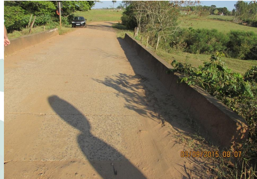
Figuras 18 e 19 – Ponte de concreto, vegetada a montante e pouco vegetada a jusante. Dimensões 12,00m x 4,00m x 4,00.
