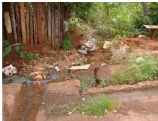
Foto 13 e 14 – Cruzamento da Rua Erasmo Moraes com Av. Areia Branca - Ponto de inundação e início de erosão sendo propicio ao seu aumento e deficiência no sistema de drenagem
