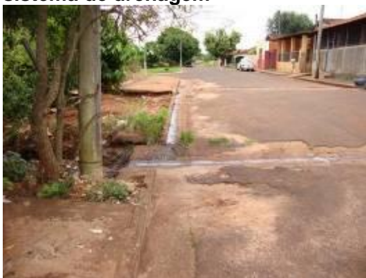
Foto 13 e 14 – Cruzamento da Rua Erasmo Moraes com Av. Areia Branca - Ponto de inundação e início de erosão sendo propicio ao seu aumento e deficiência no sistema de drenagem
