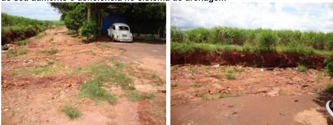
Foto 5 e 6 - Final da Rua Aurora Lourenço Leite - Início de erosão sendo propício ao seu aumento e deficiência no sistema de drenagem
