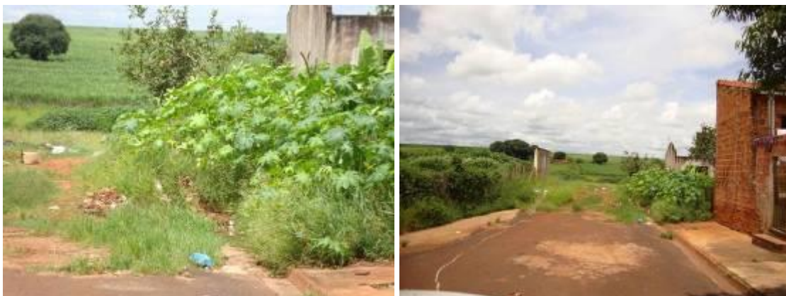
Foto 5 e 6 - Final da Rua Aurora Lourenço Leite - Início de erosão sendo propício ao seu aumento e deficiência no sistema de drenagem
