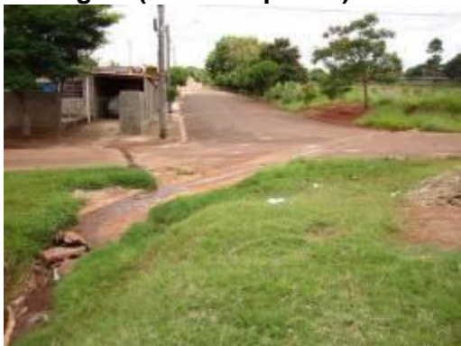
Foto 9 e 10 – Final da Rua Daniel Morante - Passagem inadequada do sistema de drenagem (meio da quadra) e Acumulo de Dejetos/Entulhos
