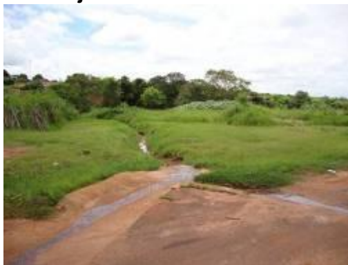
Foto 9 e 10 – Final da Rua Daniel Morante - Passagem inadequada do sistema de drenagem (meio da quadra) e Acumulo de Dejetos/Entulhos
