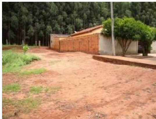
Foto 1 e 2 – Final da Rua João Vitagliano - Início de erosão sendo propicio ao seu aumento e carreamento de terra
