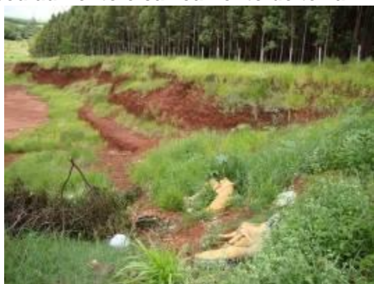
Foto 1 e 2 – Final da Rua João Vitagliano - Início de erosão sendo propicio ao seu aumento e carreamento de terra
