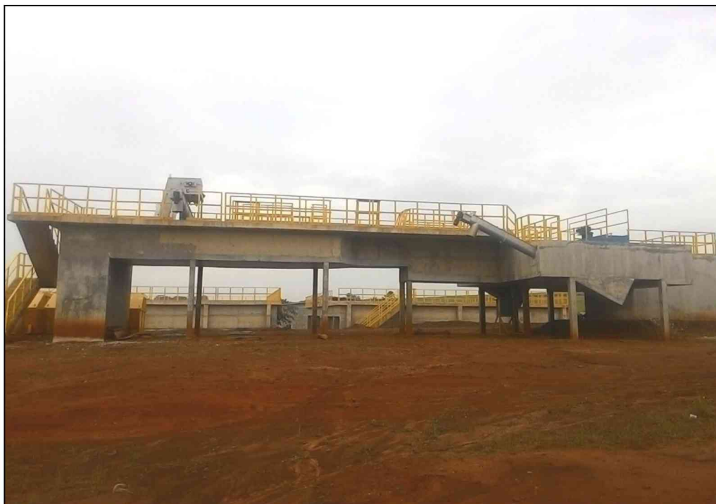
Fotografia 46 - Tratamento preliminar – ETE Barra Bonita.
