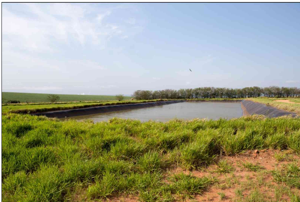
Fotografia 87 - Vista da lagoa de drenagem de chorume.
