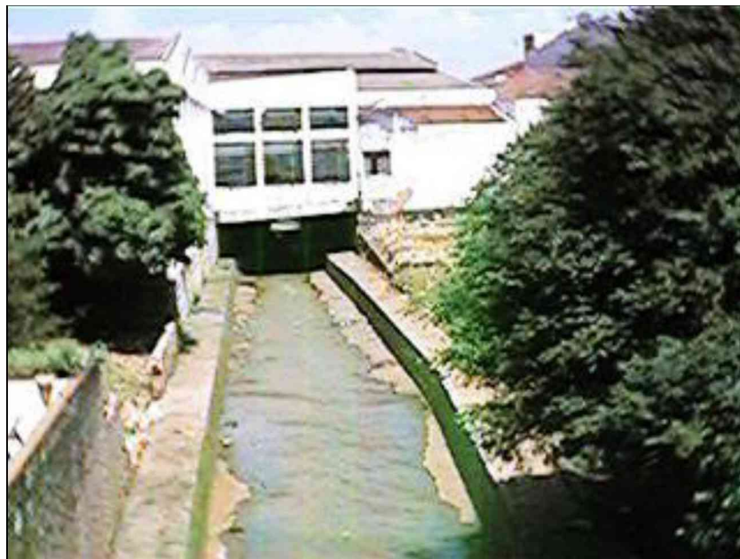
Fotografia 58 - Edificação construída sobre o canal do córrego Barra Bonita.
