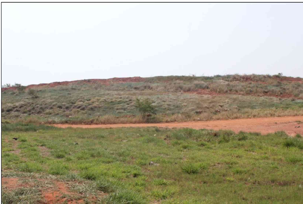
Fotografia 88 - Vista das duas células finalizadas.
