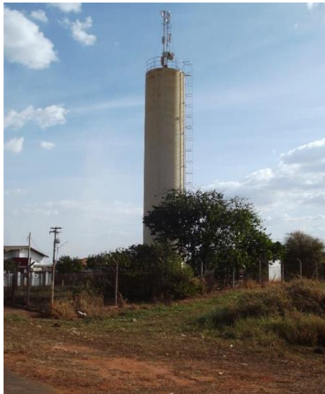
Foto 6.14 – Reservatório Águas do Vale
