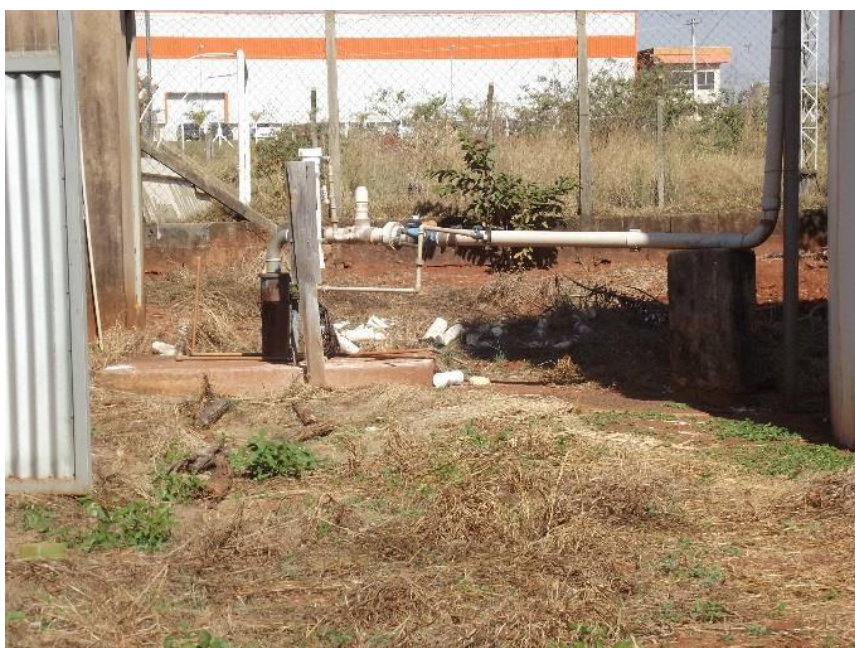
Foto 6.15 – Poço Pq. Imperial
