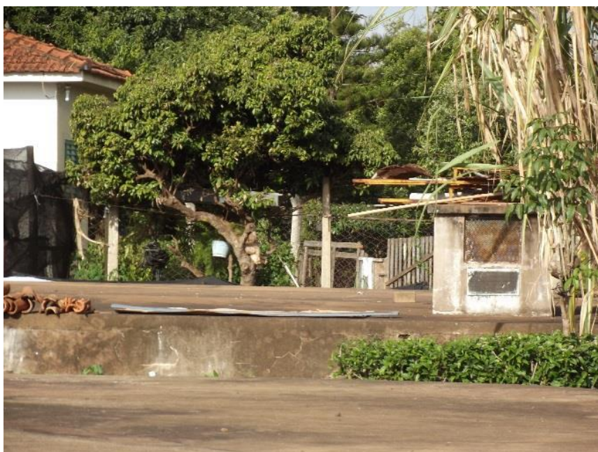
Foto 6.11 – Reservatório Jd. Bela Vista II
