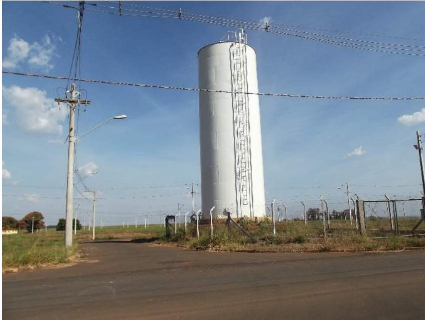
Foto 6.3 – Reservatório Maria Luiza
