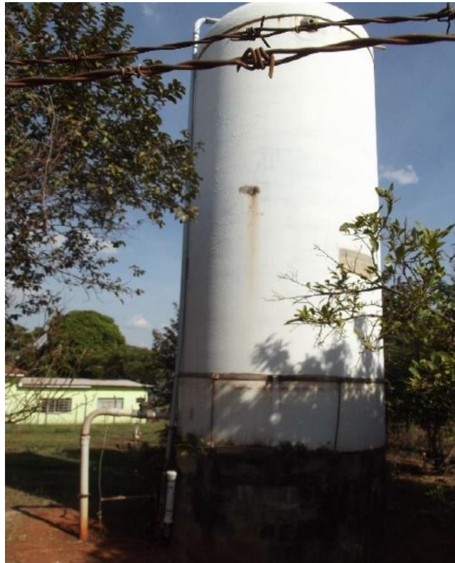
Foto 6.4 – Reservatório Distrito Industrial
