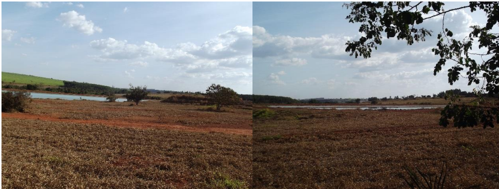
Foto 6.36 – Lagoa Facultativa da Estação de Tratamento
