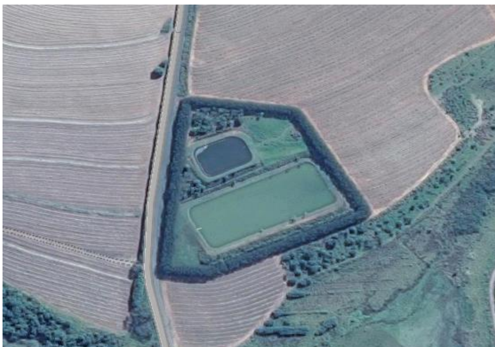
Foto 6.37 – Sistema Australiano de Tratamento de Esgotos de Curupá
