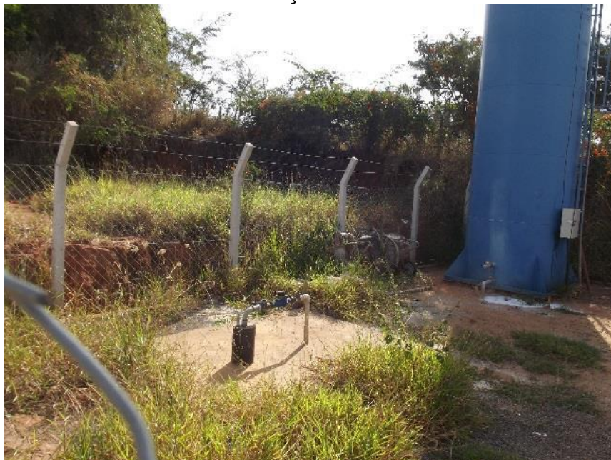
Foto 6.20 – Poço Av. Saudades
