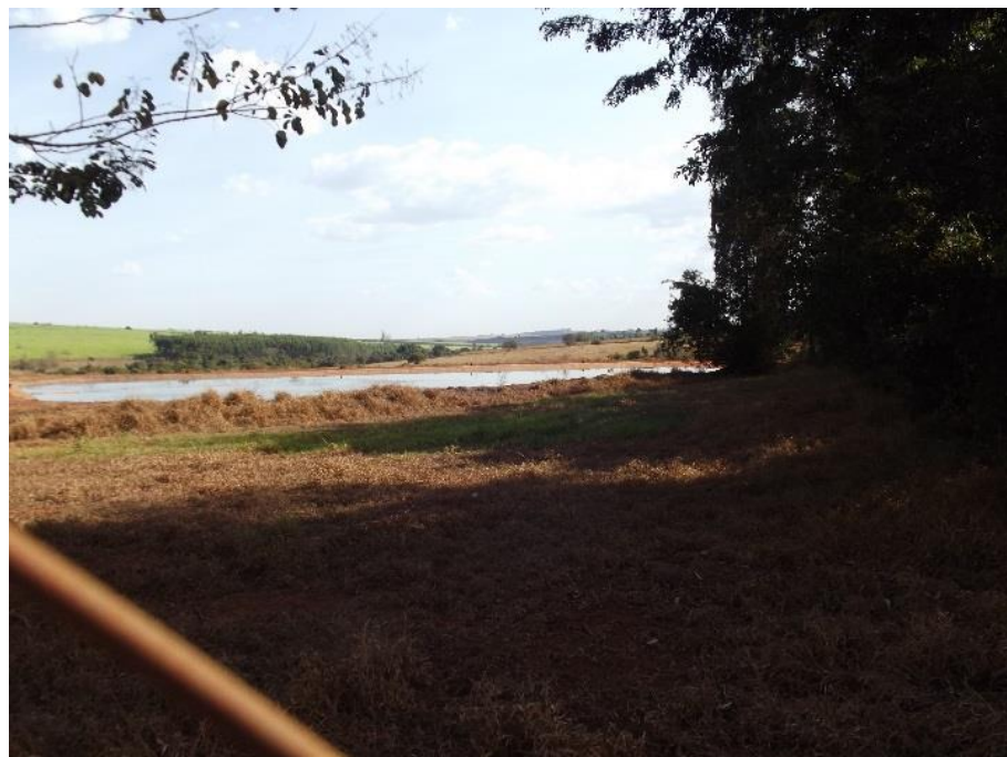
Foto 6.35 – Lagoa Anaeróbica da Estação de Tratamento
