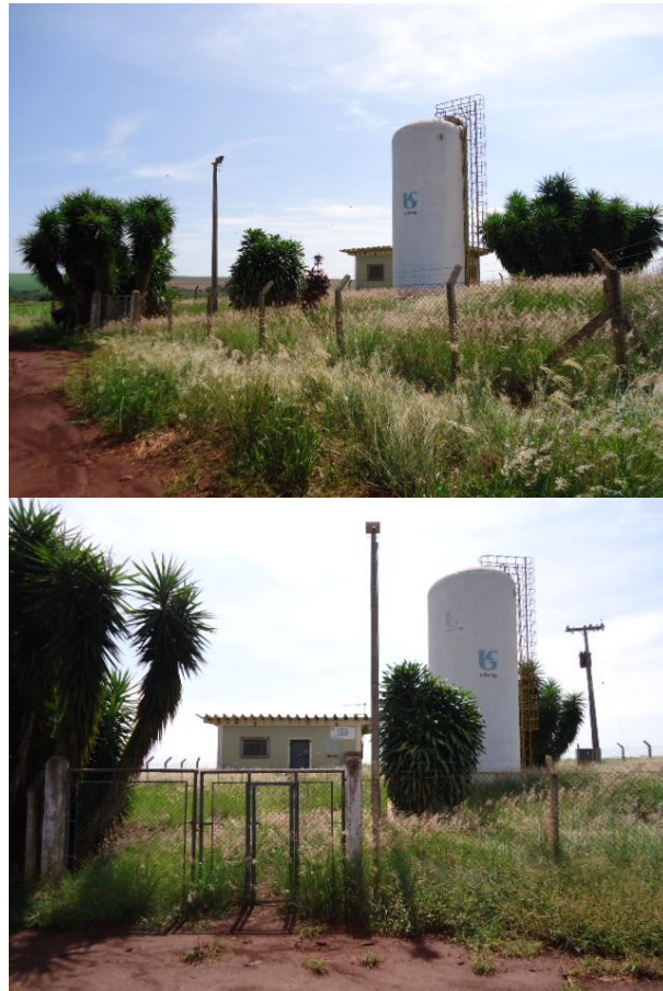
Figura 23.16 – Poço e reservatório – Distrito Vanglória Fonte: Sabesp
