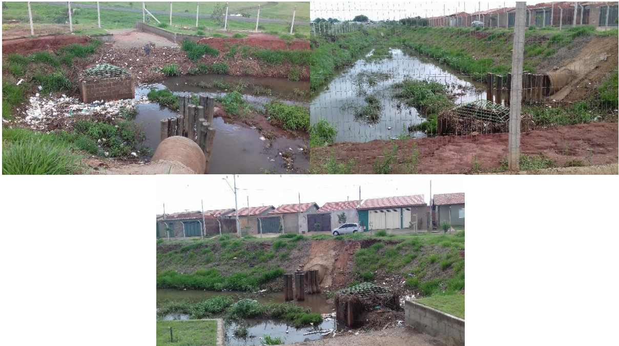
Figura 25.13 – Bacia de detenção próxima à Rua Maria Antônia Pereira Tincani – alagamento esporádico.
