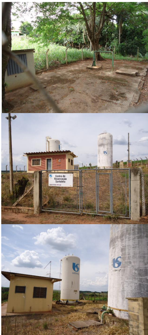
Figura 23.15 – Poço e reservatórios – Santelmo. Fonte: Líder Engenharia.
