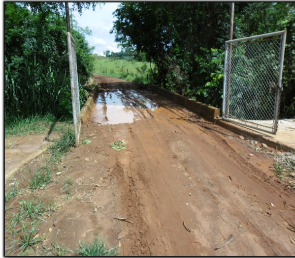
Figura 133. Galeria 7 – Ponte sobre o Rio Itaquerê
