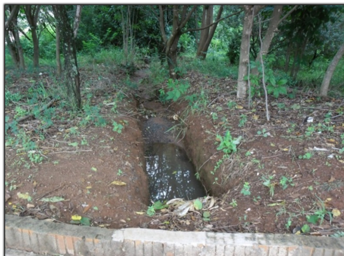
Figura 100. Lançamento auxiliar – Rua dos Antúrios – APP Córrego Nova Europa
