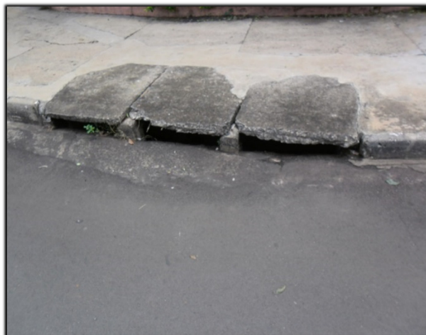
Figura 140. Galeria 8 – Ramal Aureliano - boca de lobo tripla de guia.
