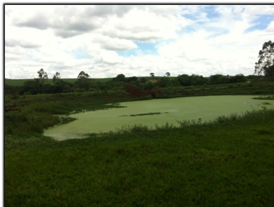
Figura 67. Lagoa anaeróbia "A"
