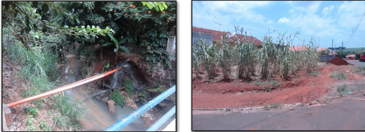
Figura 10. Construções próximas às margens da ponte Francisco Meditieri e cultivo de cana-de-açúcar em terreno na área urbana
