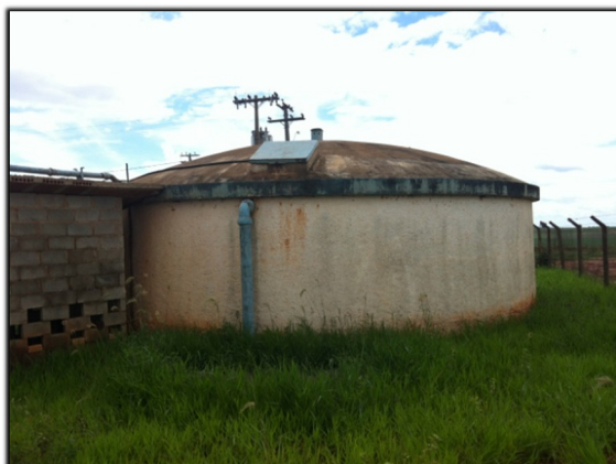
Figura 31. Reservatório apoiado de concreto (200 m 3 )
