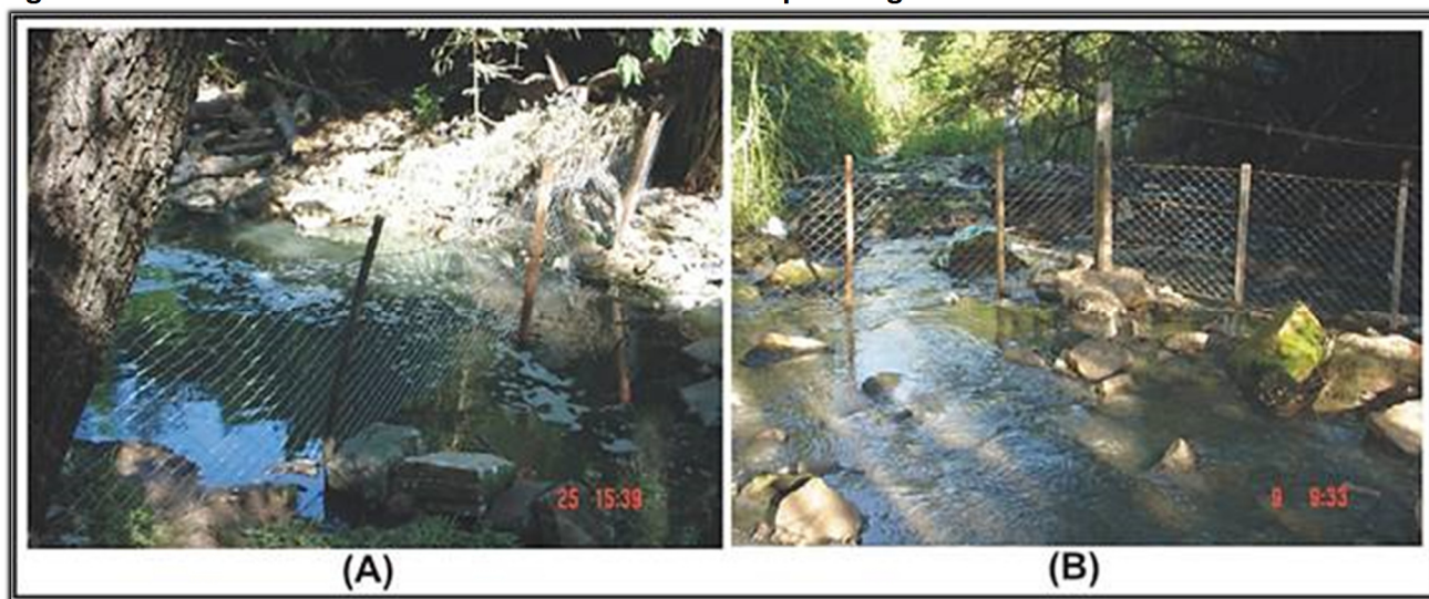
Figura 247. Redes coletoras de resíduos sólidos em corpos d'água
