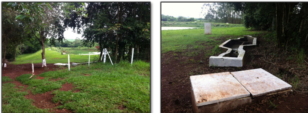
Figura 178. Vista da ETE e tratamento preliminar
