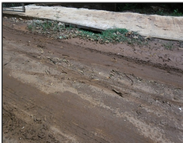
Figura 135. Galeria 7 – Captação auxiliar – via sem pavimentação.
