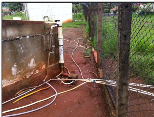
Figura 50. Sistema de dosagem
