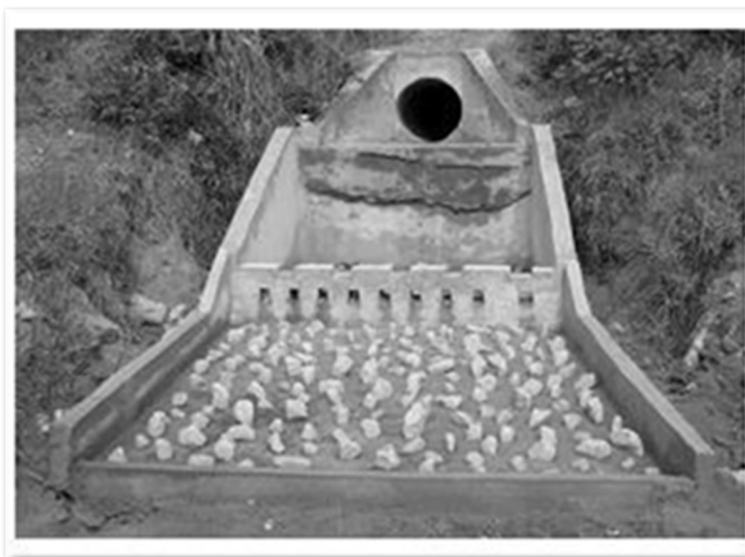
Figura 245. Exemplo de enrocamento simples com pedra espalhada
