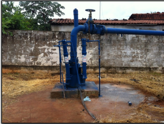
Figura 40. Sistema de dosagem no Jd. São Roque
