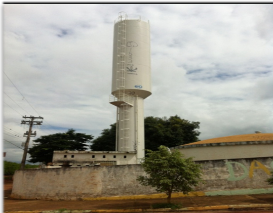
Figura 26. Reservatório elevado metálico (110 m 3 ) e sua elevatória
