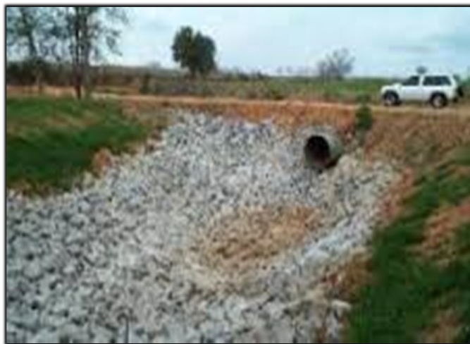
Figura 243. Exemplo de enrrocamento simples com pedra espalhada
