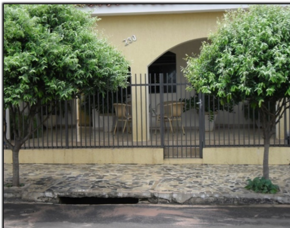
Figura 146. Galeria 8 – Ramal 12 de Janeiro – boca de lobo simples de guia
