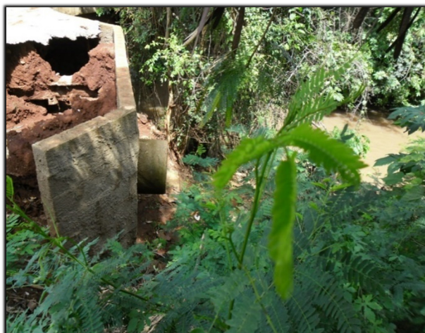
Figura 136. Galeria 7 – Lançamento no Itaquerê da captação auxiliar – via sem pavimentação.
