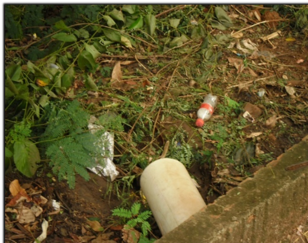
Figura 122. Galeria 6 – Lançamento 6 – PL6/CNE
