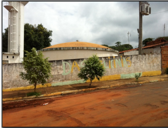
Figura 24. Reservatório apoiado de concreto (200 m 3 )
