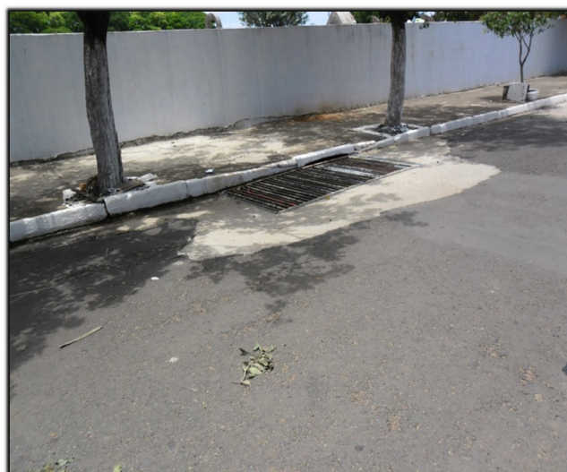
Figura 145. Galeria 8 – Ramal 12 de Janeiro – boca de lobo simples de grelha
