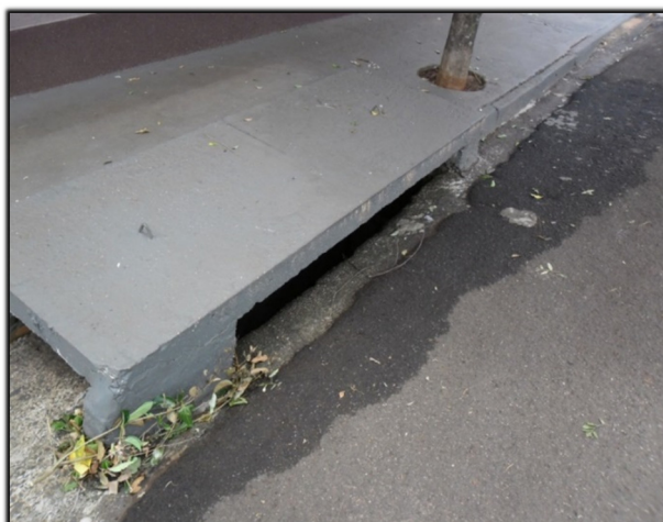
Figura 119. Galeria 6 – boca de lobo “dupla” de guia – a esquerda da condução
