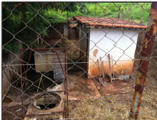
Figura 61. Estação elevatória de esgotos
