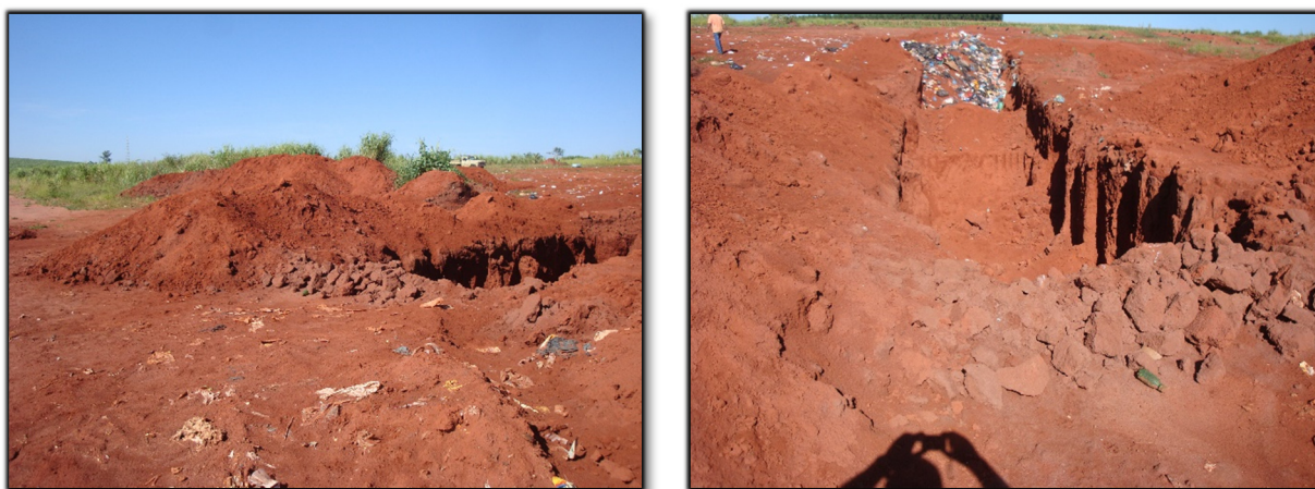
Figura 170. Aterro Sanitário em Valas.
