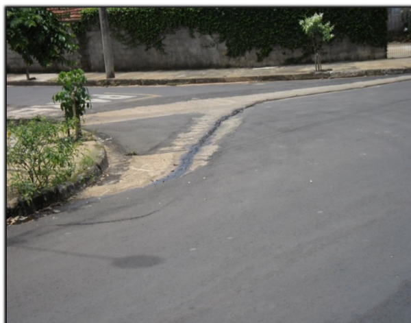
Figura 141. Galeria 8 – Ramal Aureliano – sarjetões.
