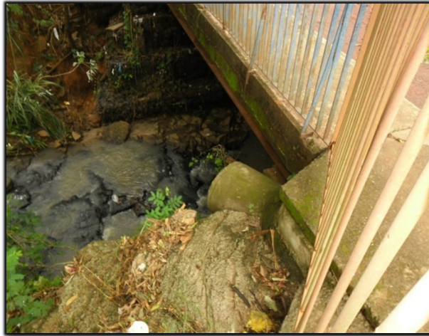
Figura 124. Captação da Rua Júlio Cardilli – cabeceira da ponte sobre o Córrego Nova Europa
