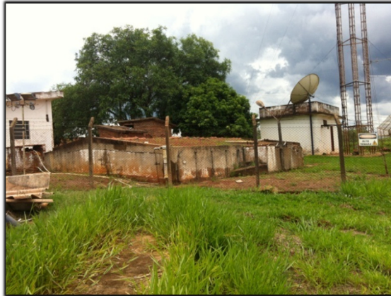
Figura 36. Reservatório semi-enterrado alvenaria (150 m 3 ) - DESATIVADO
