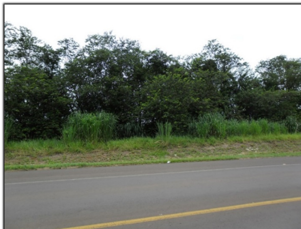
Figura 104. Galeria 2 – Área de travessia da Galeria 2 – sob a Via de Acesso Ovídio Bergamim – com local de lançamento ao fundo – sem acesso.
