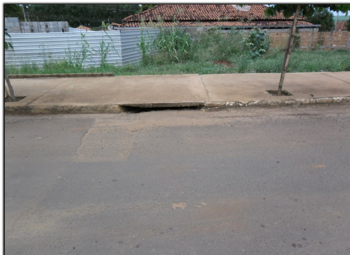
Figura 153. Galeria 9 – boca de lobo simples de guia
