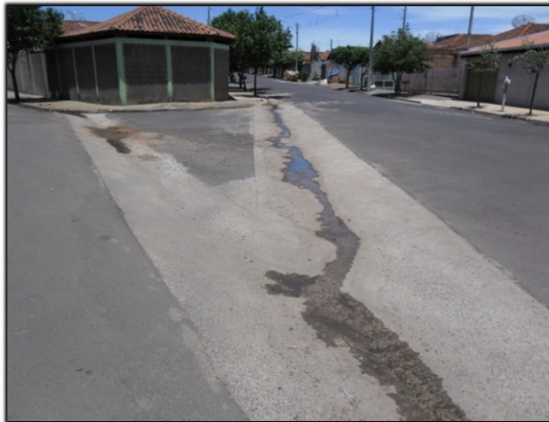
Figura 102. Galeria 2 – Sarjetões de encaminhamento das águas
