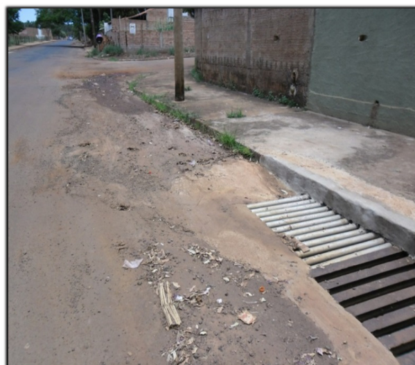
Figura 129. Galeria 7 – Boca de lobo dupla de grelhas
