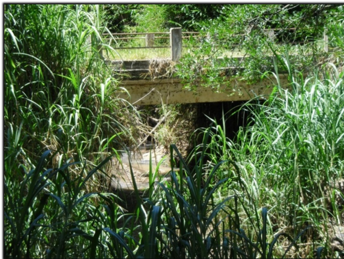
Figura 85. Vista lateral da ponte sobre Córrego Nova Europa / Campo de futebol
