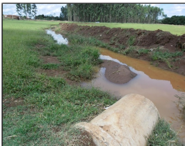
Figura 158. Bloco III – Galeria 9 – Ponto de lançamento
