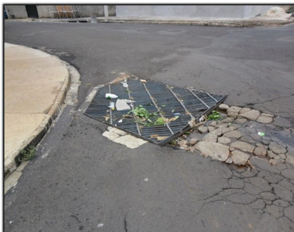
Figura 118. Galeria 6 – boca de lobo de grelha
