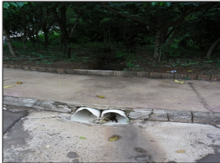
Figura 99. Captação complementar – Rua dos Antúrios
