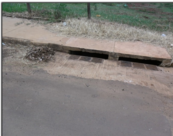
Figura 148. Galeria 8 – Ramal 12 de Janeiro – boca de lobo dupla de guia
