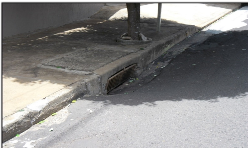
Figura 114. Galeria 5 - Boca de lobo de guia simples
