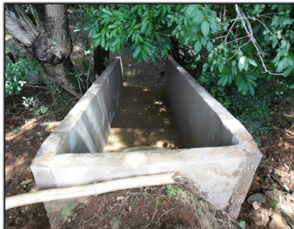
Figura 150. Galeria 8 – dissipador de energia - carga
