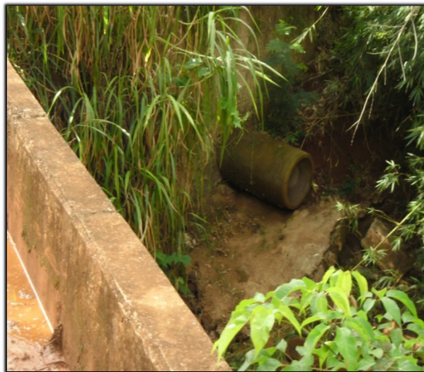
Figura 134. Galeria 7 – Lançamento Rio Itaquerê.
