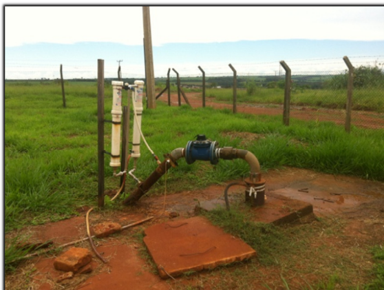
Figura 40. Sistema de dosagem no Jd. São Roque
