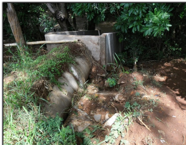
Figura 151. Galeria 8 – dissipador de energia - descarga
