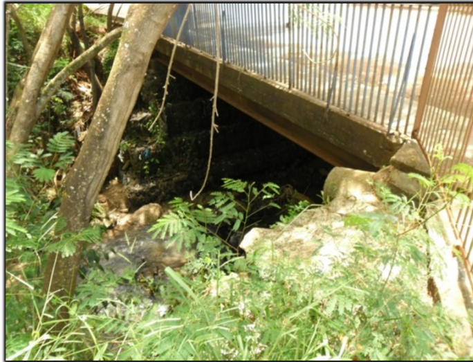
Figura 86. Vista lateral da ponte e canal do Córrego Nova Europa com a Rua das Violetas
