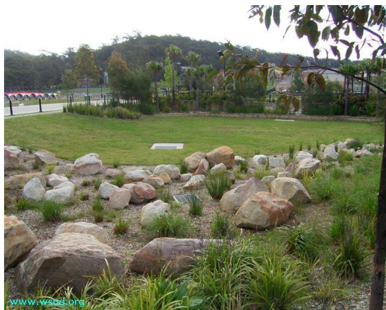
FIGURA 15- 15: BACIA DE BIO-RETENÇÃO – WSUD
