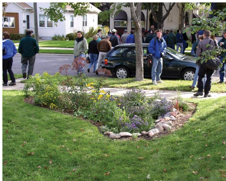
FIGURA 15- 13: BACIA DE BIO-RETENÇÃO EM ÁREA PÚBLICA (JARDIM DE CHUVA)
