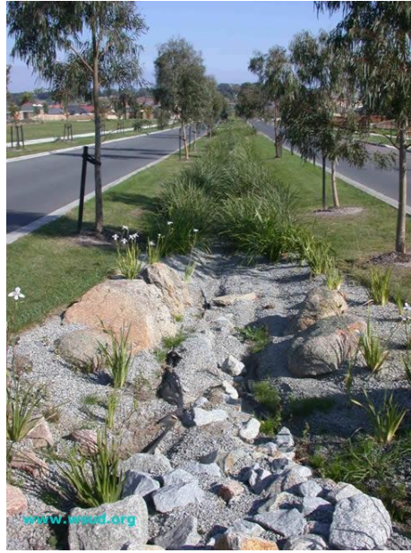
FIGURA 15- 4: TRINCHEIRA DE INFILTRAÇÃO EM CANTEIRO CENTRAL – WSUD
