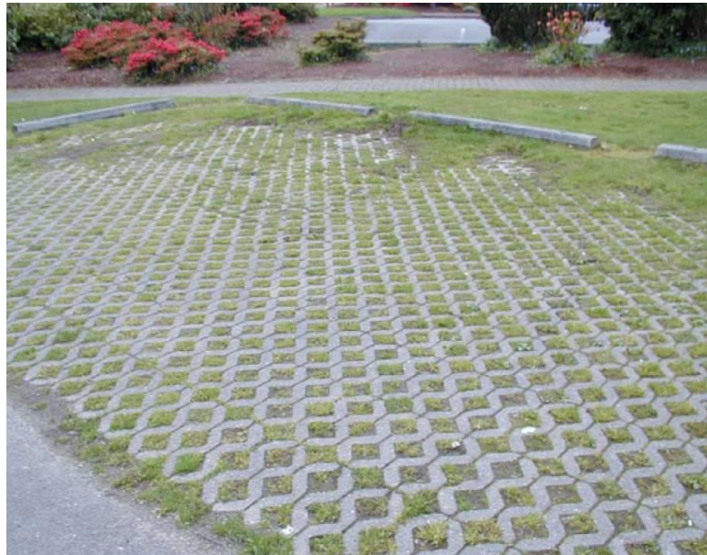
FIGURA 15- 8: PAVIMENTO PERMEÁVEL EM ESTACIONAMENTO
