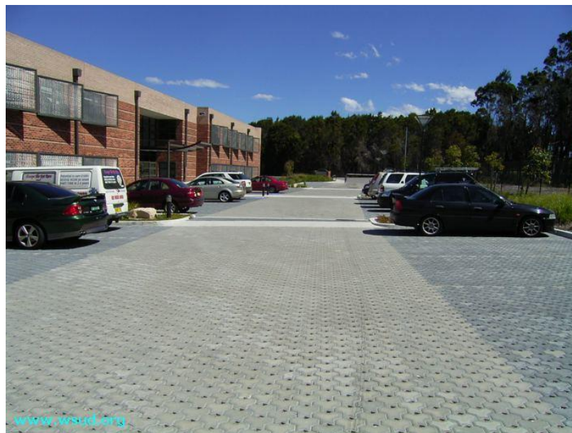
FIGURA 15- 9: PAVIMENTO PERMEÁVEL – WSUD
