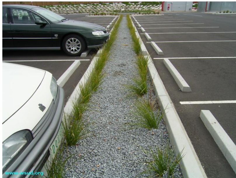
FIGURA 15- 3: TRINCHEIRA DE INFILTRAÇÃO EM ESTACIONAMENTO – WSUD 21
