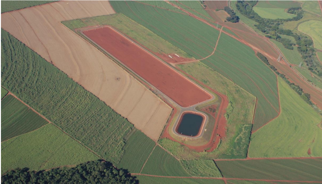
FIGURA 6- 8: IMAGEM AÉREA DA ETE DURANTE A CONSTRUÇÃO
