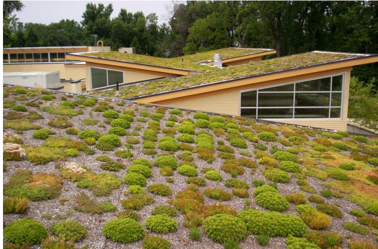
FIGURA 15- 18: TELHADO VERDE COM PLANTAS SUCULENTAS
