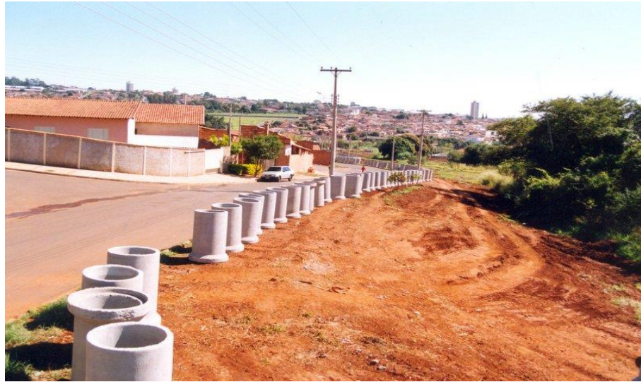
FIGURA 6- 4: INSTALAÇÃO DE INTERCEPTOR DO CÓRREGO CACHOEIRINHA
