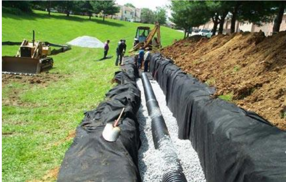
FIGURA 15- 2: CONSTRUÇÃO DE TRINCHEIRA DE INFILTRAÇÃO
