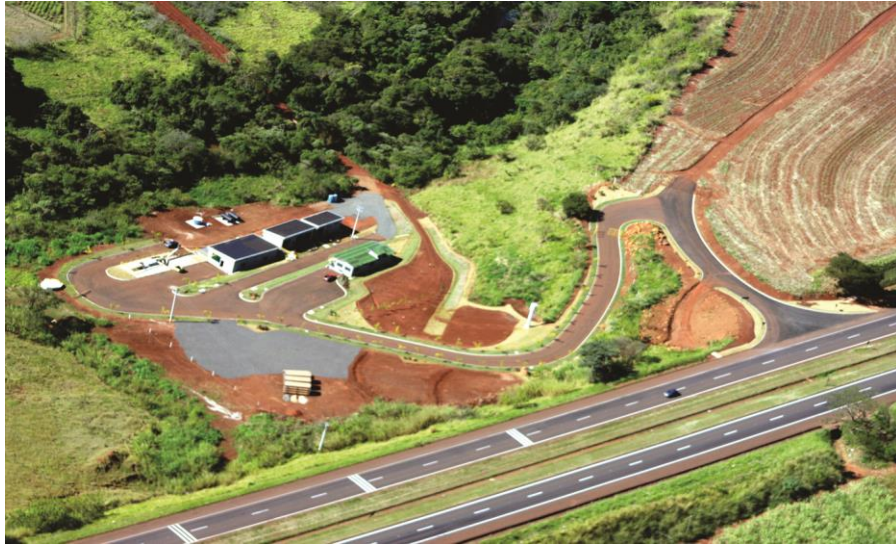
FIGURA 6- 5: INSTALAÇÕES DO TRATAMENTO PRIMÁRIO E ESTAÇÃO ELEVATÓRIA DE ESGOTO
