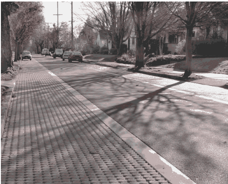
FIGURA 15- 11: PAVIMENTO PERMEÁVEL EM FAIXAS DE ESTACIONAMENTO – CIDADE DE SEATTLE - EUA
