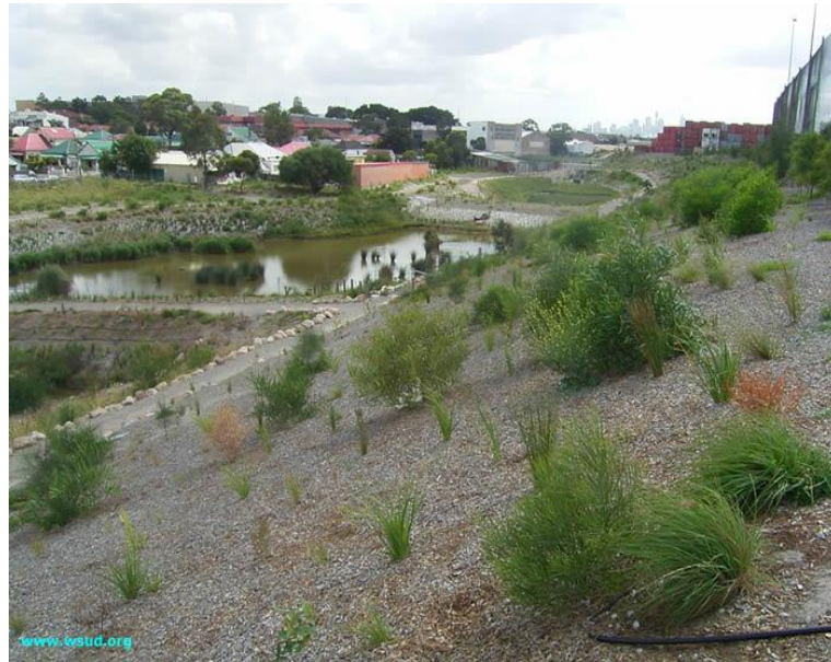
FIGURA 15- 16: LAGOAS DE BIO-RETENÇÃO (ALAGADOS) - WSUD
