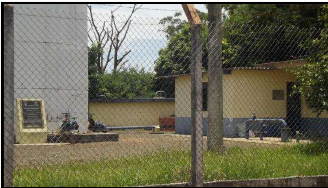
Figura 3 - Reservatório 1 e Poço 01– Rua 5- Vila Garbi
