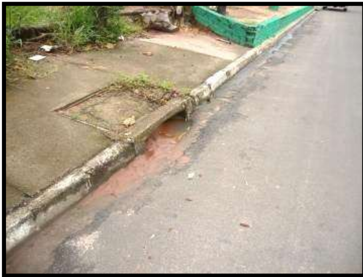
Figura 77 - Boca de lobo presente no local
