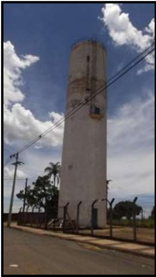
Figura 14 - Reservatório 03 Avenida Perimetral
