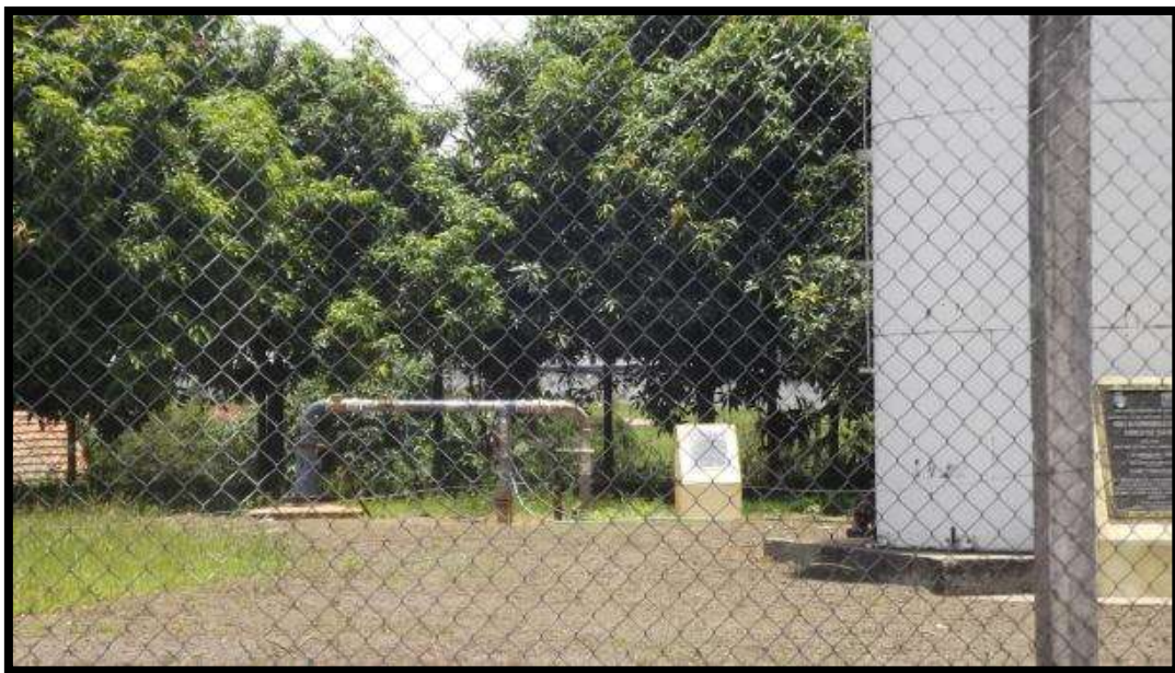
Figura 5 - Poço 02 e Reservatório 4 – Rua 5- Vila Garbi
