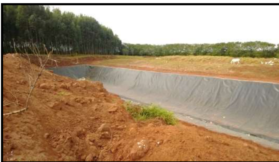
Figura 56 - Vala com Manta PEAD no Aterro em Valas de Itirapina-SP
