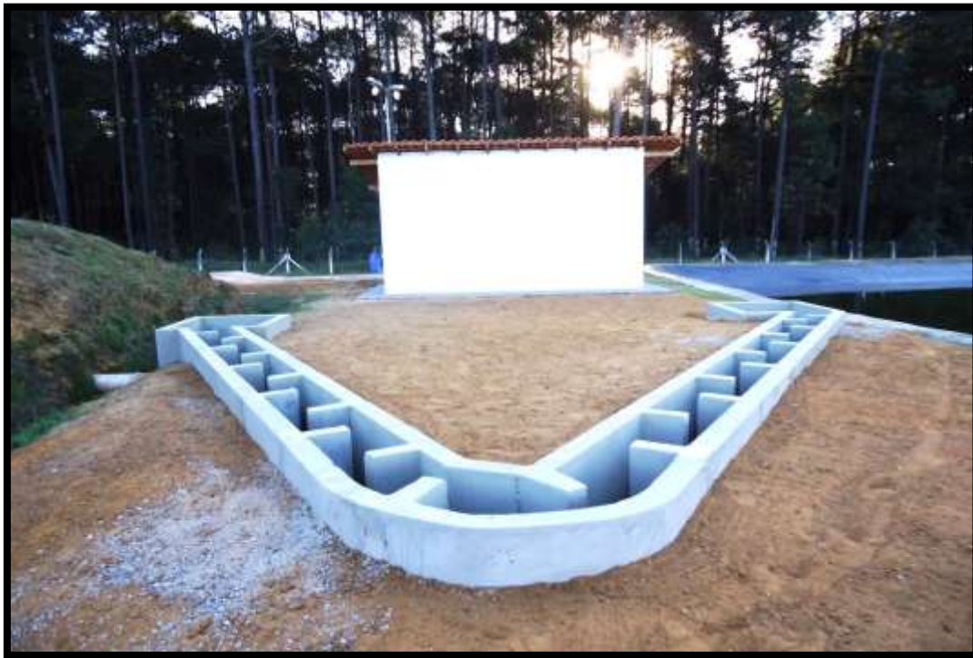
Figura 28 – Tratamento terciário utilizado para a redução de fósforo presente no efluente
