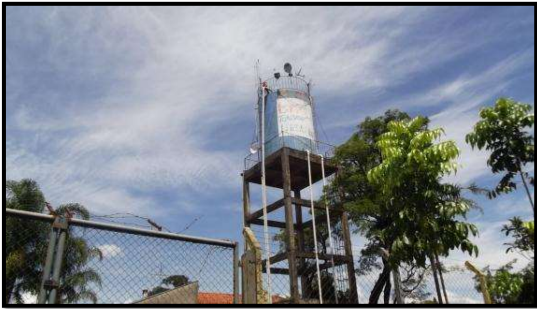
Figura 16 - Reservatório 6 - Rua 13, Balneário Santo Antônio
