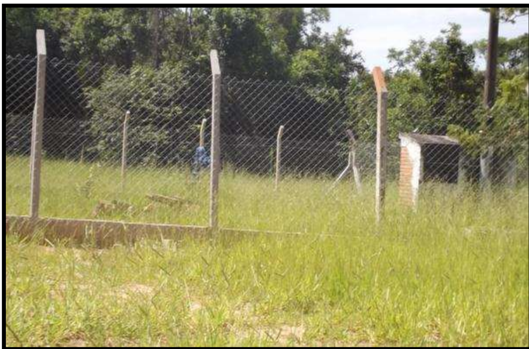
Figura 7 - Poço 06 - Rua 05, Estância Ubá
