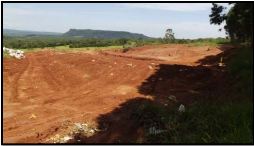
Figura 51 - Vista do Aterro em Valas – Itirapina-SP
