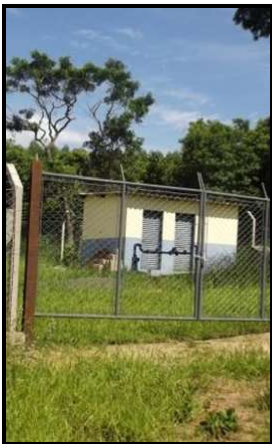
Figura 9 - Poço 08 - Rua 3, Estância Ubá
