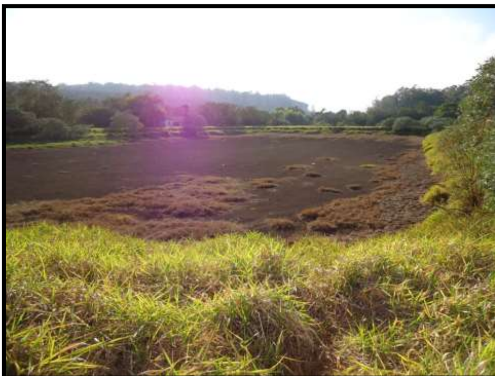
Figura 21 – Antiga ETE desativada.
