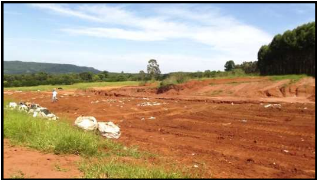
Figura 52 - Vista do Aterro em Valas – Itirapina-SP
