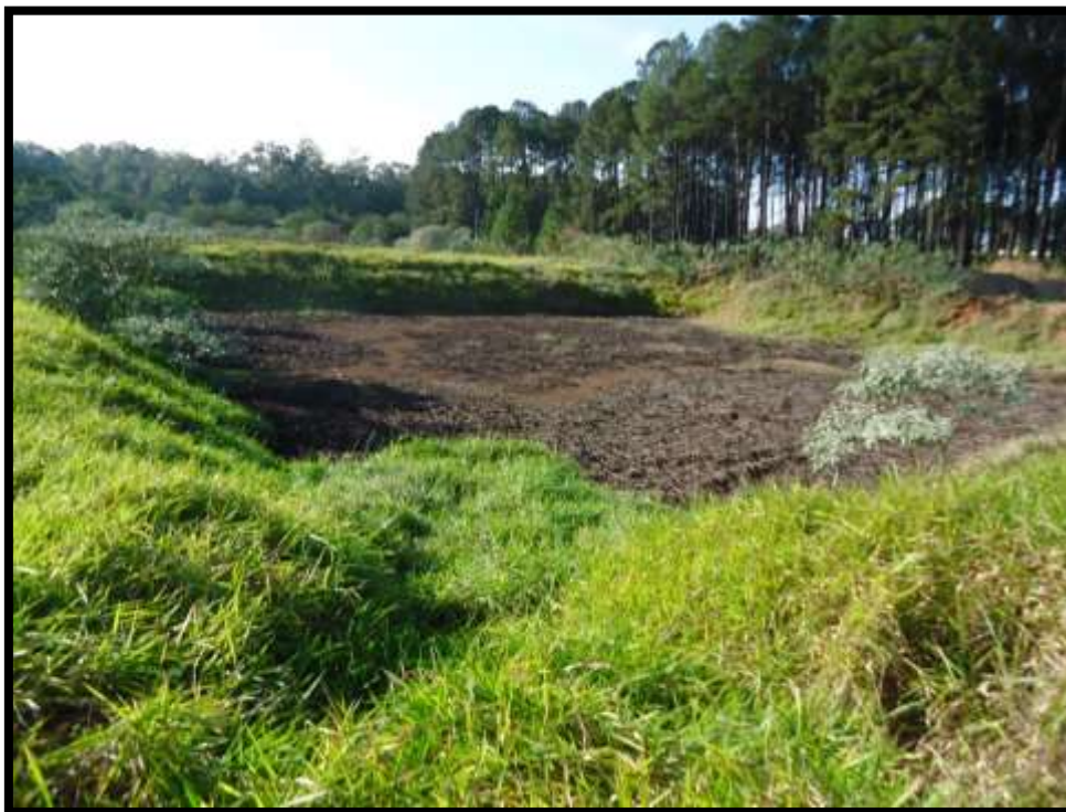
Figura 20 – Antiga ETE desativada.
