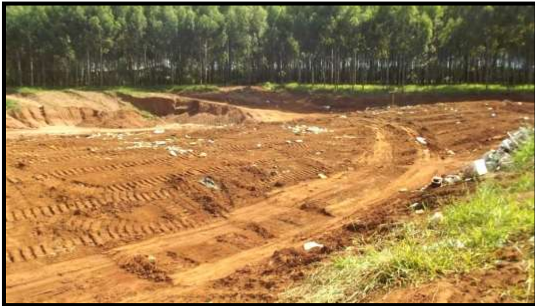
Figura 53 - Vista do Aterro em Valas - Itirapina-SP
