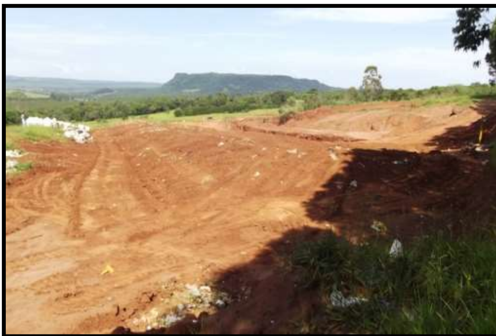
Figura 50 - Vista do Aterro em Valas – Itirapina-SP
