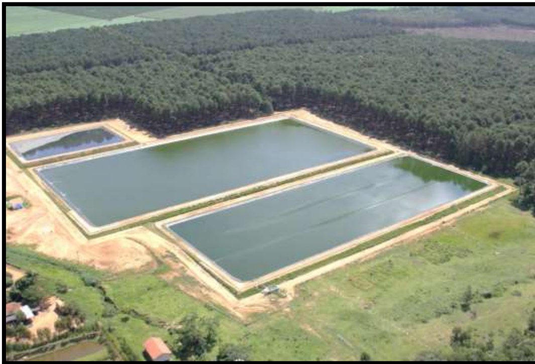
Figura 22 - Vista Aérea das lagoas de tratamento
