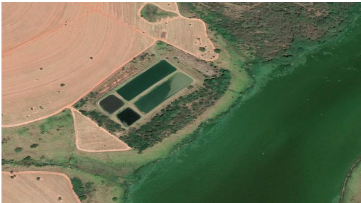
Imagem 21 – Imagem área da ETE de Jacanga / Fonte: Google Earth
