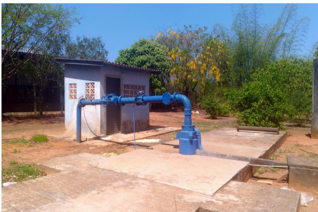
Imagem 4 – Poço Avenida Perimetral (P2)
