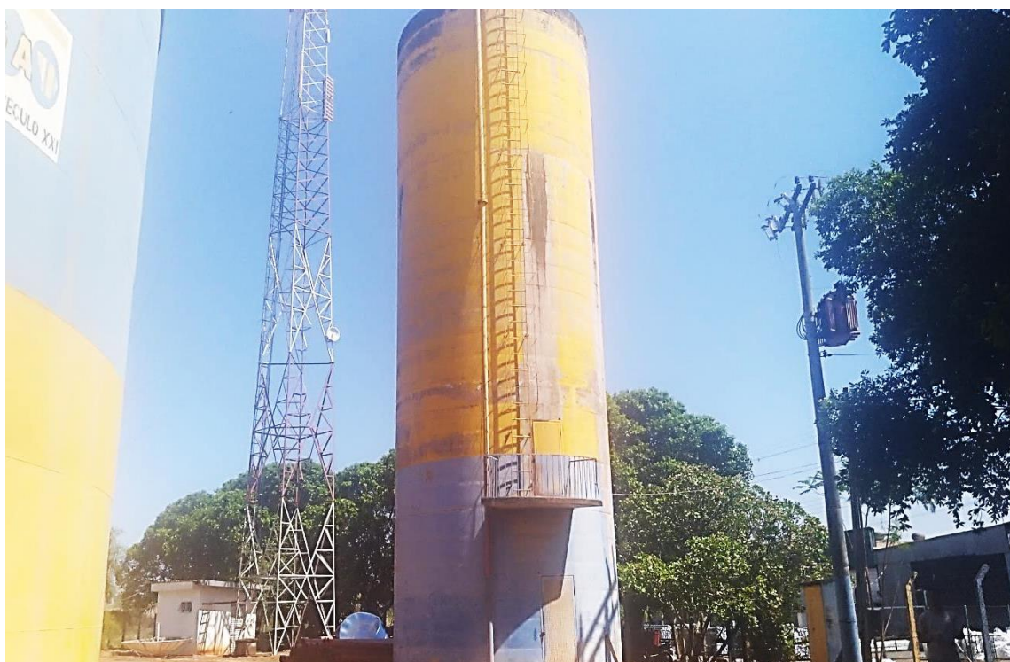
Imagem 11 – Reservatório Avenida Perimetral (R2)
