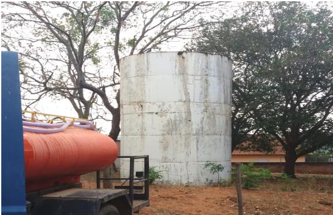
Imagem 19 – Reservatório Vale das Águas (R10)
