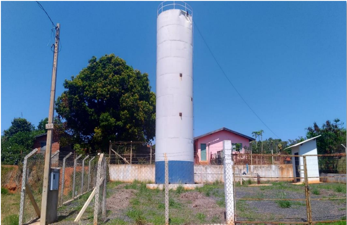
Imagem 16 – Reservatório São Judas Tadeu 2 (R7)
