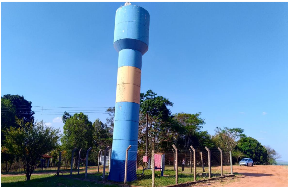
Imagem 13 – Reservatório Quilombo (R4)
