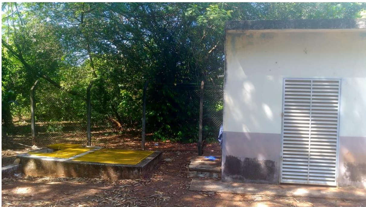
Imagem 22 – Estação Elevatória de Esgoto 1
