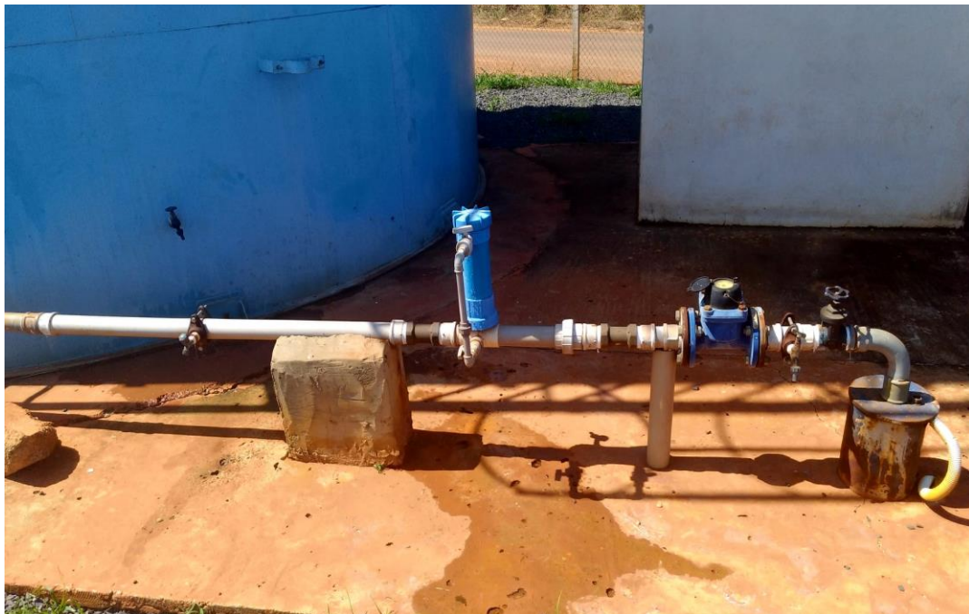
Imagem 9 – Poço da Rua Antônio Modulo (P7)
