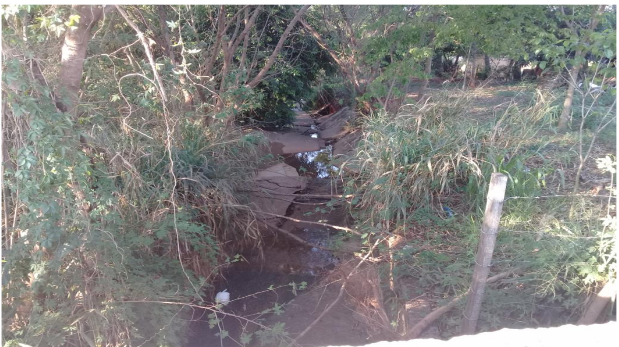
Imagem 31 – Ponto crítico 1: Rua Abílio Ticianeli (Trecho entre a Av. Laemert Garcia dos Santos até a Rua 9 de Julho)
