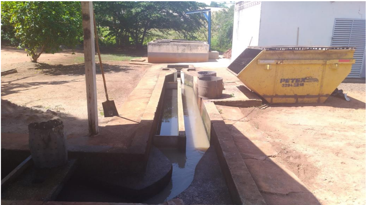
Imagem 25 – Sistema preliminar (caixa de areia e calha parshall)
