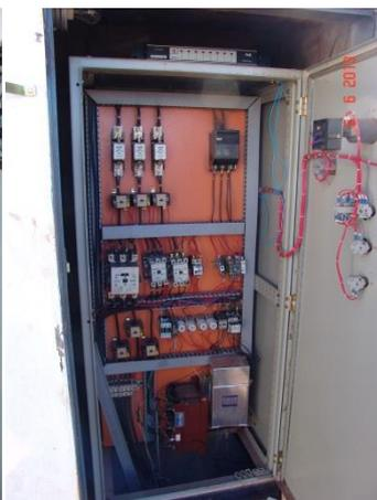
Foto 9-6: Painel elétrico da bomba do poço P2
