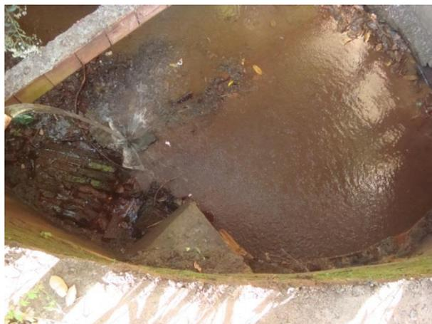
**Foto 12-6:** Ponto de Lançamento da Galeria Alameda Azzolino com tubulação de concreto 600 mm
