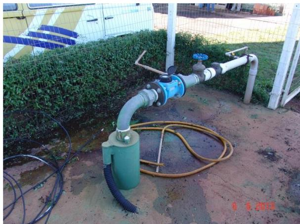
Foto 9-4: Tubulação de saída do poço P3, com tubo guia para medidor de nível da água e hidrômetro
