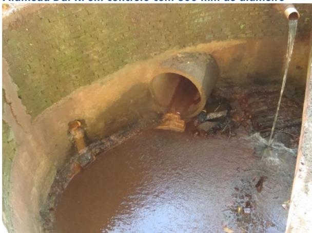
**Foto 12-5:** Ponto de Lançamento da Galeria Alameda Azzolino com tubulação de concreto 600 mm
