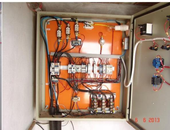
Foto 9-7: Painel elétrico da bomba do poço P3
