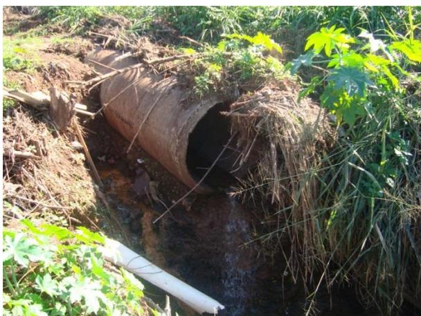
**Foto 12-14: Ponto de Lançamento da Avenida São Paulo após a travessia na Rodovia Nelson Barbieri, com tubulação de concreto de 1000 mm**
