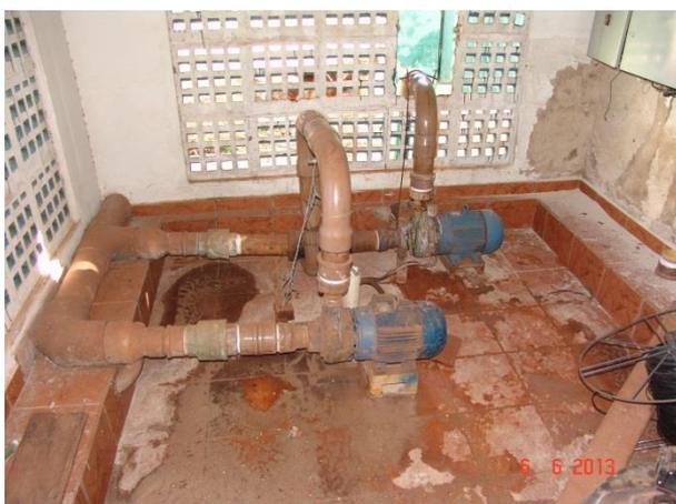
**Foto 9-12: Bombas centrífugas que transferem água tratada do R1 até o R2 e rede de distribuição**
