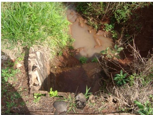
Foto 12-7: Ponto de lançamento da Galeria de Águas Pluviais da Alameda Gulla. Tubulação de Concreto 600 mm
