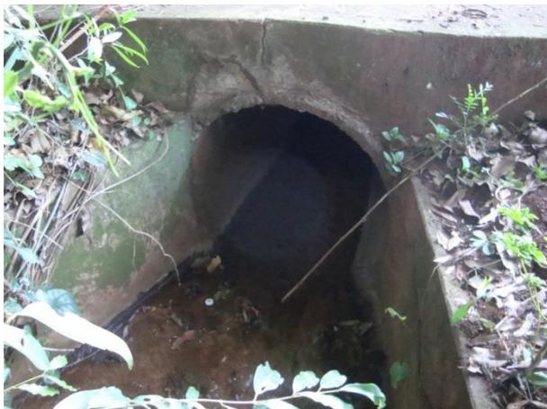
**Foto 12-3:** Ponto de Lançamento da Galeria Pluvial da Alameda Dal Ri em concreto com 600 mm de diâmetro
