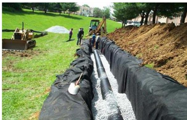
Figura 12-3: Construção de trincheira de infiltração
