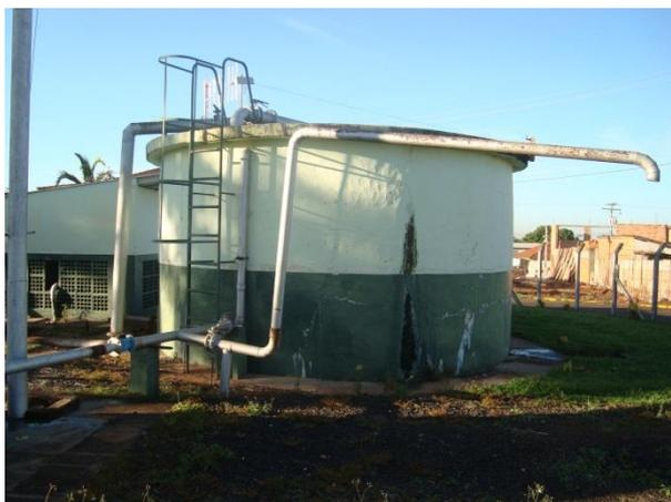
Foto 9-9: Vazamentos no reservatório R1
