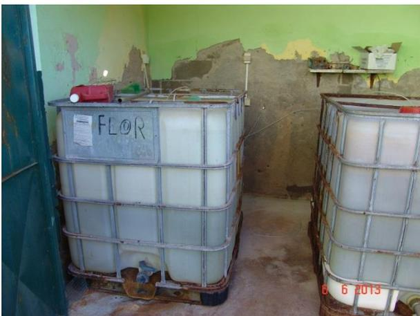
Foto 9-16: Tanques de solução de Cloro e Fluor
