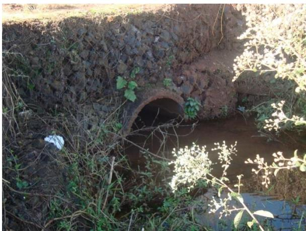
**Foto 12-1:** Travessia do Córrego Horebe sob a Estrada Municipal Leonardo da Cruz, com tubulação de concreto de 1000 mm
