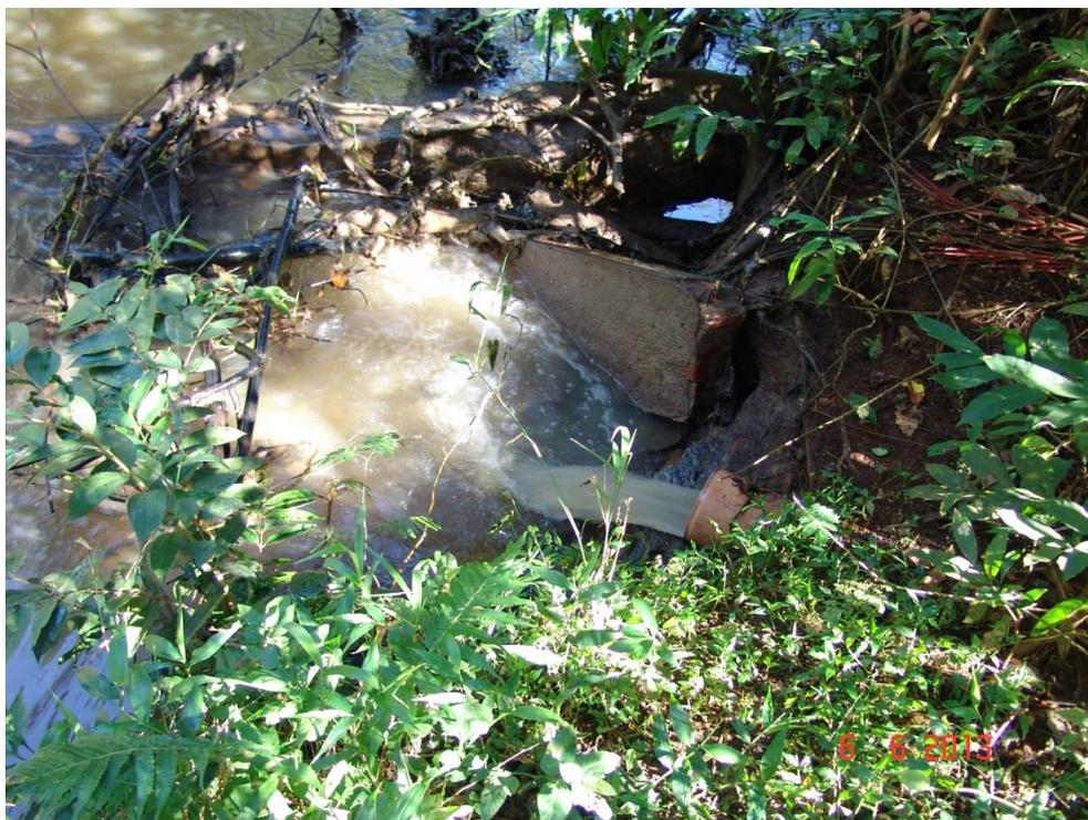
**Foto 10-3: Ponto de lançamento do esgoto "in natura" no Rio Jacaré-Guaçu**
