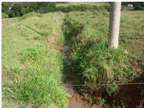
Foto 12-8: Erosão provocada pelo lançamento da galeria em terreno natural
