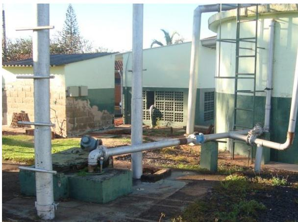
Foto 9-1: Tubulação de saída do Poço P1, com tubo guia para medidor de nível da água
