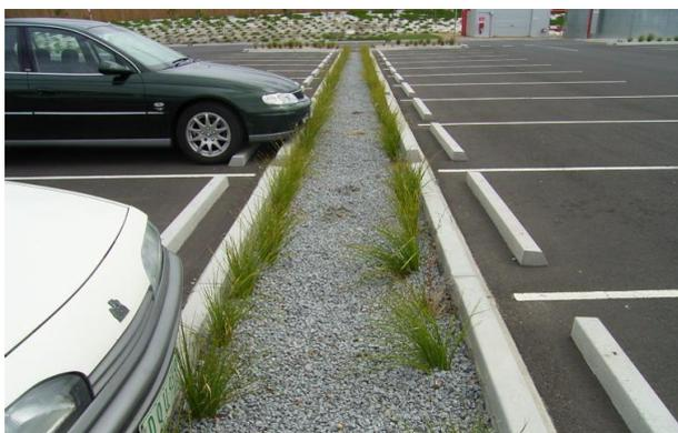
Figura 12-2: Trincheira de infiltração em estacionamento
