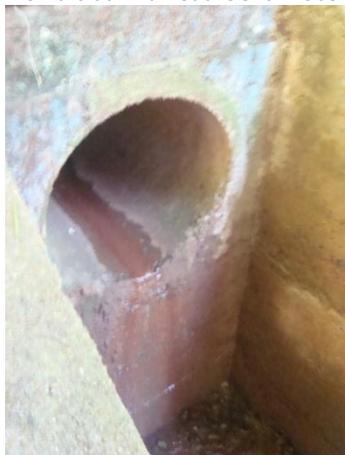
Foto 12-9: Ponto de lançamento da Alameda Picolo, com tubulação de concreto 600 mm
