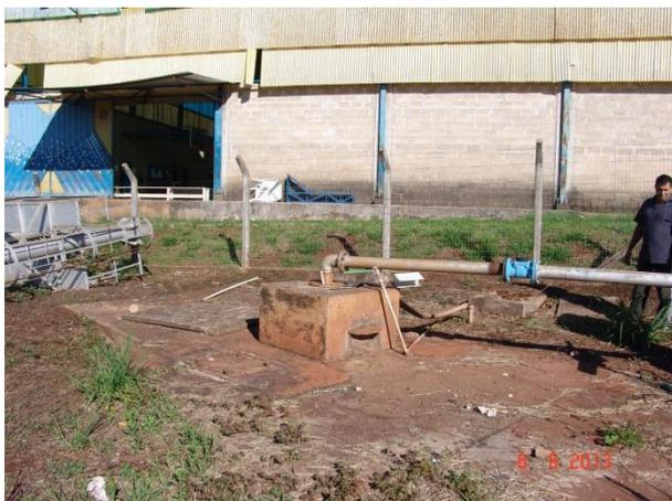
Foto 9-3: Tubulação de saída do poço P2, com tubo guia para medidor de nível da água e hidrômetro
