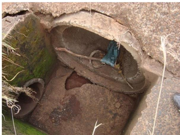
**Foto 12-11: Caixa de Captação da canaleta da rodovia Nelson Barbieri com tubulação de 800 mm de concreto**
