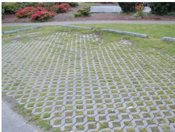
Figura 12-4: Pavimento permeável em estacionamento
