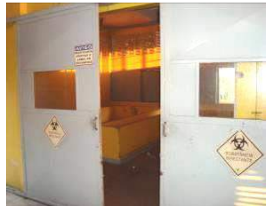
Foto 8.1.4.3-2 Abrigo de armazenamento temporário de RSS
