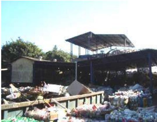
Foto 8.1.2.3-1 Vista da central de triagem
