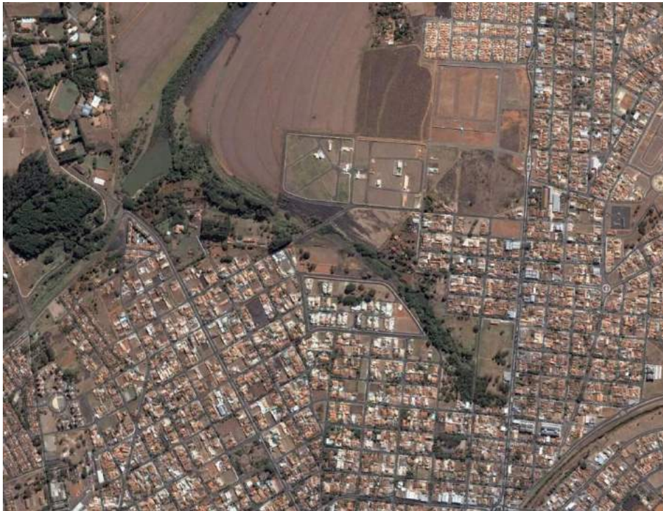
Figura 7.5.6-1 Indicação dos locais em processo de erosão no córrego do Marivan. Fonte: GOOGLE EARTH, 2013
