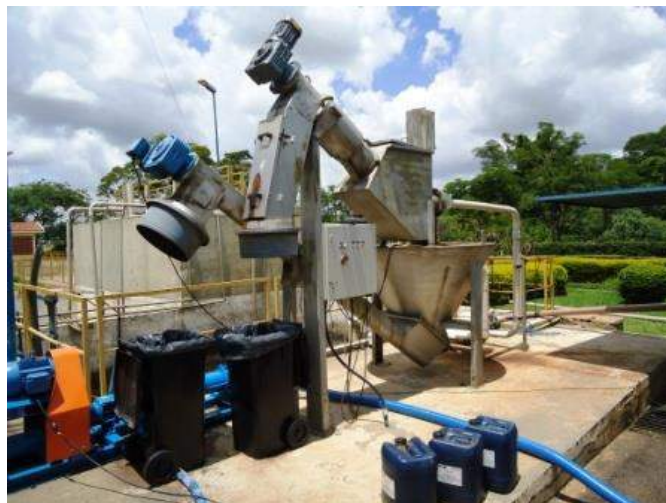
Foto 6.1.2-1 Equipamento Mecanizado denominado Rotamat
