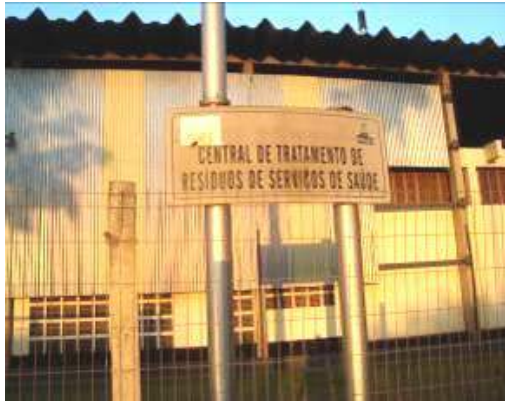
Foto 8.1.4.3-3 Central de Tratamento de RSS temporariamente desativa
