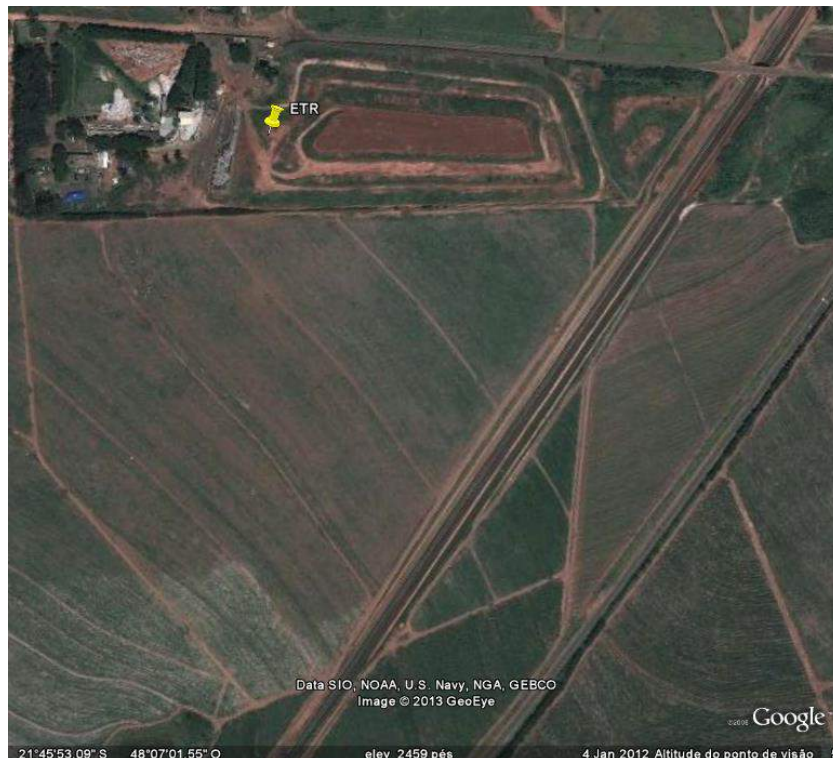
Figura 8.1.11.1-4 ETR- Estação de Tratamento de Resíduos Sólidos
