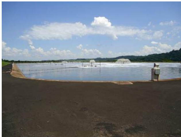
Foto 6.3.2.2-1 Lagoa Aerada com Aeradores do Tipo Submerso Propulsor
