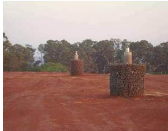
Foto 8.1.1.2-6 Camada de selamento e flares do Aterro Controlado (Encerrado)
