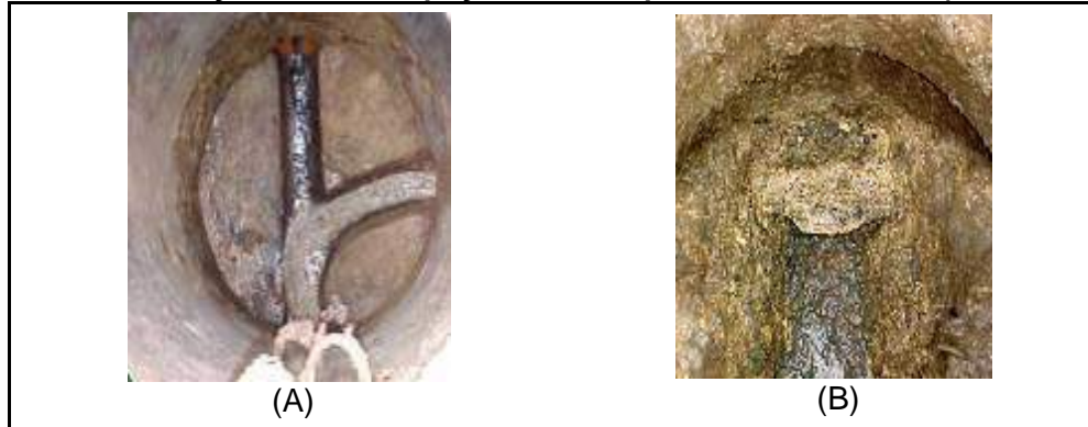
Figura 8.1.8.1-1 Obstrução de redes e poços de visita por resíduos de óleo (SABESP, 2011)
