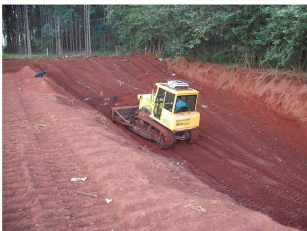
Figura 30: Processo de cobertura dos resíduos no aterro em valas
