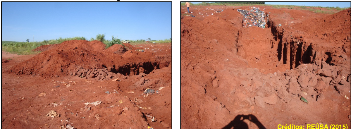
Figura 14. Aterro Sanitário em Valas
