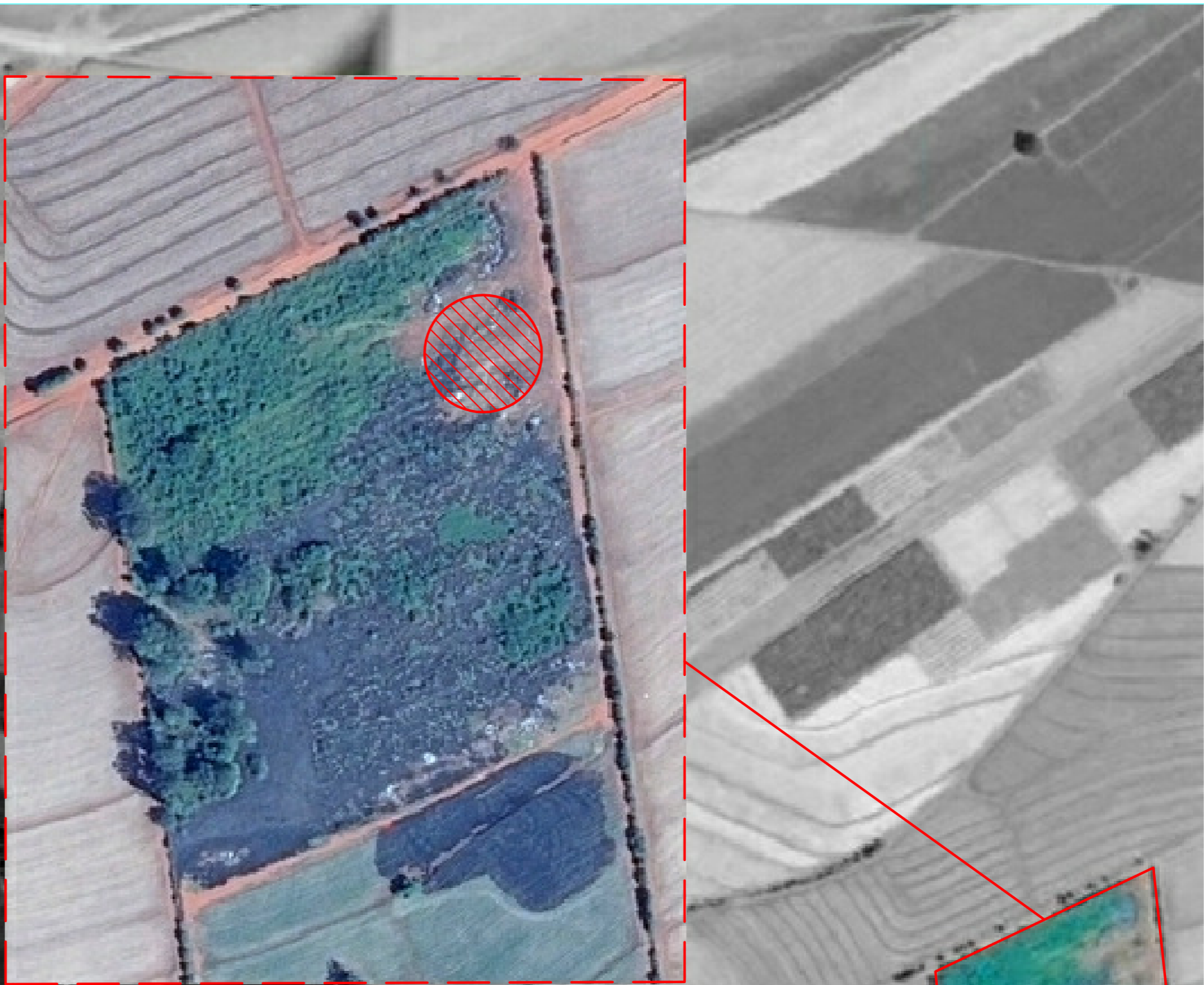
Área Irregular de Disposição de RCC
