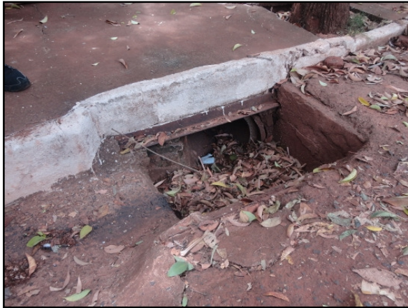
Figura 24. Boca de lobo sem grelhas, quase obstruídas e com problemas estruturais
