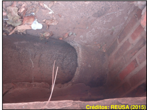
Figura 24. Boca de lobo sem grelhas, quase obstruídas e com problemas estruturais
