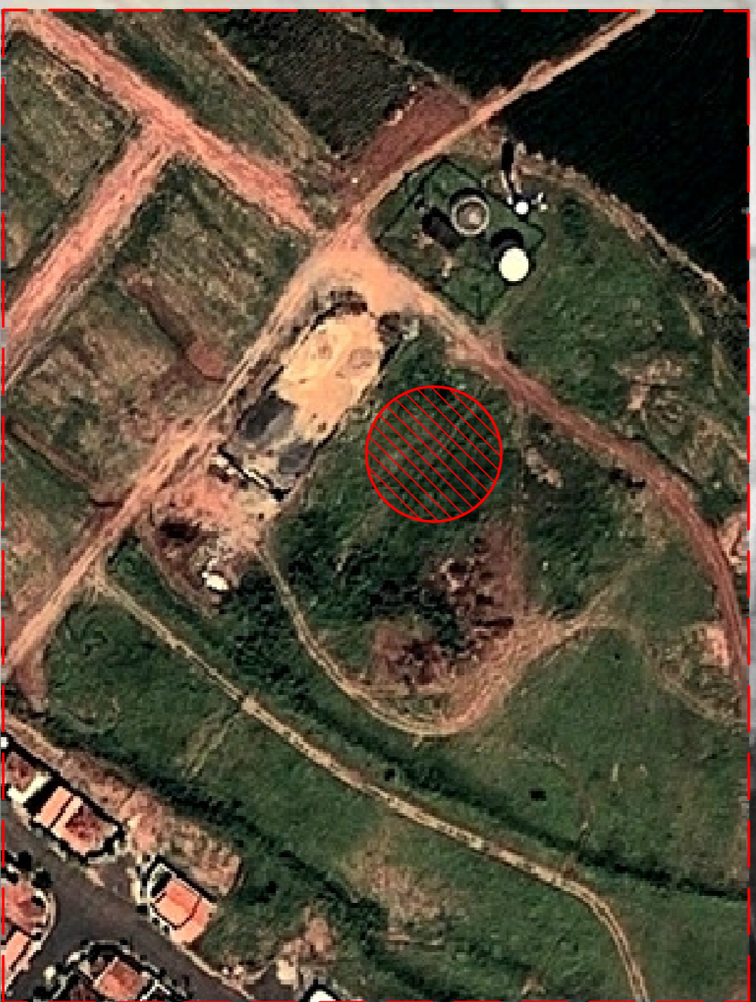
Área Irregular de Disposição de RCC (DESATIVADA)
