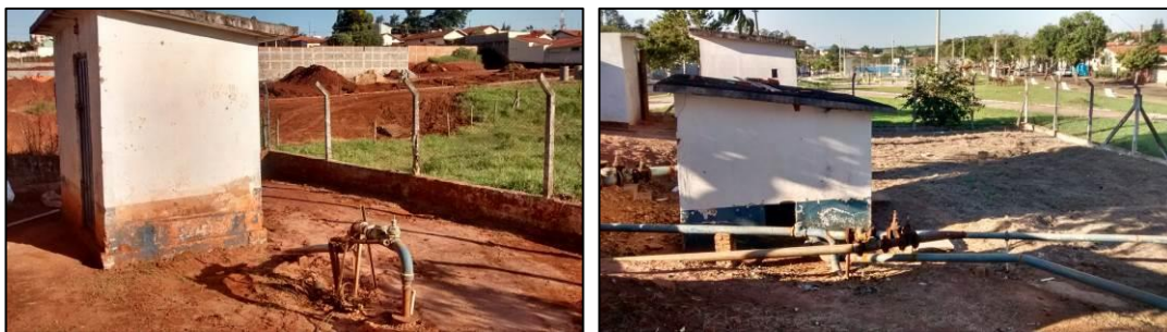
Figura 56 e 57: Poços - Fonte: Autor.
