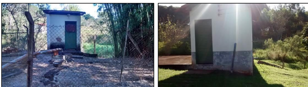
Figura 54 e 55: Poços em Guarapuã (distrito de Dois Córregos) - Fonte: Autor.
