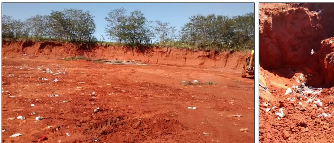
Figura 13 e 14: Aterro sanitário em valas - Fonte: Autor.
