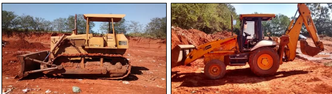
Figura 11 e 12: Maquinas utilizadas no aterro sanitário - Fonte: Autor.
