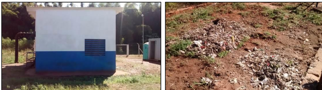
Figura 65 e 66: Estação elevatória e resíduos de limpeza da grade dispostos inadequadamente - Fonte: Autor.
