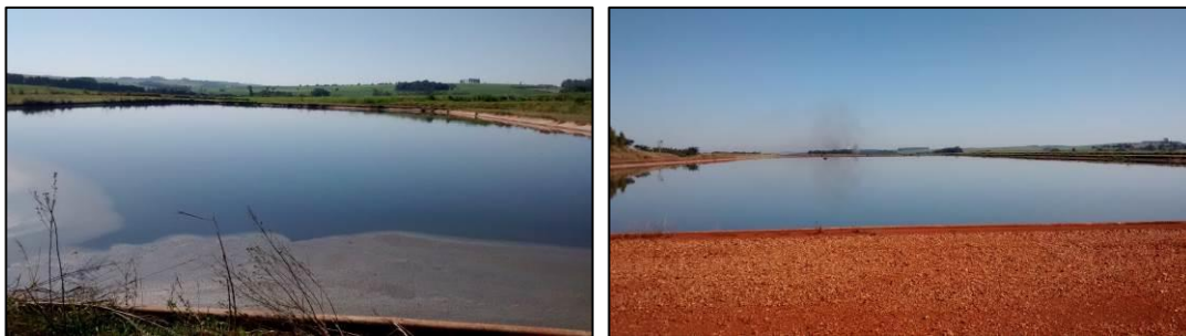
Figura 62 e 63: Lagoa Anaeróbia e facultativa - Fonte: Autor.
