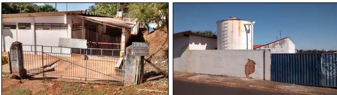
Figura 52 e 53: ETA e Poço - Fonte: Autor.
