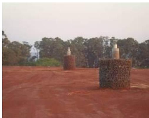
Figura 15. Camada de selamento e *flares* do Aterro Controlado (Encerrado)
