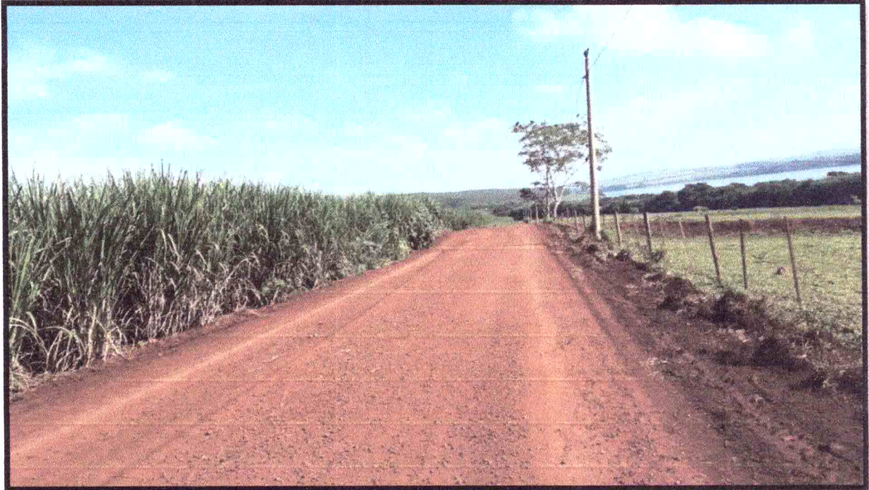
Figura 21: Ações de manutenção e adequação das estradas rurais do município
