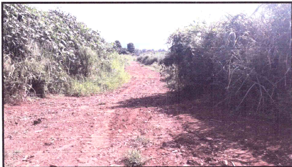
Figura 23: Reuso de resíduos de construção civil na manutenção das estradas rurais
