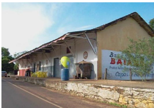
Antiga Estação Ferroviária no Bairro de Nova Paulicéia
