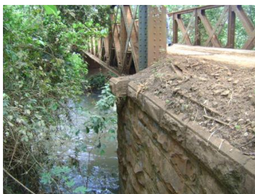
Antiga Ponte Férrea sobre o Rio Jacaré Guaçu
