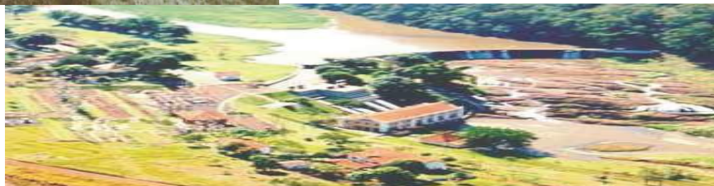
Imagem da Usina Após sua Construção Finalizada
