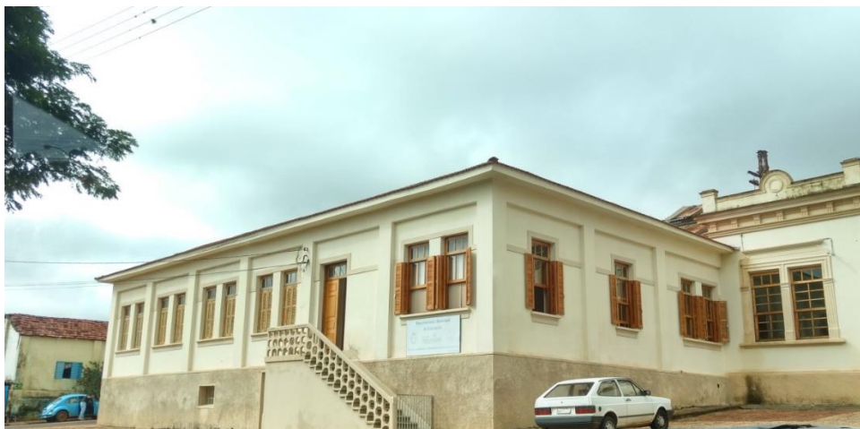
Prédio da Administração - Anexo da Estação Ferroviária
