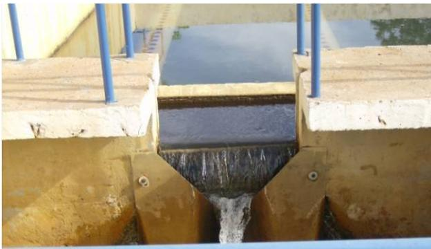
Figura 27. Vertedor de um dos filtros – ETA Bariri
