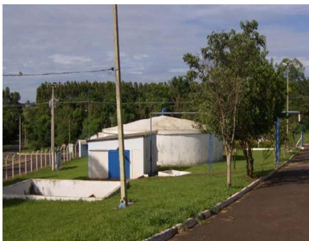
Figura 33. Vista do Reservatório semi enterrado RSE 01 e casa de bombas.
