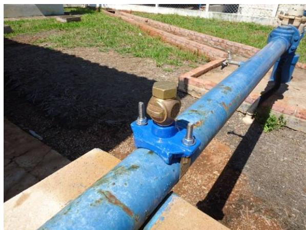
Figura 109. Vista do TAP instalado na tubulação para medição 03
