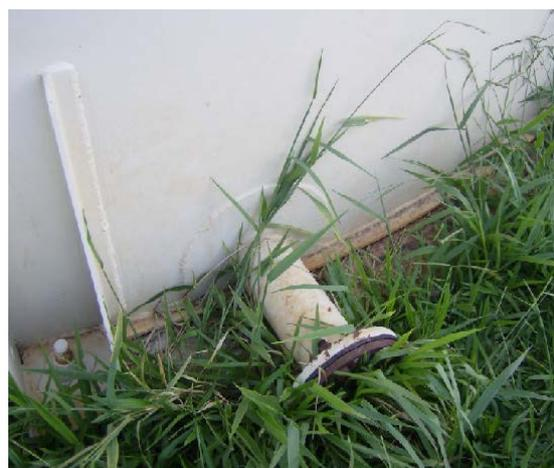
Figura 75. Detalhe da tubulação de limpeza R06
