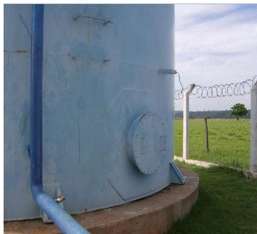
Figura 95. Detalhe tubulação de chegada e flange cega R08
