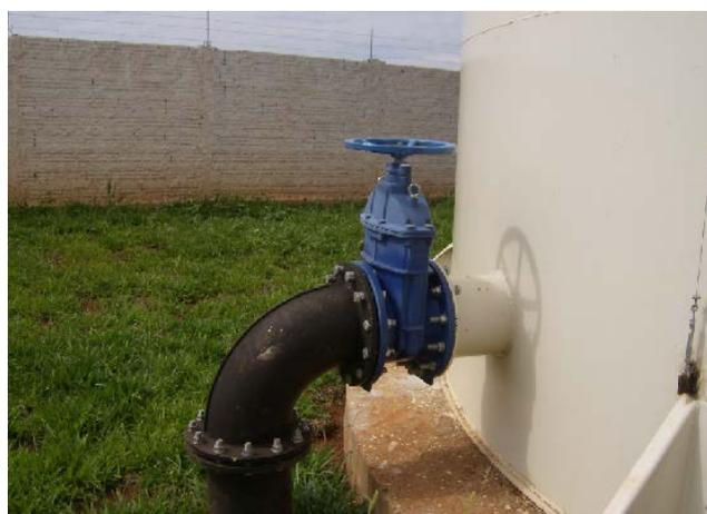
Figura 104.detalhe tubulação de saída
