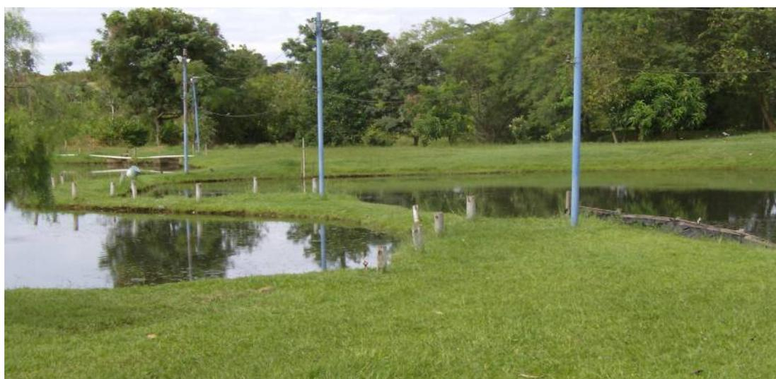
Figura 12. Lagoas que promovem a reservação da água excedente para a complementação da captação nas ocasiões de baixa disponibilidade da captação de água
