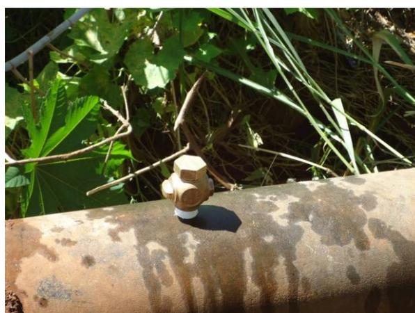
Figura 119. Vista do TAP instalado na tubulação para medição 08, 09, 10, 11, 12 e 13
