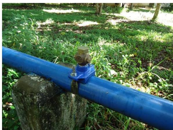
Figura 111. Vista do TAP instalado na tubulação para medição 04
