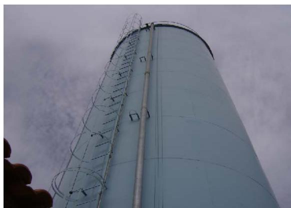
Figura 87. Detalhe da tubulação de chegada R07
