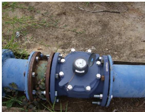
Figura 58. medidor de vazão P04
