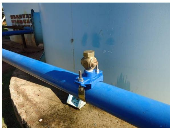
Figura 113. Vista do TAP instalado na tubulação para medição 05
