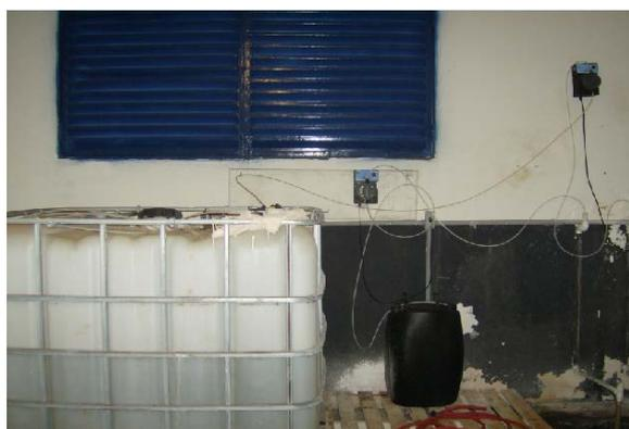
Figura 71. Aplicadores de cloro e fluor no reserv. Subter. Do P05
