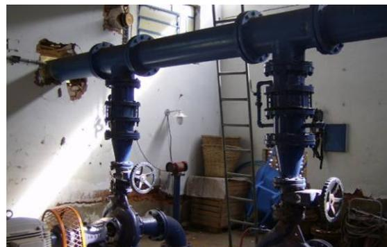
Figura 16. Detalhe da tubulação de saída da adutora de água bruta
