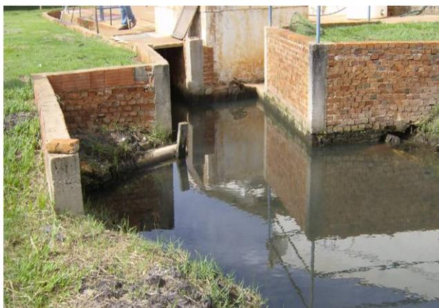
Figura 09. Chegada de água bruta no poço de sucção
