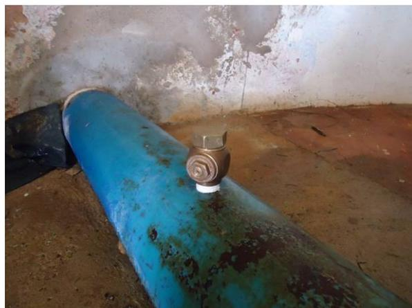
Figura 115. Vista do TAP instalado na tubulação para medição 06
