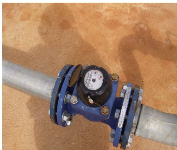
Figura 99. Detalhe medidor de vazão P09
