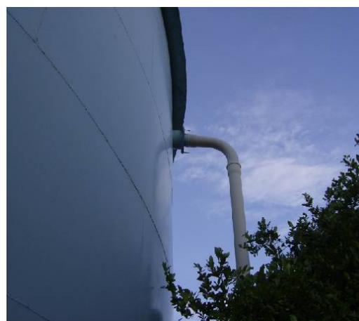
Figura 46. Detalhe do extravasor do R03
