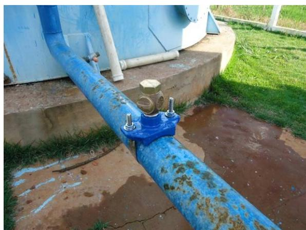
Figura 117. Vista do TAP instalado na tubulação para medição 07
