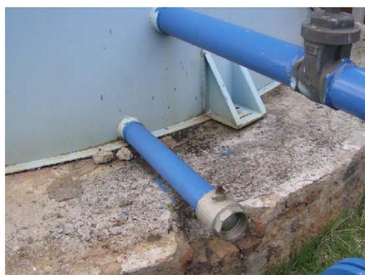
Figura 89. Detalhe das tubulações de saída e de limpeza R07
