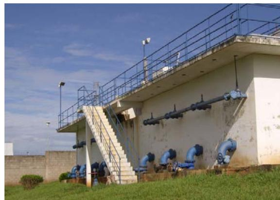
Figura 23. Detalhe das saídas dos filtros
