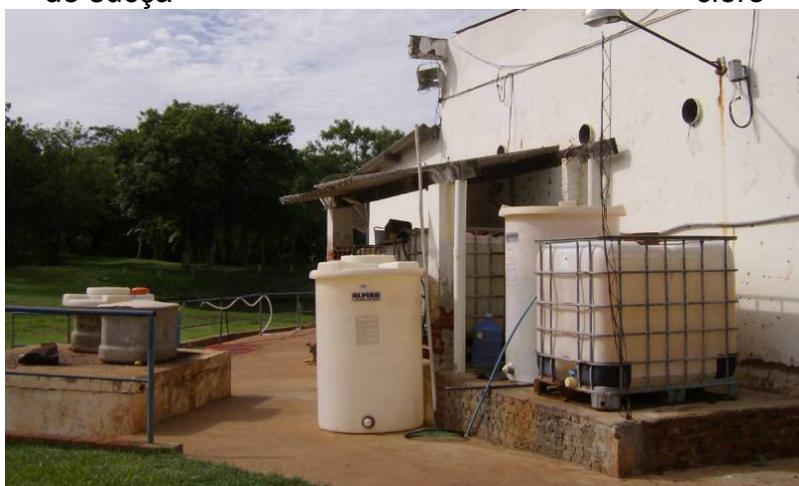
Figura 11. Tanques de hipoclorito de sódio - Armazenamento de produtos químicos
