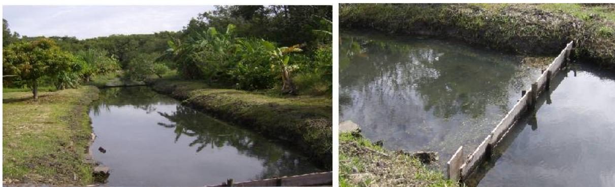
Figura 08. Canal de chegada de água bruta no poço de sucção da captação de água
