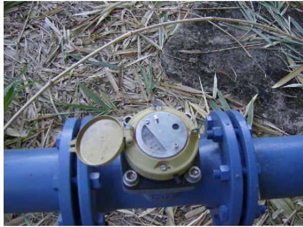
Figura 48. detalhe do medidor de vazão do P03
