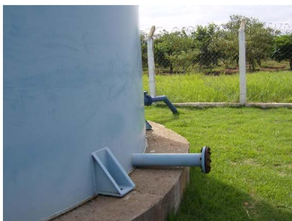
Figura 96. detalhe da tubulação para limpeza R08
