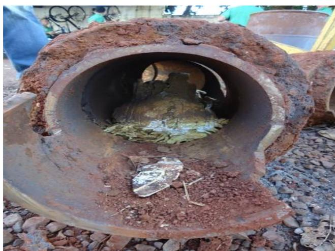
Figura 134. Vista de tubulação com chumbo penetrado pela bolsa
