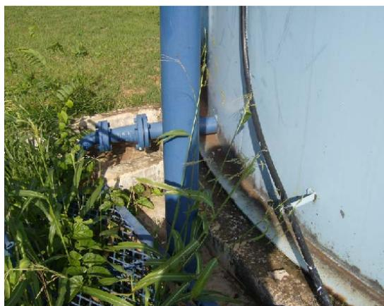
Figura 56. Detalhe da tubulação de chegada de água
