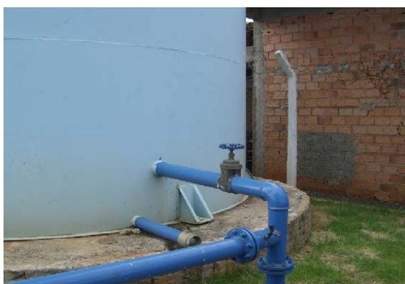
Figura 84. Detalhe da ligação da água do P07 direto na rede.
