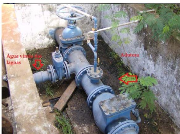
Figura 18. Detalhe da adutora com chegada da água das lagoas
