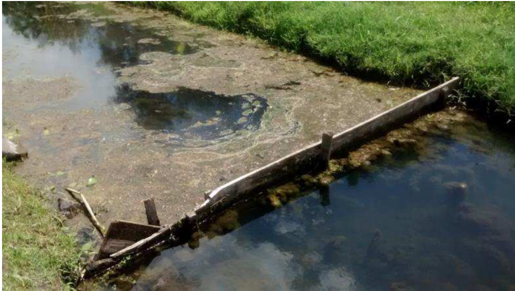
Figura 3.1 - Ponto de degradação da água captada junto a um barramento executado para evitar a chegada de galhos, folhas e materiais grosseiros no sistema de bombeamento
