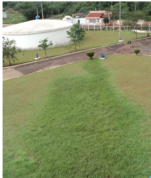
Caminho percorrido pela água proveniente do vazamento
