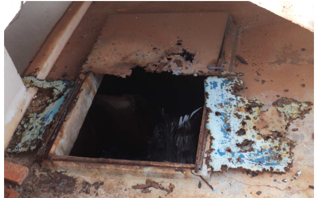
Tampa da câmara geral de água filtrada
