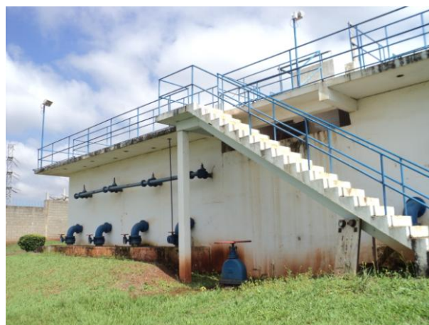
Vista lateral da ETA
