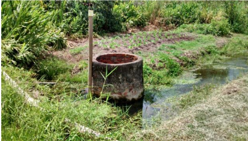
Figura 2.16 - Início do canal principal de encaminhamento da água ao poço de sucção (EEAB)
