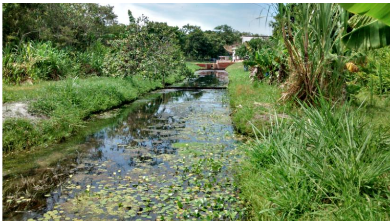
Figura 2.18 - Crescimento de vegetação aquática no canal principal de encaminhamento da água ao poço de sucção
