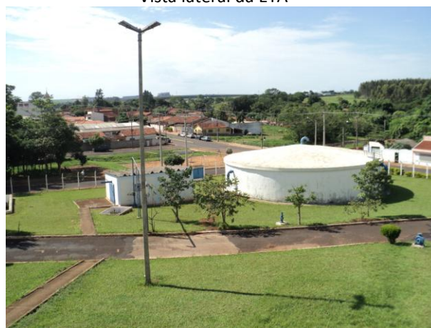
Reservatório existente na ETA (R01)
