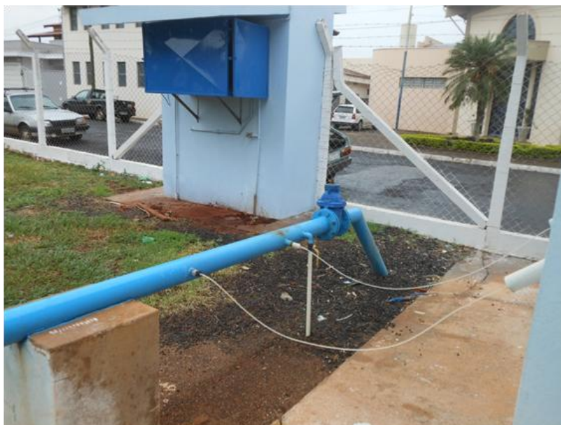
Figura 2.10 - Poço 6 – Pontos de cloração e fluoretação
