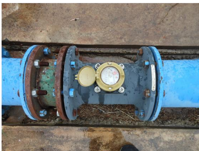
Figura 2.5 - Hidrômetro do Poço 4 – Santa Helena
