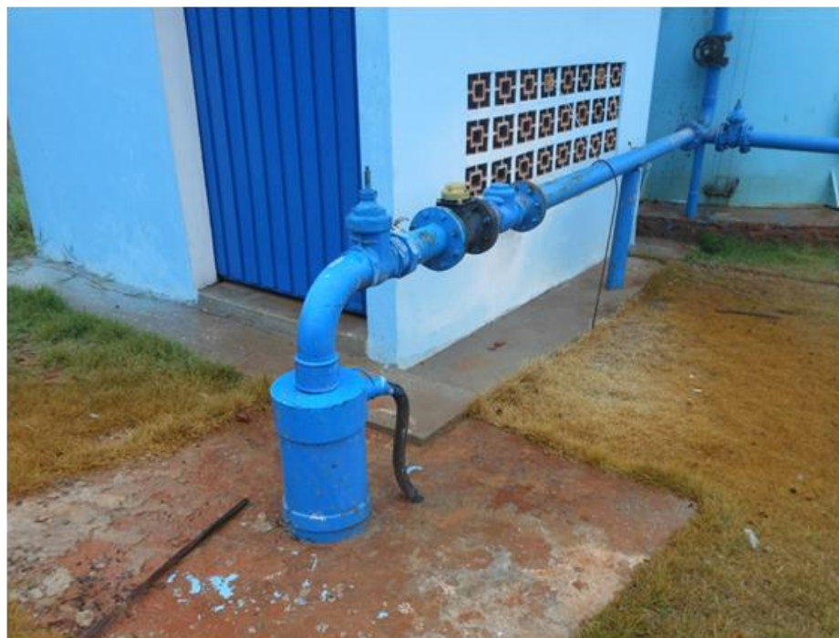
Figura 2.12 - Pontos para cloração e fluoretação
