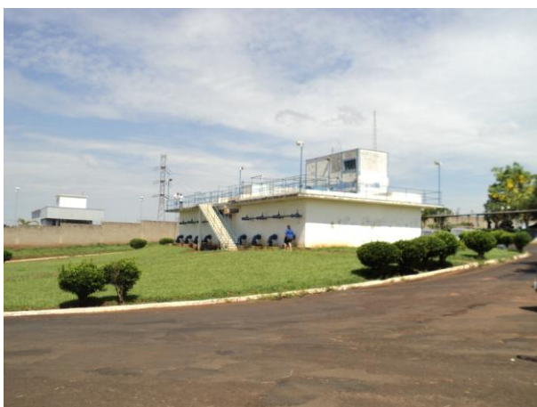
Vista geral da ETA
