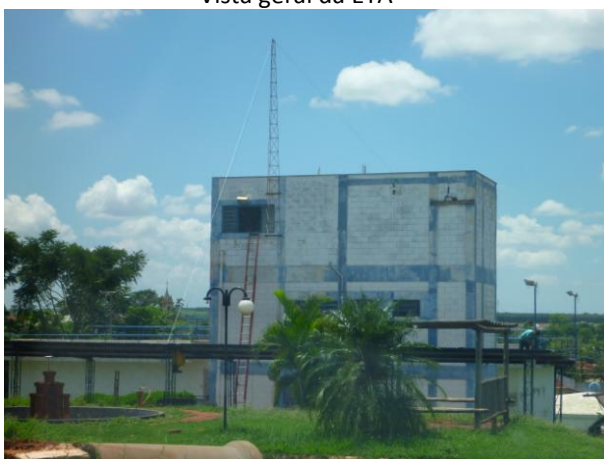
Instalação dos laboratório e casa de química
