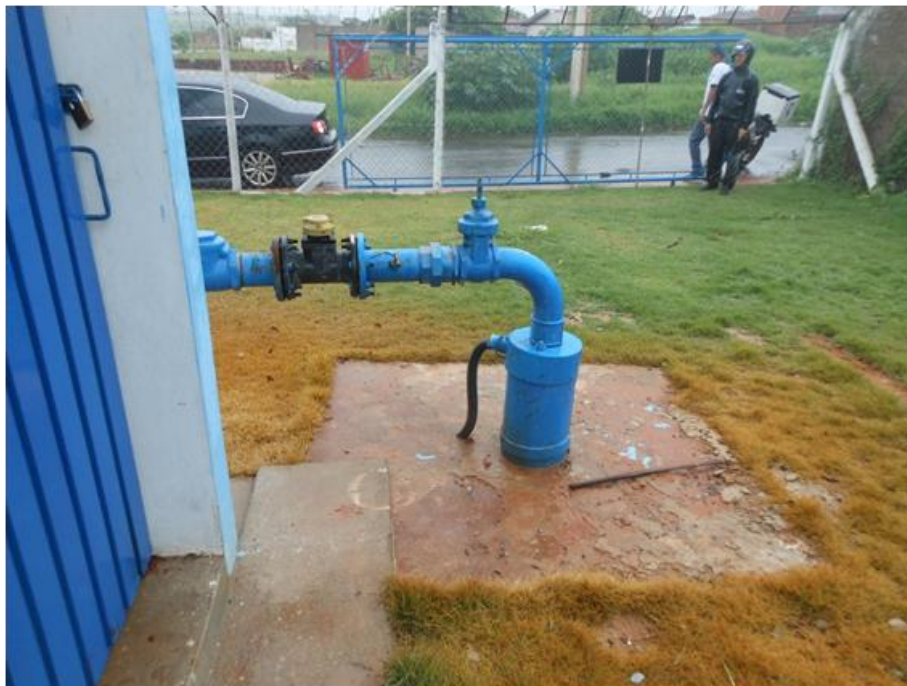
Figura 2.11 - Poço 7 - Maria Luiza II e III
