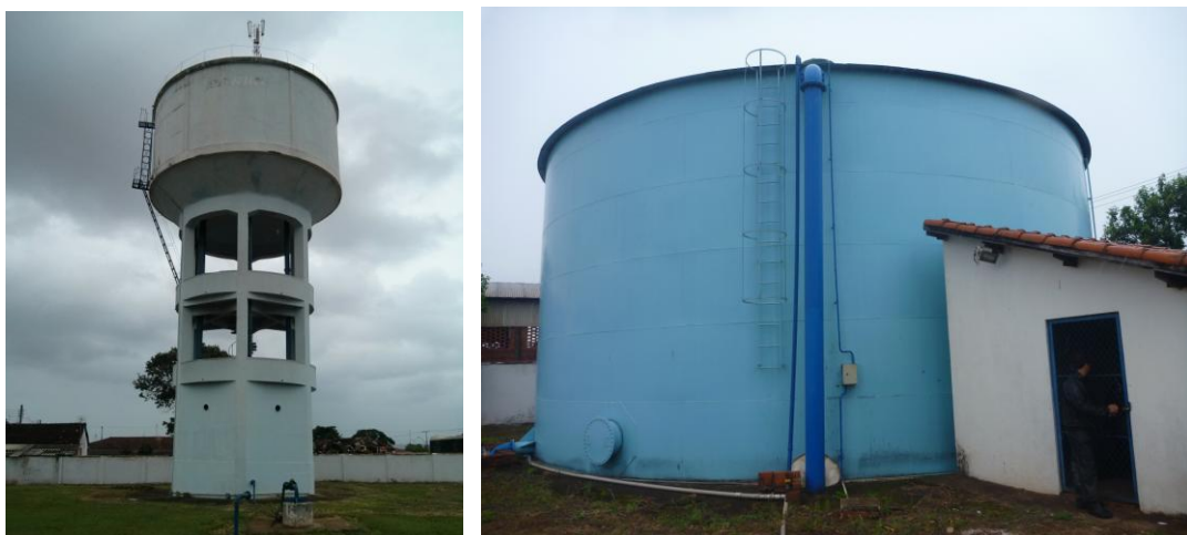
Figura 6.22 - Reservatório 2 e 3, respectivamente (Fonte: arquivo Hidrosan, 2013)
