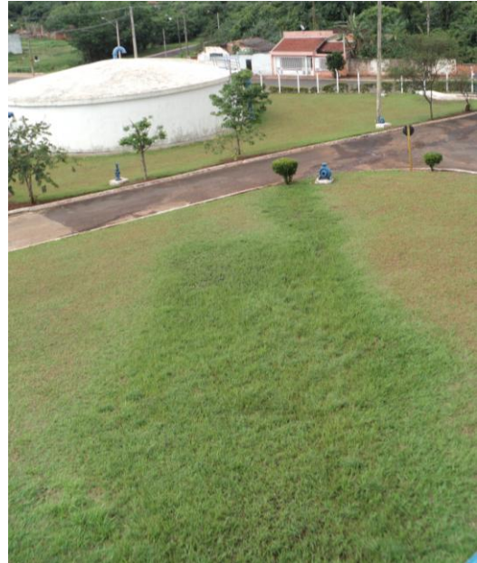
Caminho percorrido pela água proveniente do vazamento
