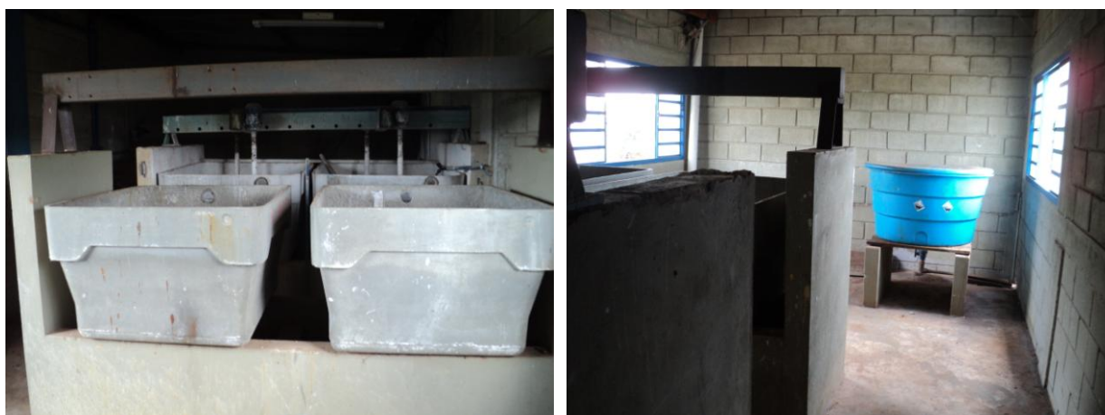
Figura 6.20 - Tanque desativados no pavimento superior - Casa de química (Fonte: arquivo Hidrosan, 2013)
