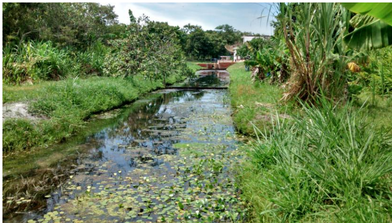
Figura 5.23 - crescimento de vegetação aquática no canal principal de encaminhamento da água ao poço de sucção
