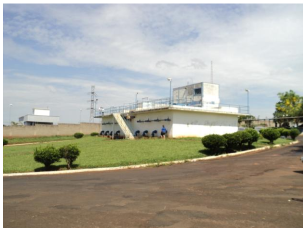
Vista geral da ETA
