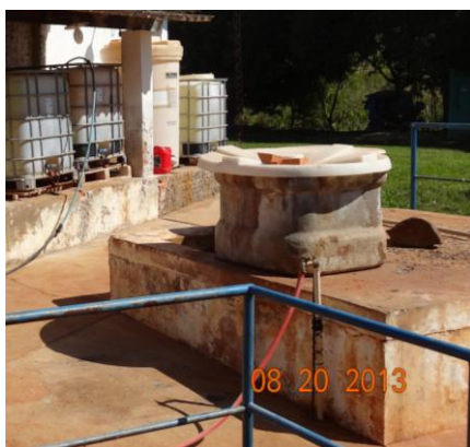
Figura 6.2 - Tanques de hipoclorito de sódio - Pré-cloração da água bruta na captação (Fonte: arquivo Hidrosan, 2013 e 2014)
