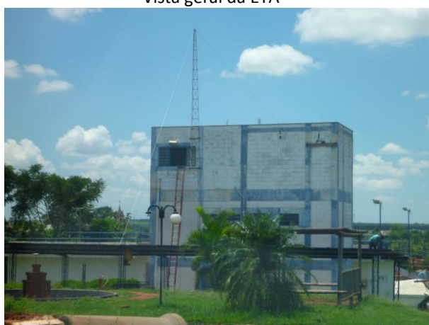
Instalação dos laboratório e casa de química
