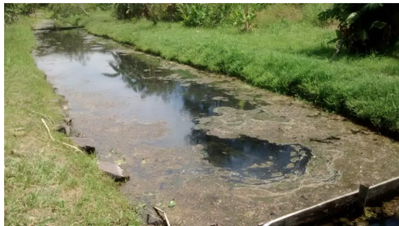
Figura 5.26 - Acúmulo de matéria orgânica devido ao florescimento e decomposição de algas no final do canal principal
