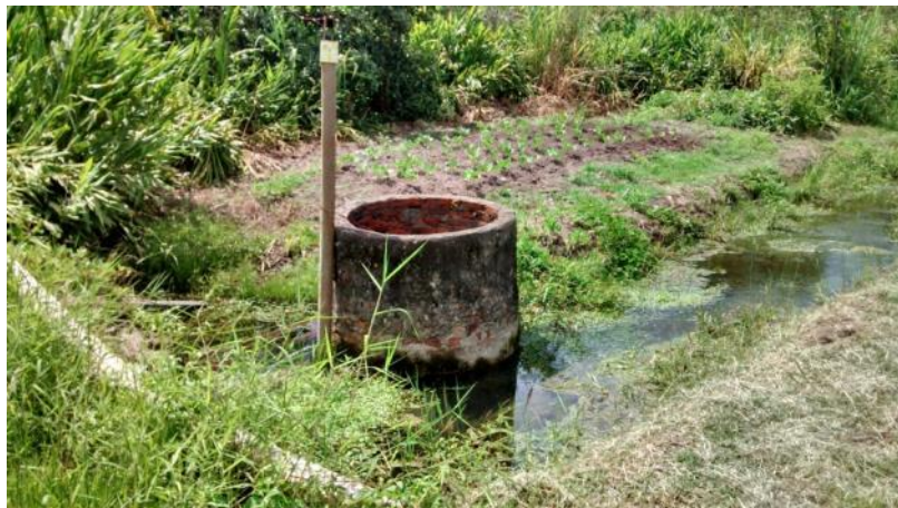
Figura 5.21 - Início do canal principal de encaminhamento da água ao poço de sucção (EEAB)
