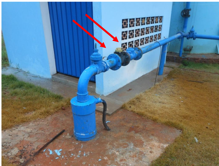
Figura 4.28 - Pontos para cloração e fluoretação
