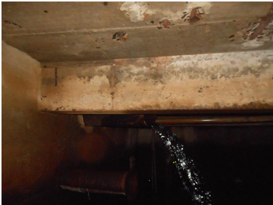
Figura 4.24 - Detalhe da chegada da água no reservatório
