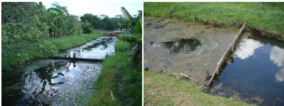
Figura 6.1 - Canal de chegada de água bruta no poço de sucção (Fonte: arquivo Hidrosan, Janeiro de 2014)
