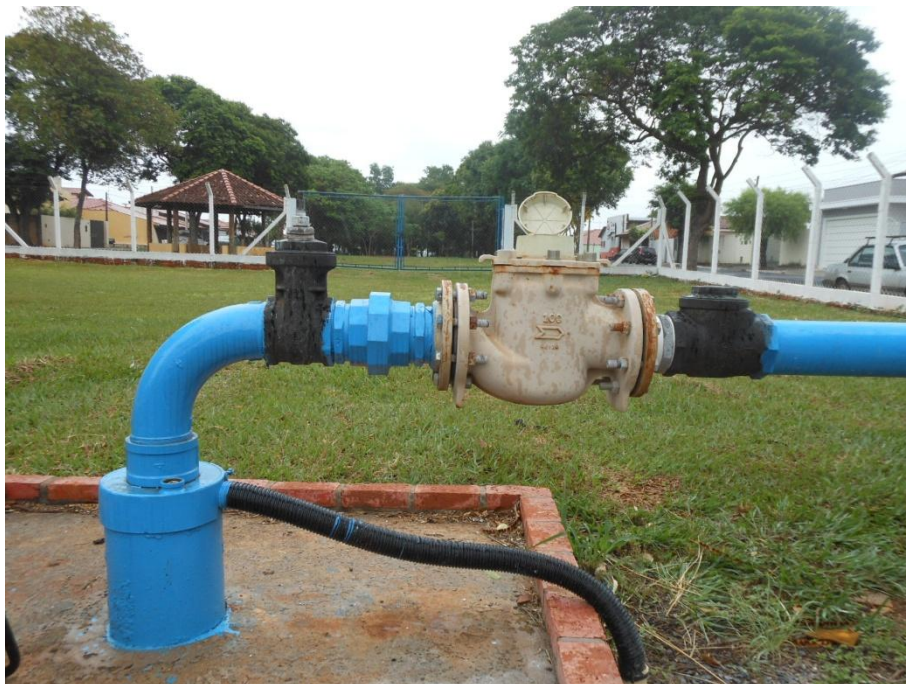
Figura 4.25 - Poço 6 - Nova Bariri
