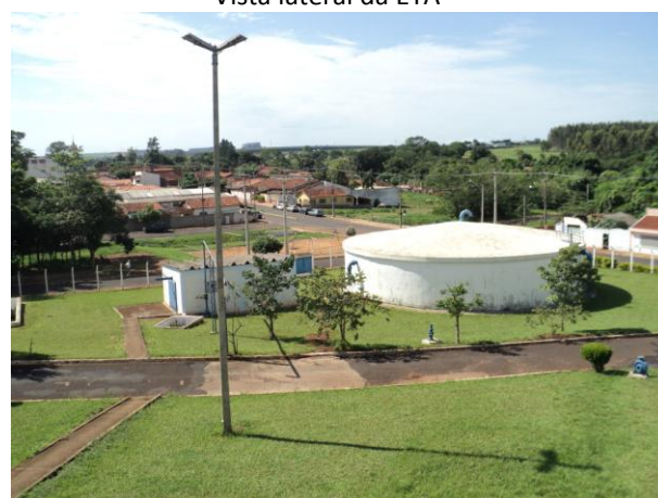
Reservatório existente na ETA (R01)
