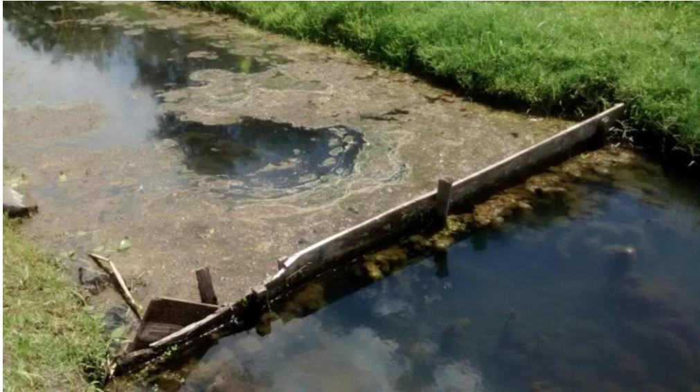
Figura 5.40 -Ponto de degradação da água captada junto a um barramento executado para evitar a chegada de galhos, folhas e materiais grosseiros no sistema de bombeamento
