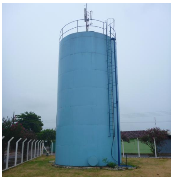
Figura 6.24 - Reservatório Umuarama (Fonte: arquivo Hidrosan, 2013)
