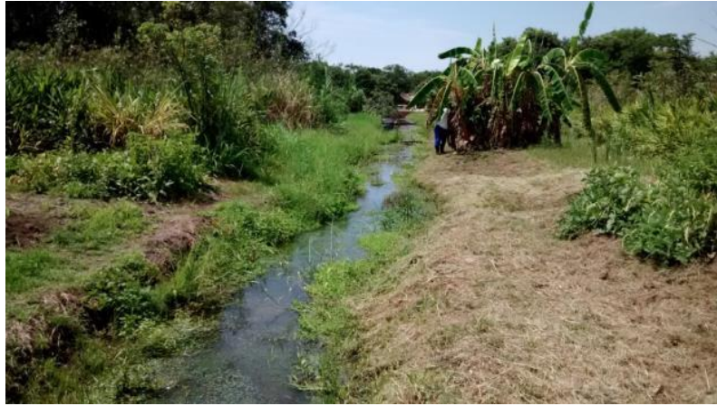
Figura 5.22 - Canal principal de encaminhamento da água ao poço de sucção (EEAB)
