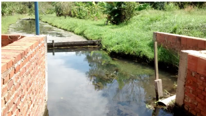
Figura 5.27 - Chegada do canal principal no poço de sucção (EEAB).
