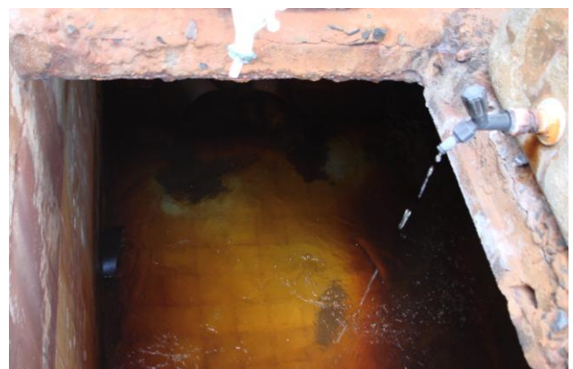
Figura 6.2 - Tanques de hipoclorito de sódio - Pré-cloração da água bruta na captação (Fonte: arquivo Hidrosan, 2013 e 2014)
