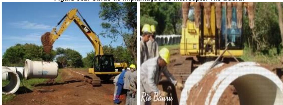
Figura 362: Obras de implantação do Interceptor Rio Bauru.
