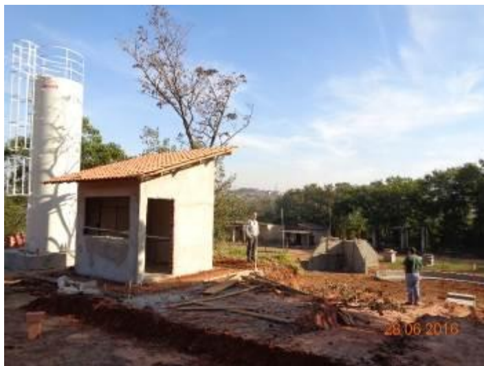
Figura 437: Usina de Reciclagem de RCC - Fase de Construção
