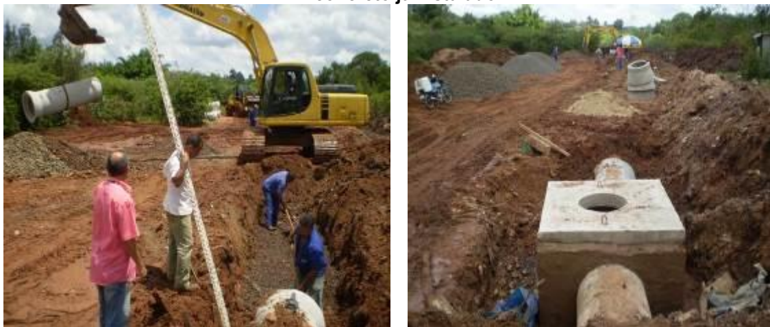
Figura 358: Fotos das obras de implantação do Interceptor Córrego Vargem Limpa. Na foto à esquerda o preparo da base de concreto para assentamento do tubo. Na foto à direita o PV de concreto já instalado
