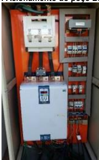
Figura 159: Acionamento do poço Bauru XVI III.
