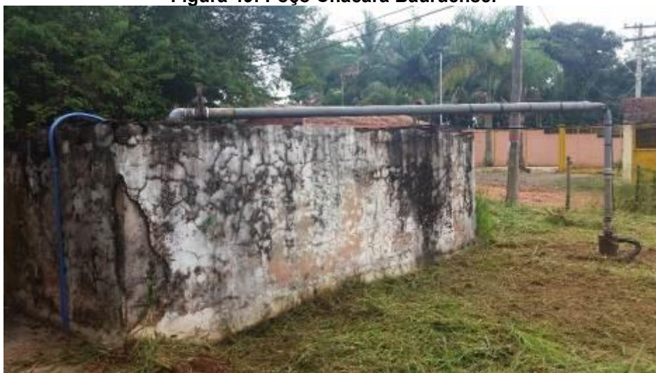
Figura 49: Poço Chácara Bauruense.
