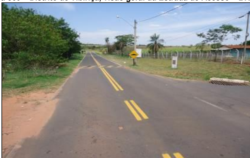
Figura 560 – Distrito de Tibiriçá, visão geral da Estrada de Acesso – BRU 007.
