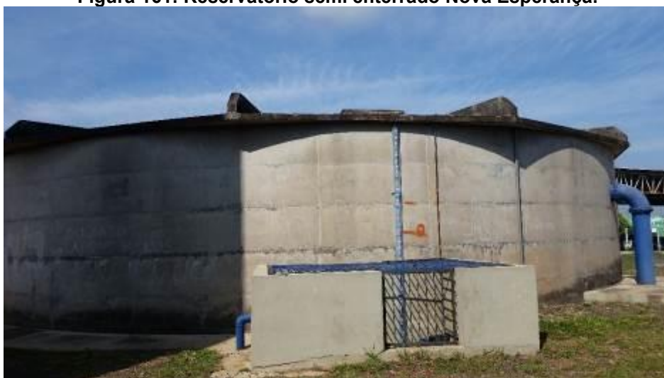
Figura 161: Reservatório semi enterrado Nova Esperança.
