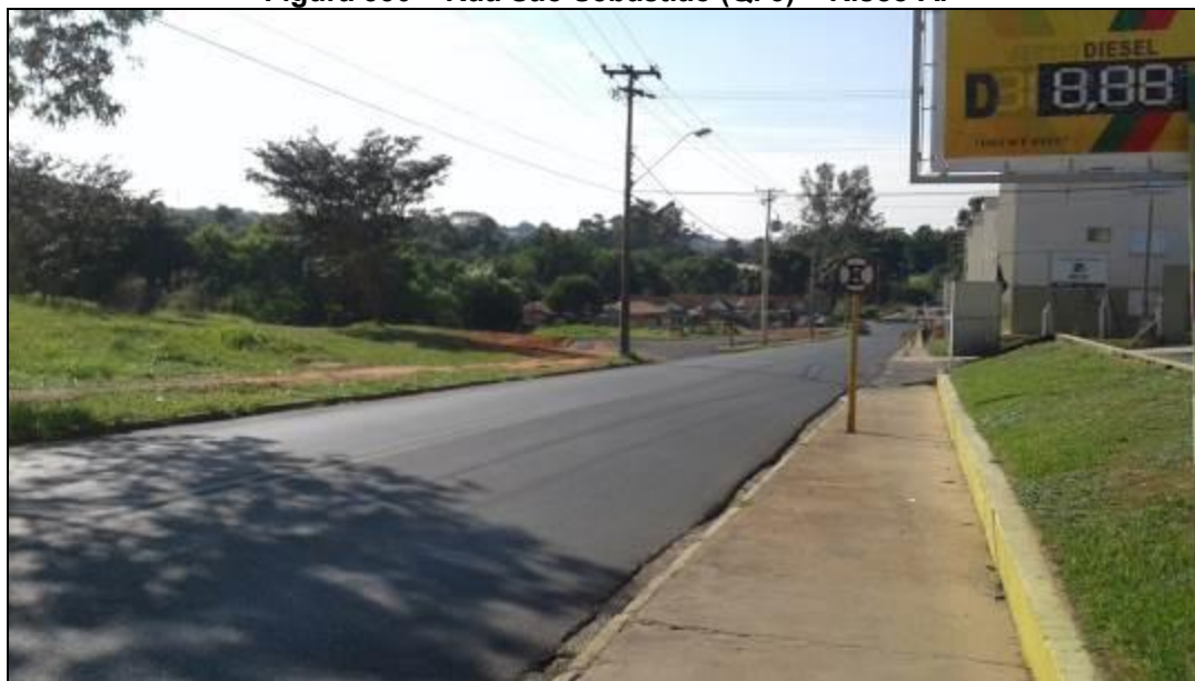
Figura 530 – Rua São Sebastião (Q. 3) – Risco A.
