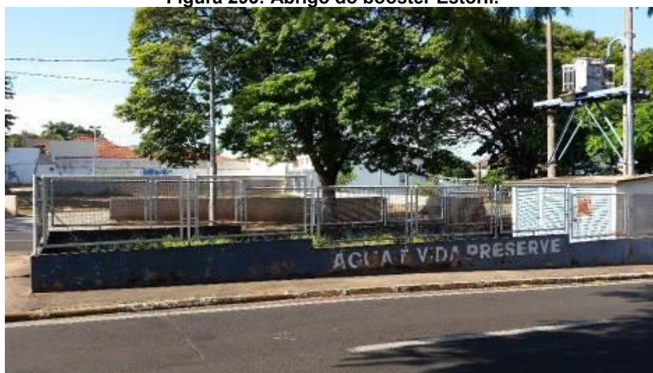
Figura 293: Abrigo do booster Estoril.
