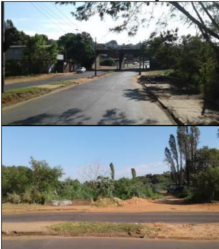
Figura 528 – Av. Daniel Pacífico ao lado Córrego da Grama – Risco A.
