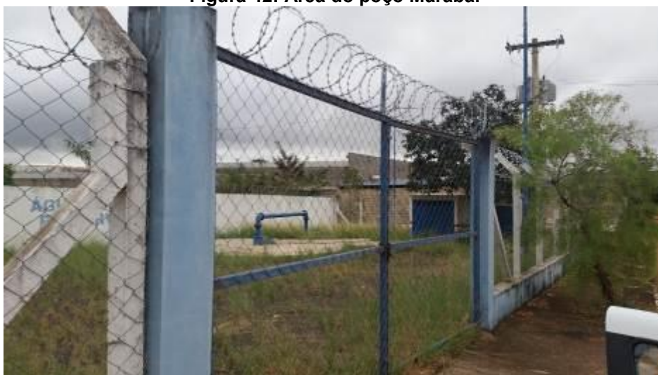
Figura 42: Área do poço Marabá.
