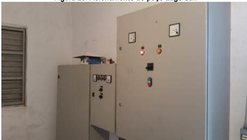
Figura 26: Acionamento do poço Lago Sul.
