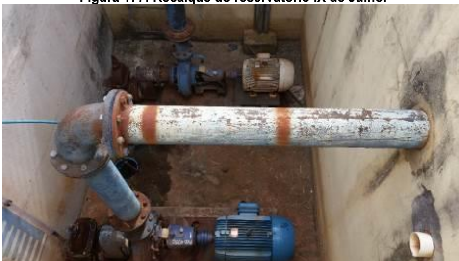
Figura 177: Recalque do reservatório IX de Julho.
