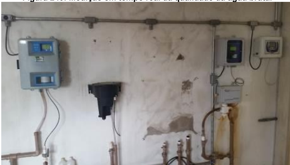
Figura 240: Medição em tempo real da qualidade da água bruta.
