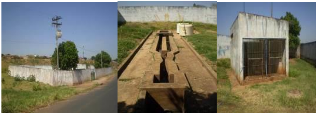
Figura 371: Estação elevatória E.E.E Fortunato Rocha Lima. No centro as unidades de gradeamento grosseiro e desarenador.
