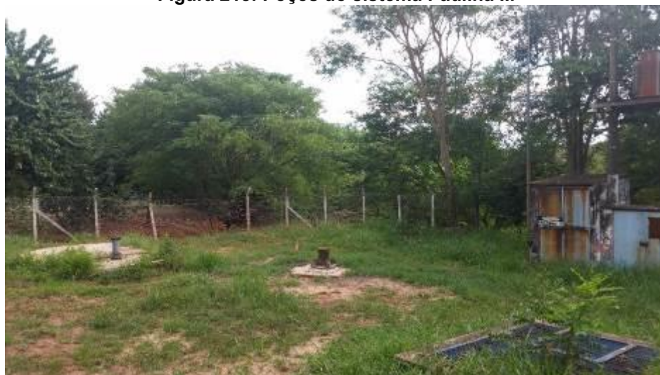
Figura 218: Poços do sistema Padilha II.
