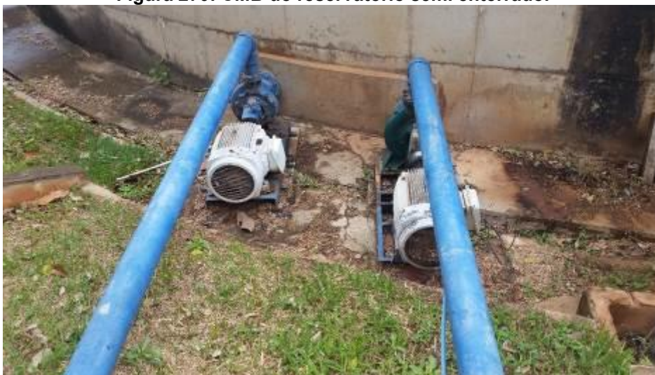
Figura 270: CMB do reservatório semi enterrado.
