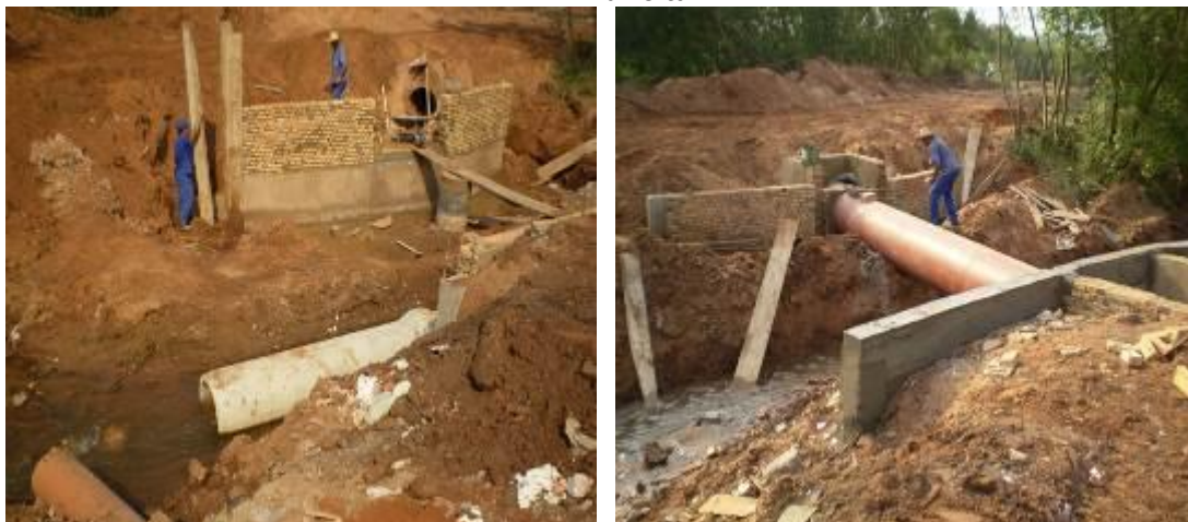
Figura 352: Fotos das obras de implantação do Interceptor Córrego da Forquilha. Na foto à direita
