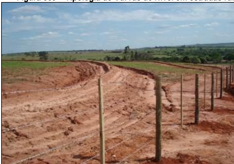
Figura 559 – Tipologia de Curvas de Nível em estradas rurais.
