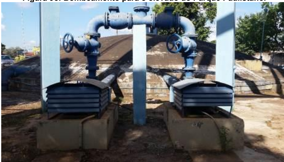
Figura 95: Bombeamento para o elevado do Parque Paulistano.
