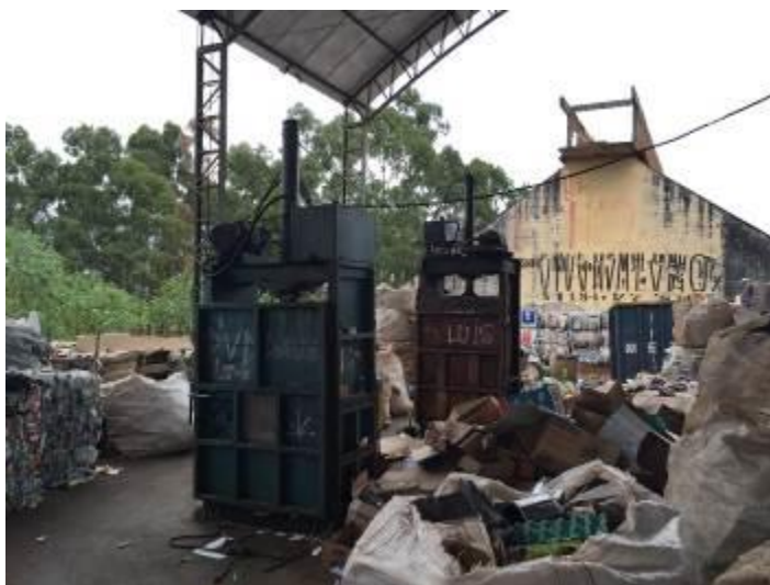
Figura 469: Prensas para Compactação dos Materiais Triados
