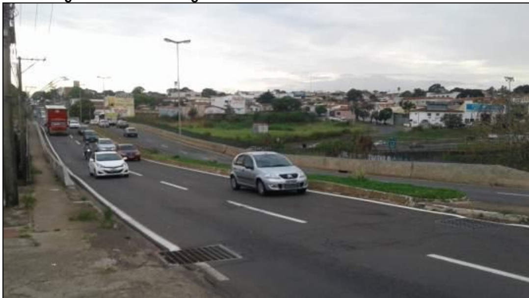
Figura 523 – Av. Rodrigues Alves sobre Rod. Mal. Rondon – Risco A.
