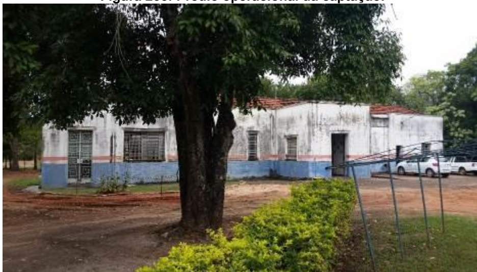
Figura 235: Prédio operacional da captação.
