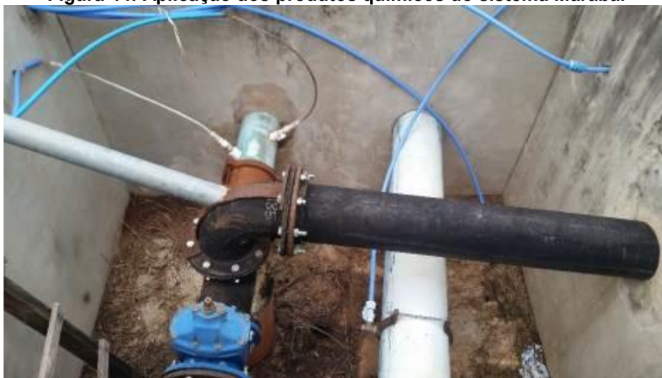
Figura 44: Aplicação dos produtos químicos do sistema Marabá.
