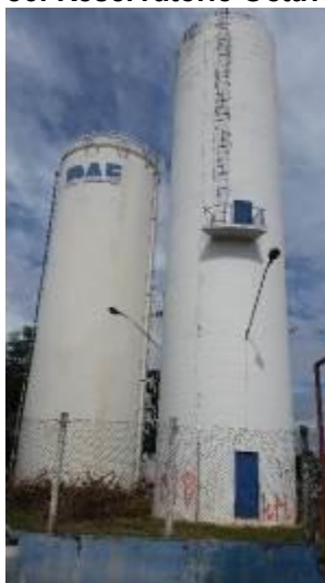
Figura 86: Reservatório Octávio Rasi.
