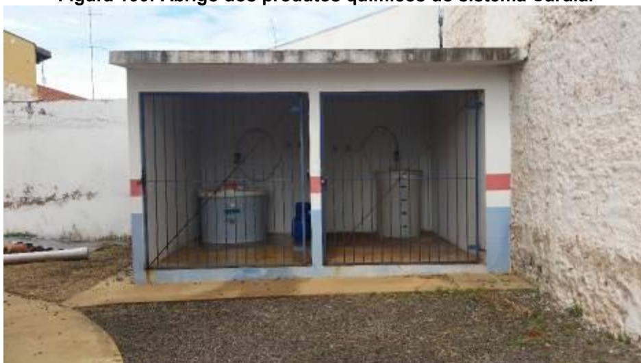
Figura 100: Abrigo dos produtos químicos do sistema Cardia.
