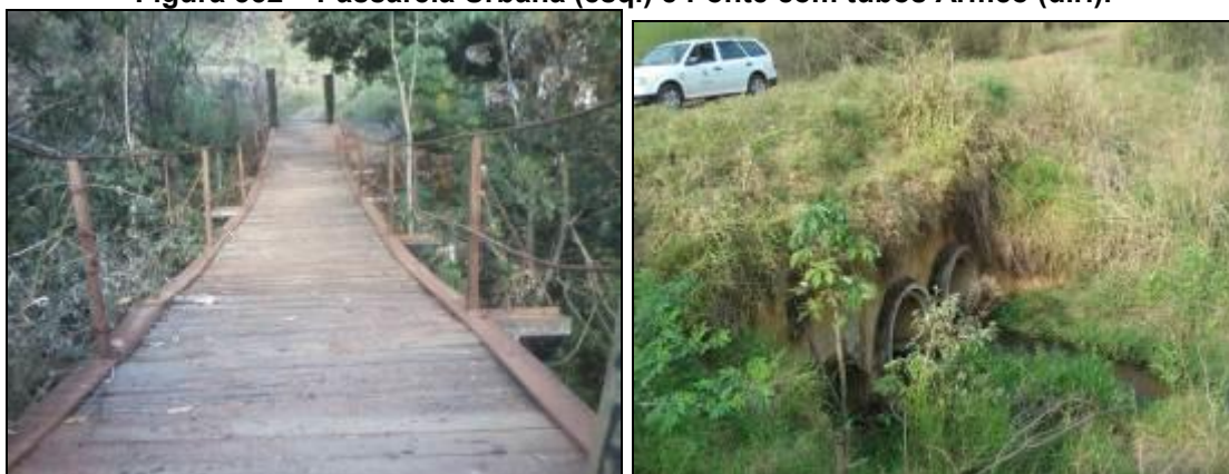
Figura 552 – Passarela Urbana (esq.) e Ponte com tubos Armco (dir.).
