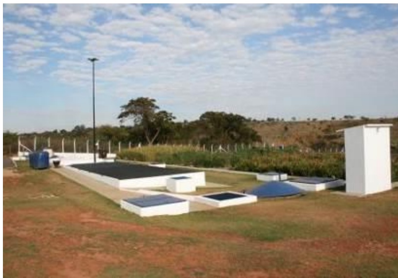
Figura 394: Filtro anaeróbio de fluxo ascendente.
