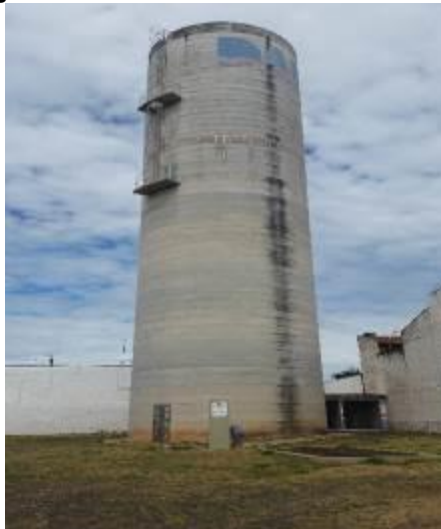
Figura 101: Reservatório elevado Cardia.
