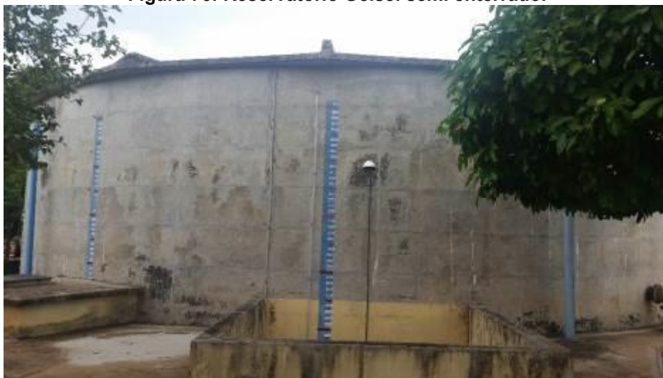
Figura 76: Reservatório Geisel semi enterrado.
