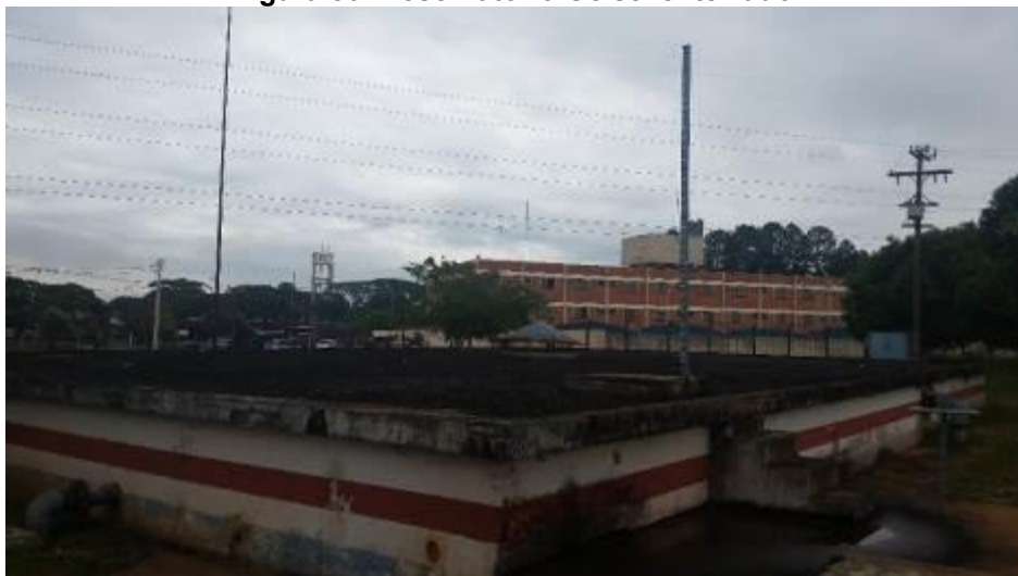
Figura 80: Reservatório Geisel enterrado.
