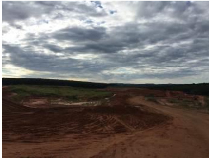
Figura 477: Vista geral do Aterro Sanitário
