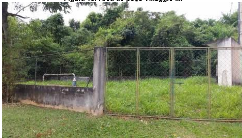
Figura 18: Área do poço Villaggio III.
