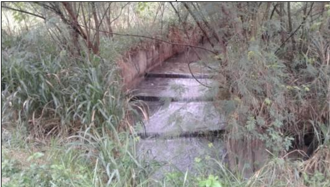
Figura 541 – Escadarias da macrodrenagem Córreg. Madureira, afluente Rio Bauru (Av. Nuno de Assis).
