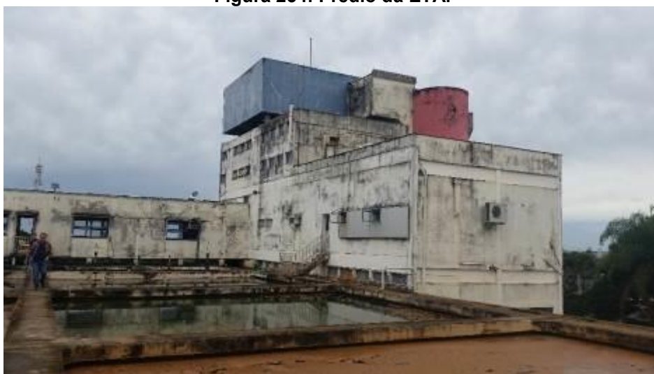
Figura 254: Prédio da ETA.
