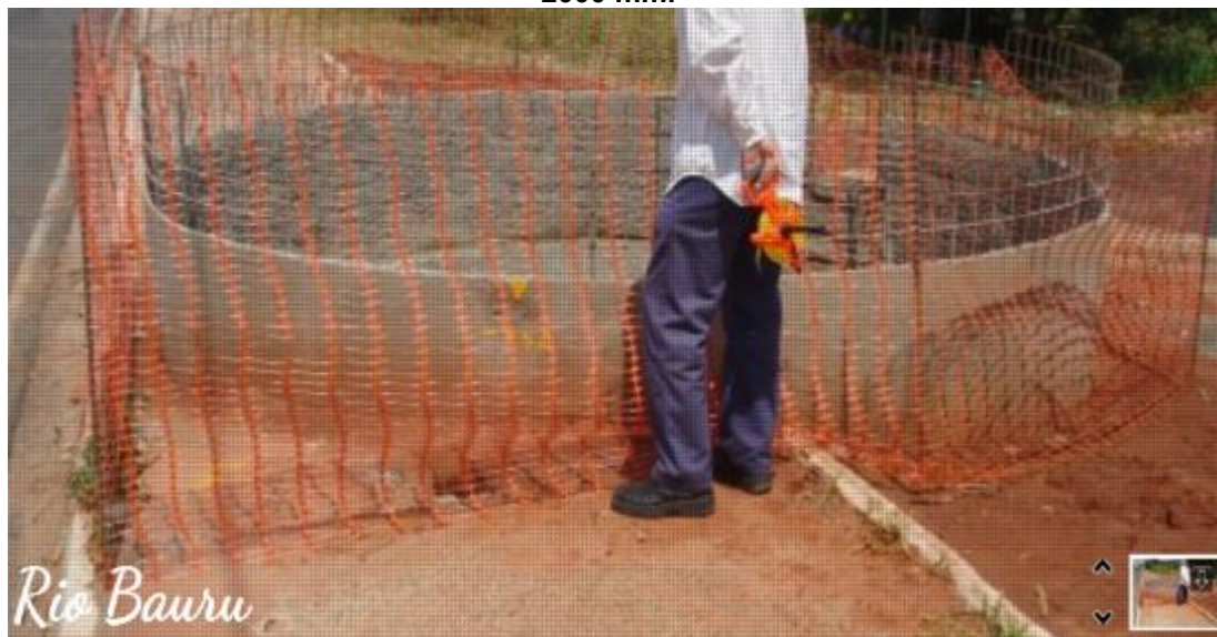
Figura 363: Obras de implantação do Interceptor Rio Bauru. Foto do PV do Interceptor de DN 2000 mm.
