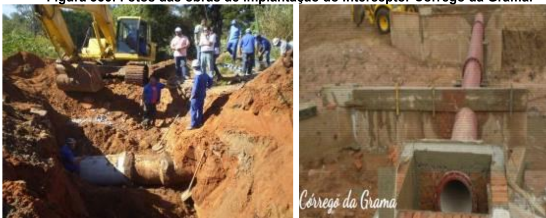
Figura 356: Fotos das obras de implantação do Interceptor Córrego da Grama.
