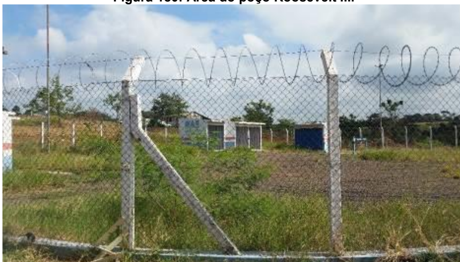
Figura 180: Área do poço Roosevelt III.
