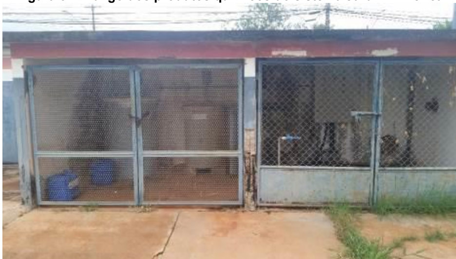
Figura 37: Abrigo dos produtos químicos do sistema Jardim América.
