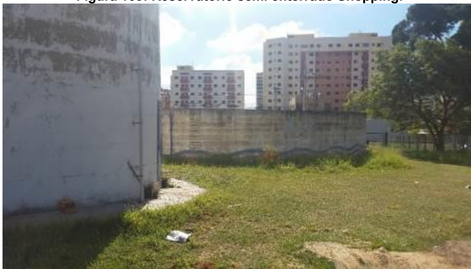
Figura 109: Reservatório semi enterrado Shopping.
