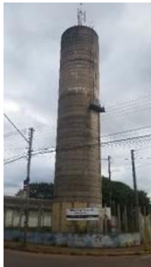
Figura 143: Reservatório Vila São Paulo.
