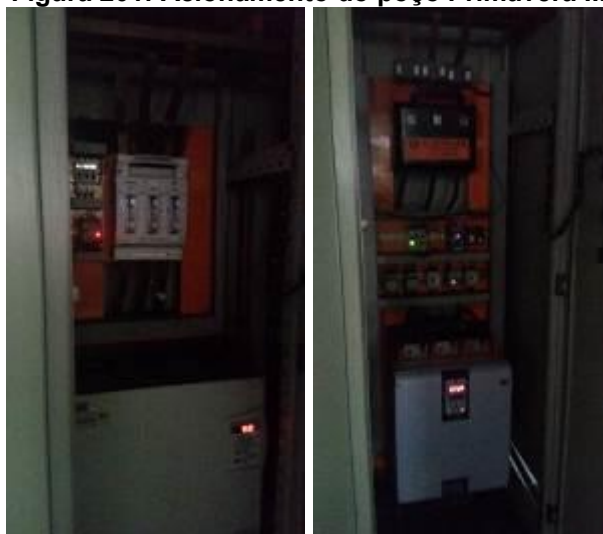
Figura 201: Acionamento do poço Primavera II.
