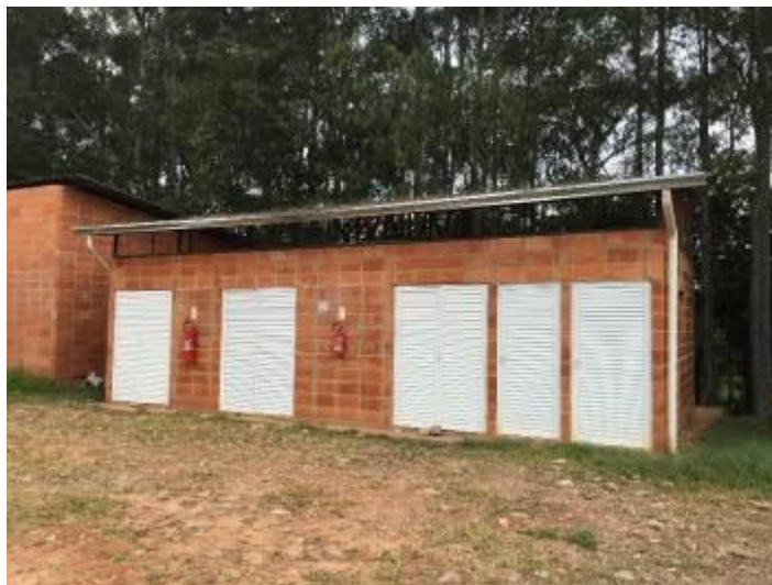
Figura 429: Câmara Fria para o Armazenamento dos RSS - Aterro Sanitário Municipal
