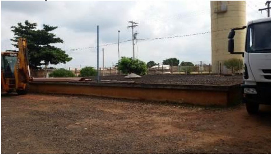
Figura 174: Reservatório IX de Julho semi enterrado A.
