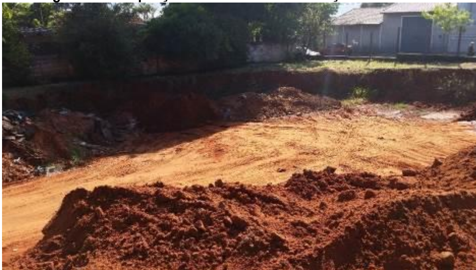
Figura 285: Ampliação da unidade de reservação Alto Paraíso.
