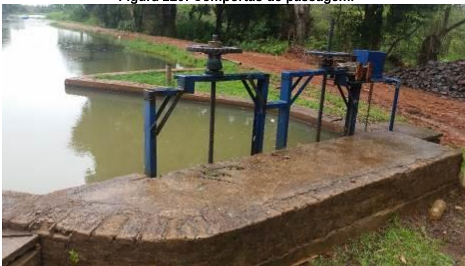
Figura 220: Comportas de passagem.
