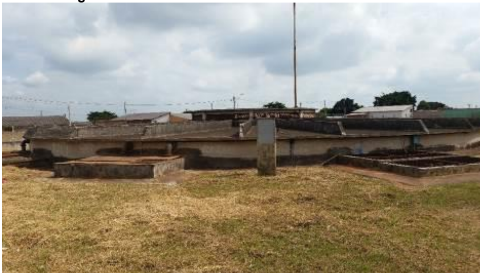
Figura 175: Reservatório IX de Julho semi enterrado B.
