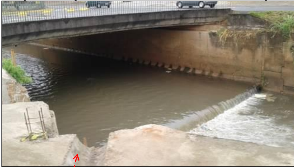
Figura 547 – Degrau Canal Rio Bauru e lançamento na macrodrenagem.
