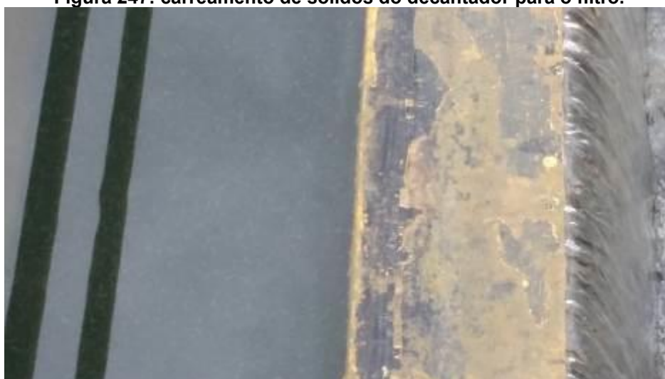
Figura 247: carregamento de sólidos do decantador para o filtro.
