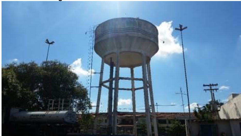
Figura 278: Reservatório elevado da UR 01.
