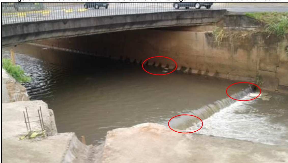
Figura 575 – Resíduos Sólidos no Sistema de Drenagem Urbana – Calha Rio Bauru.
