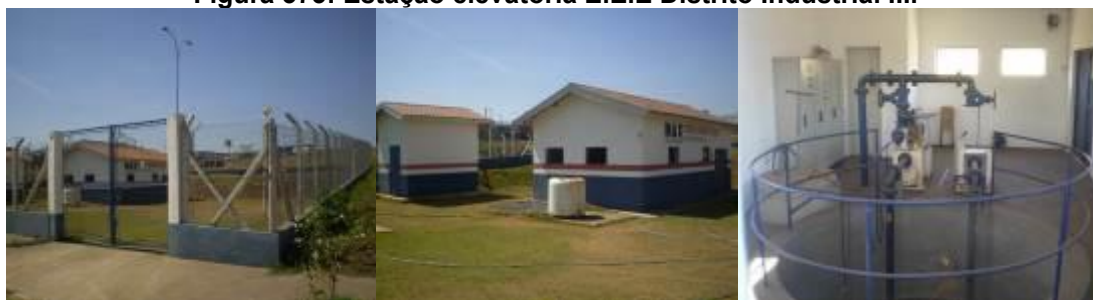
Figura 373: Estação elevatória E.E.E Distrito Industrial III.
