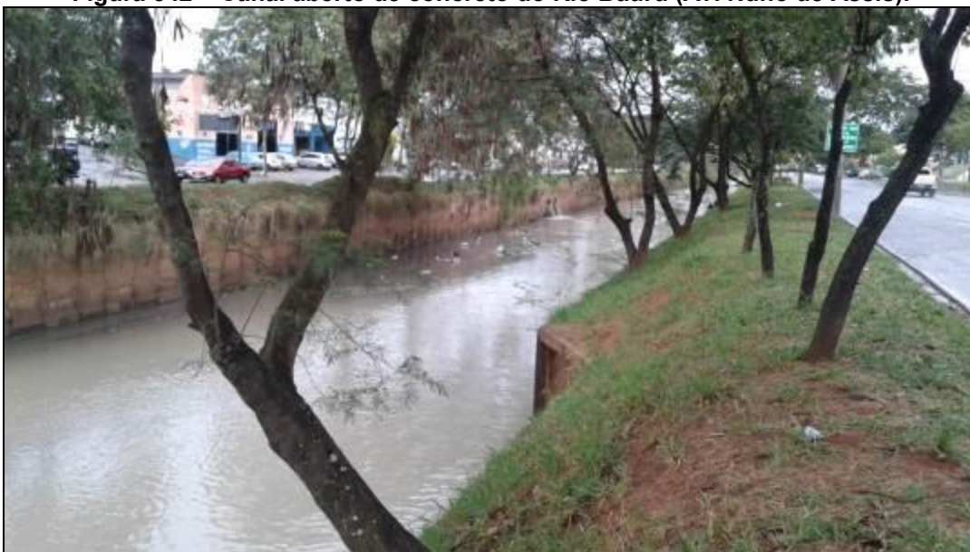
Figura 542 – Canal aberto de concreto do Rio Bauru (Av. Nuno de Assis).
