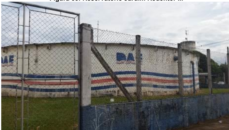
Figura 63: Reservatório Jardim Redentor II.
