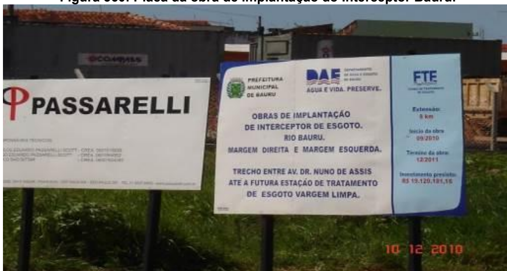
Figura 360: Placa da obra de implantação do Interceptor Bauru.
