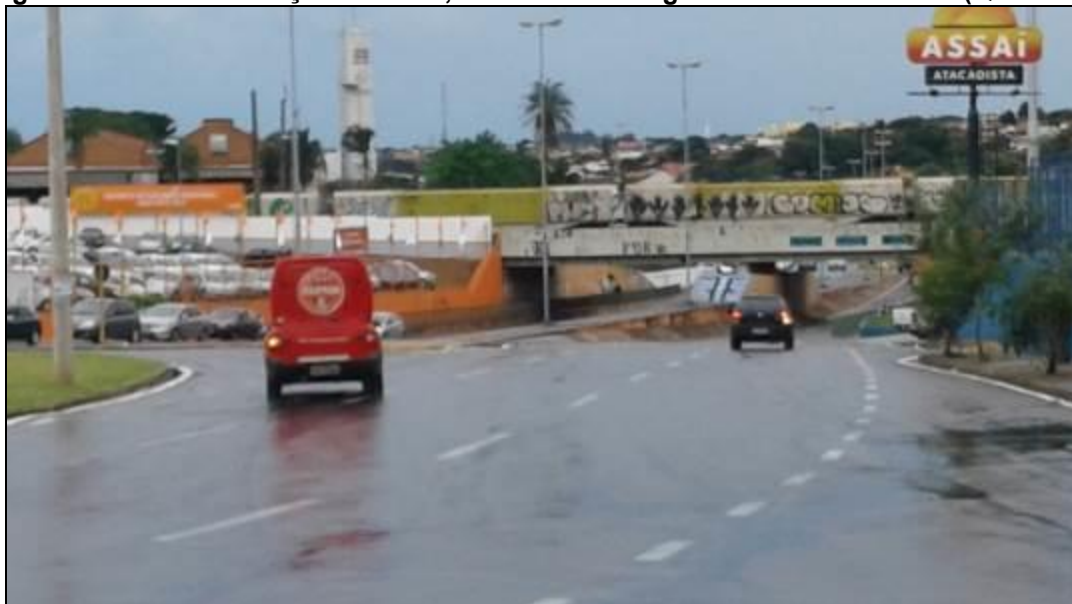
Figura 514 – Av. das Nações Unidas, trechos com alagamentos de Risco MA (Q. 1 a 27).
