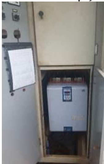
Figura 184: Acionamento do poço Mary Dota.
