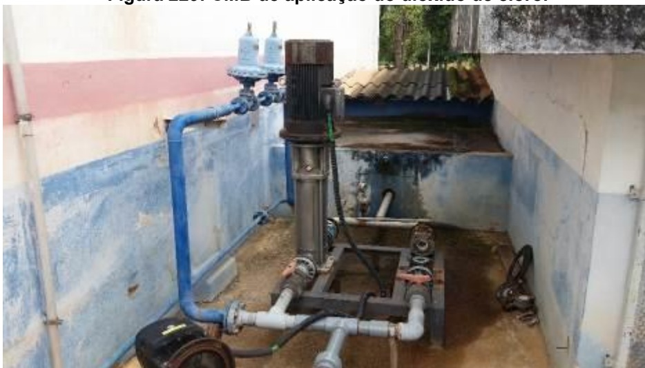
Figura 229: CMB de aplicação do dióxido de cloro.
