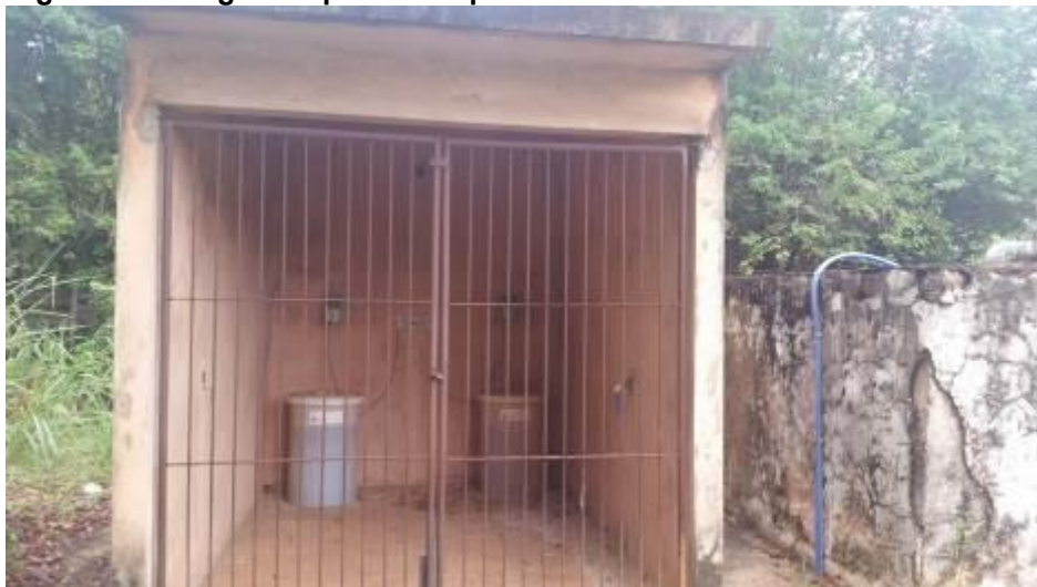
Figura 51: Abrigo dos produtos químicos do sistema Chácara Bauruense.
