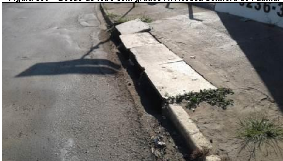
Figura 550 – Bocas-de-lobo sem grades Av. Nossa Senhora de Fátima.
