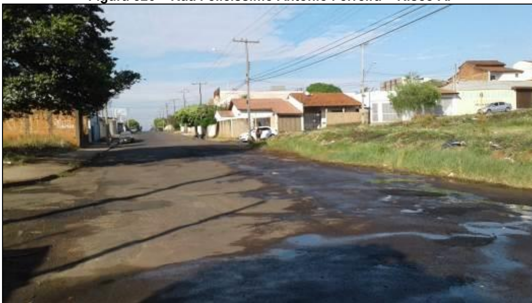
Figura 526 – Rua Felicíssimo Antônio Ferreira – Risco A.
