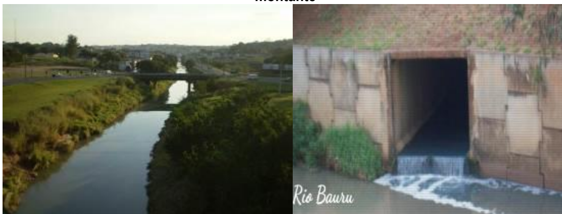
Figura 361: Fotos das obras do Interceptor Rio Bauru. Foto à esquerda trecho do Rio Bauru a montante
