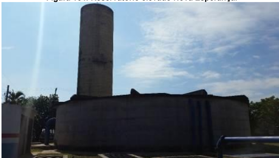
Figura 164: Reservatório elevado Nova Esperança.
