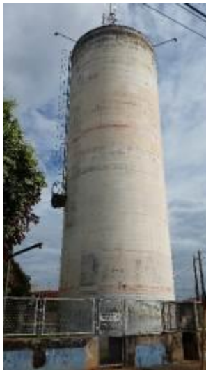
Figura 65: Reservatório Jardim Redentor I.
