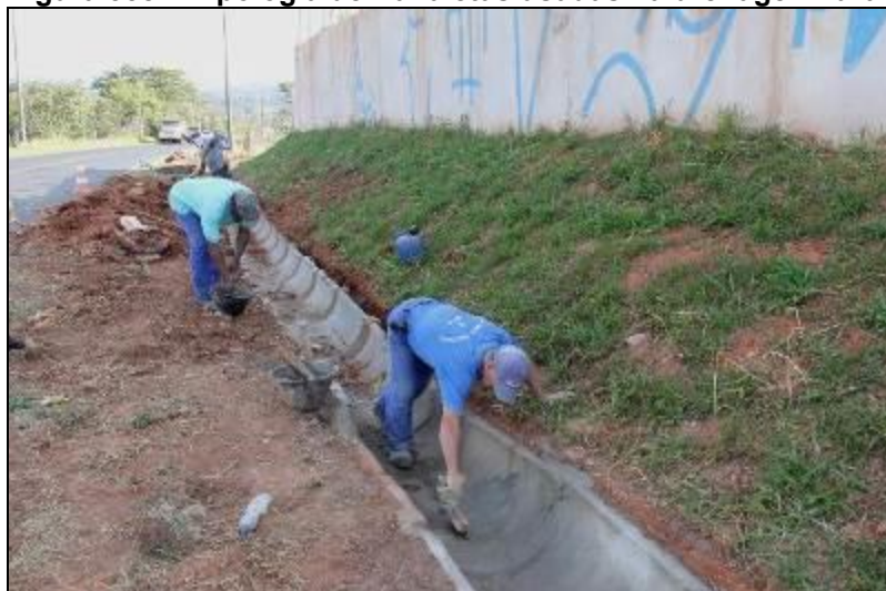
Figura 558 – Tipologia de Canaletas usadas na drenagem rural.
