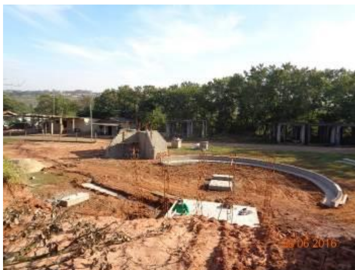
Figura 436: Usina de Reciclagem de RCC - Fase de Construção
