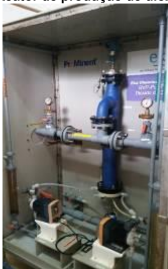
Figura 227: Reator de produção de dióxido de cloro.
