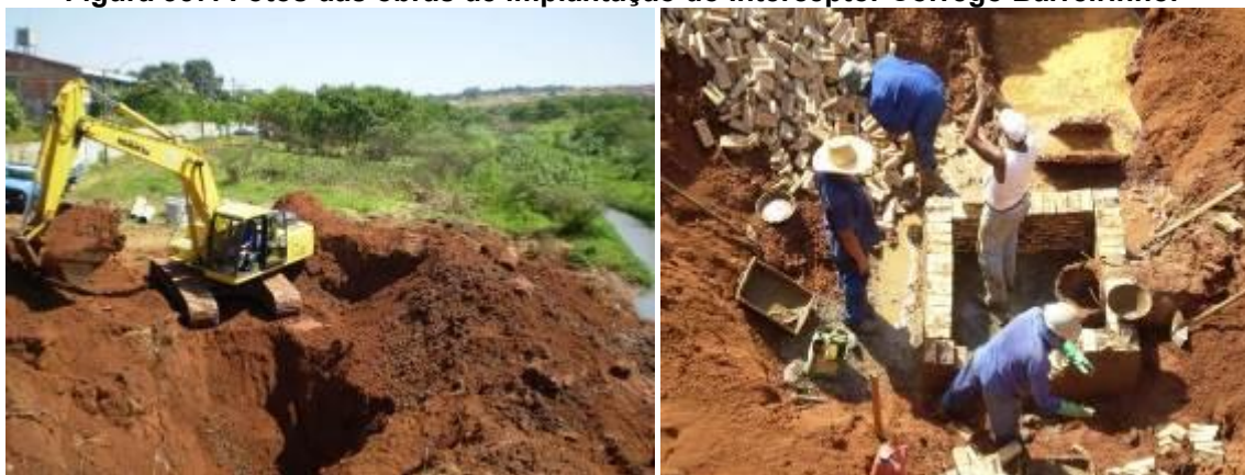
Figura 357: Fotos das obras de implantação do Interceptor Córrego Barreirinho.
