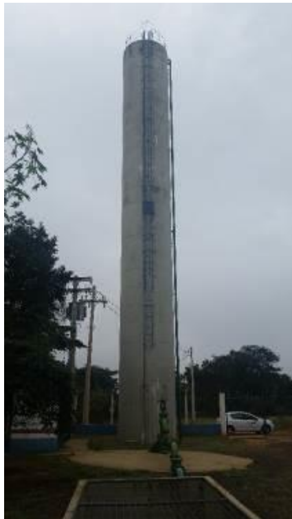
Figura 56: Reservatório elevado Manchester.
