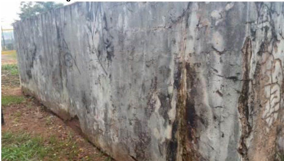
Figura 52: Reservatório Chácara Bauruense.
