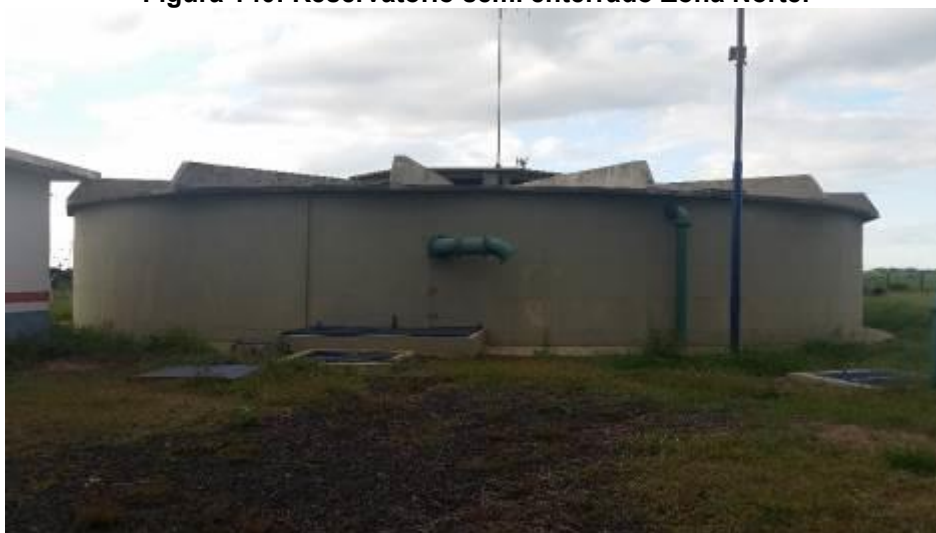
Figura 140: Reservatório semi enterrado Zona Norte.
