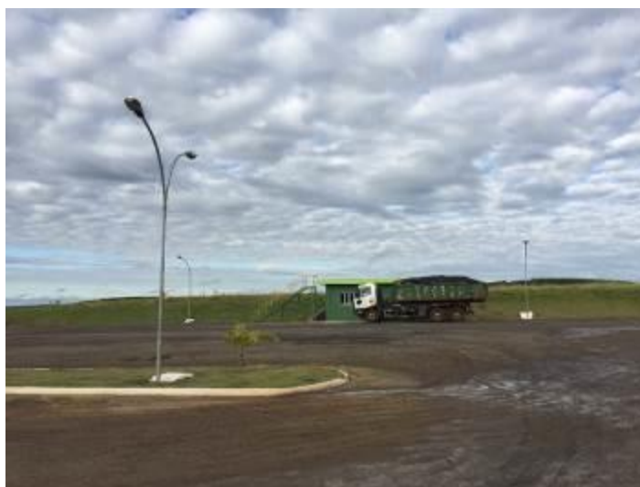
Figura 479: Paisagem e Análise dos Resíduos na Chegada ao Aterro
