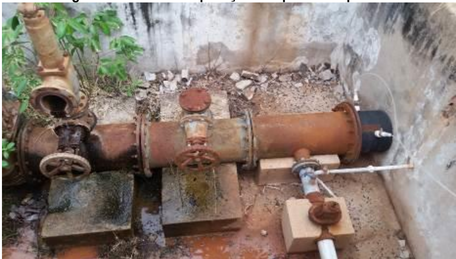
Figura 130: Ponto de aplicação dos produtos químicos.
