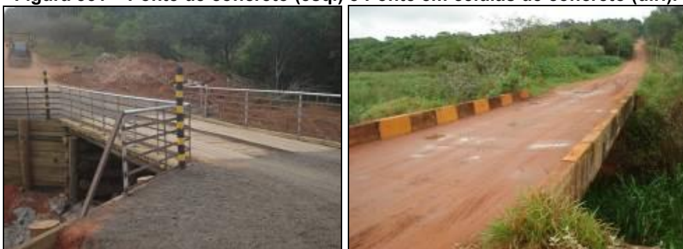
Figura 551 – Ponte de concreto (esq.) e Ponte em células de concreto (dir.).
