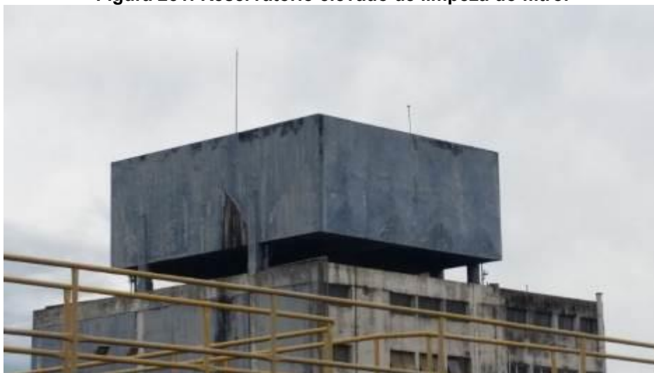
Figura 251: Reservatório elevado de limpeza do filtro.
