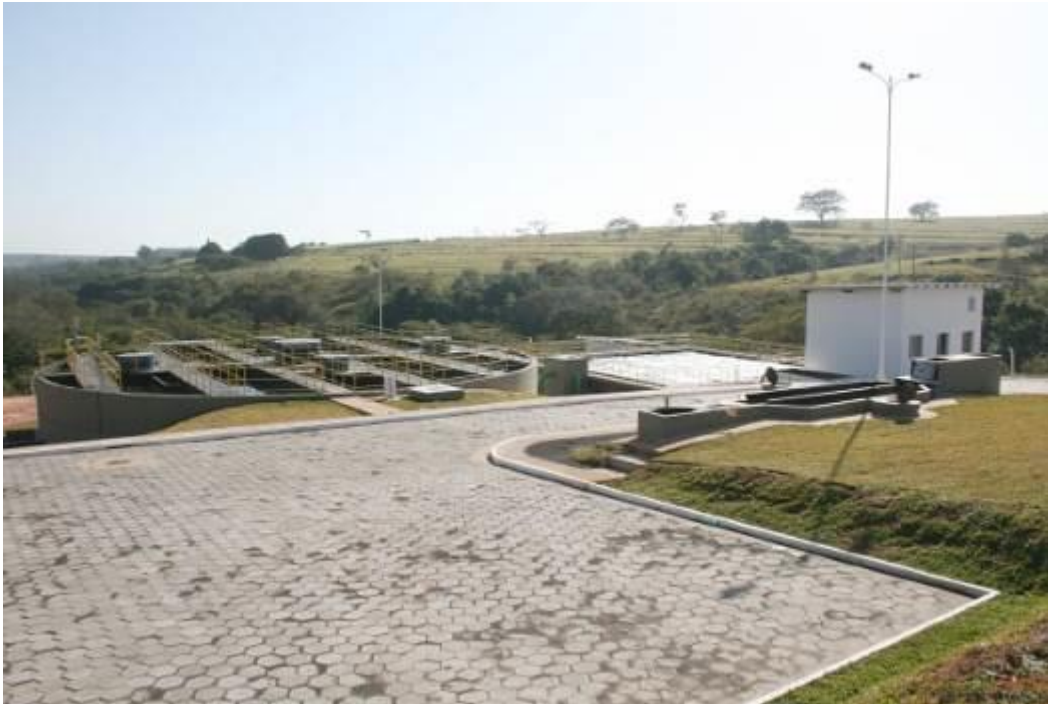
Figura 407: Aos fundos o reator anaeróbio
