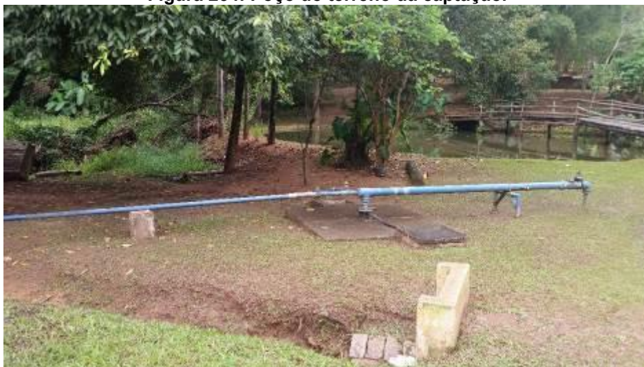
Figura 234: Poço do terreno da captação.
