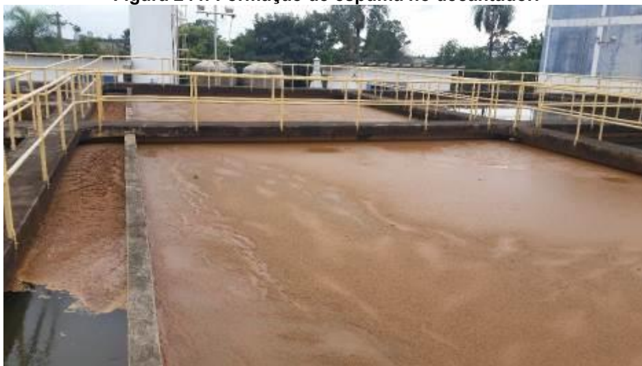
Figura 244: Formação de espuma no decantador.
