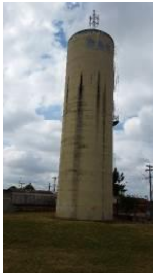
Figura 176: Reservatório IX de Julho elevado.
