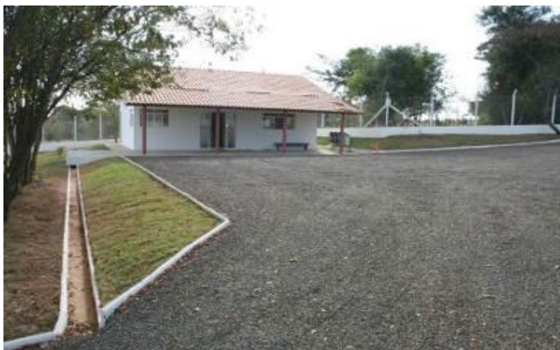
Figura 393: Casa do operador/laboratório.
