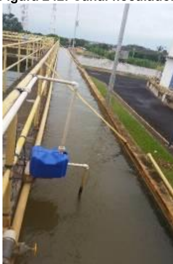
Figura 242: Canal floculador.
