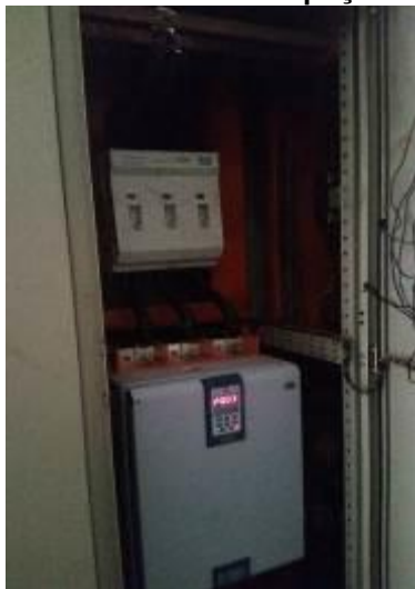
Figura 129: Acionamento do poço Gasparini.
