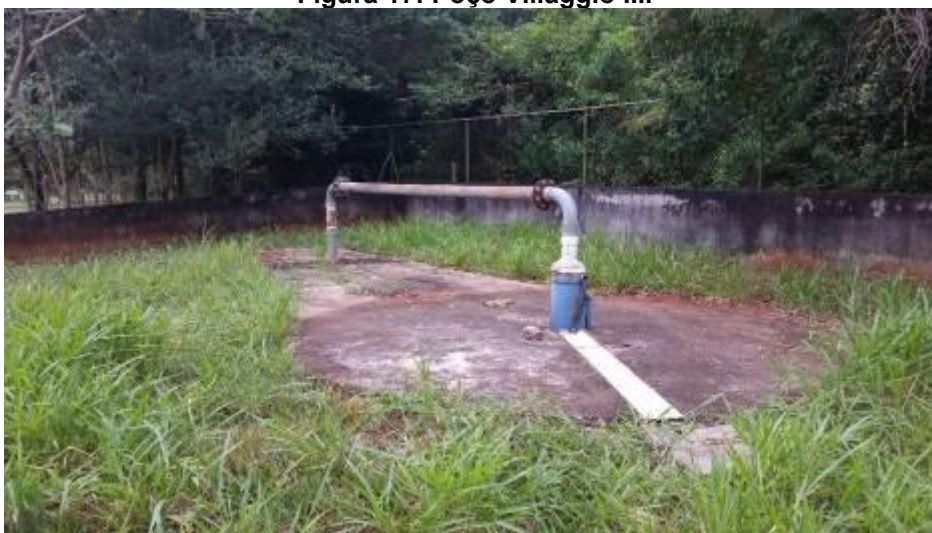
Figura 17: Poço Villaggio III.
