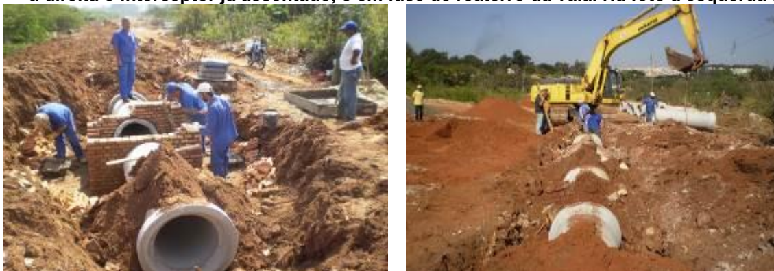
Figura 354: Fotos das obras de implantação do Interceptor Córrego Água da Ressaca. Na foto à direita o interceptor já assentado, e em fase de reaterro da vala. Na foto à esquerda a
