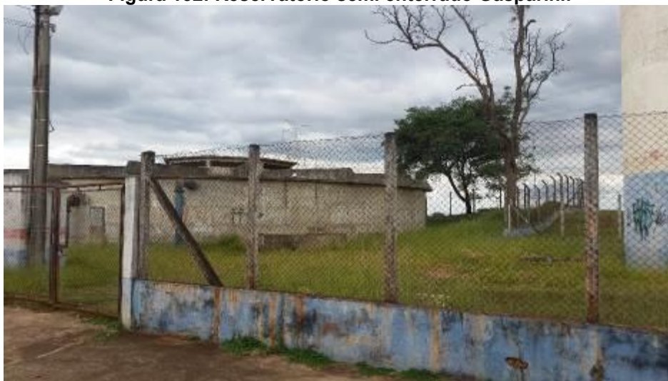
Figura 132: Reservatório semi enterrado Gasparini.
