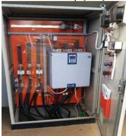
Figura 106: Acionamento do poço Nações Unidas II.
