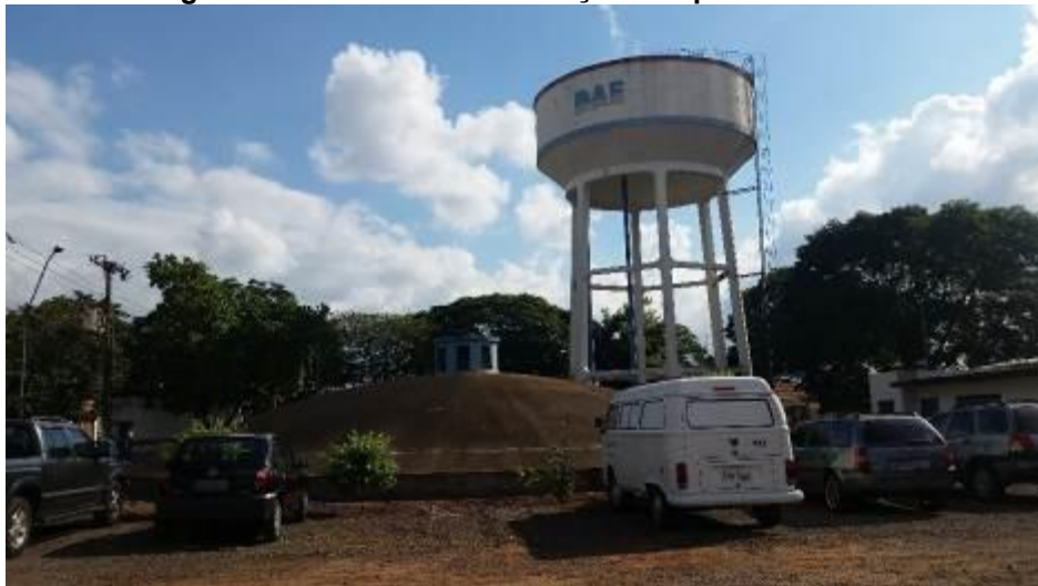
Figura 93: Unidade de reservação Parque Paulistano.
