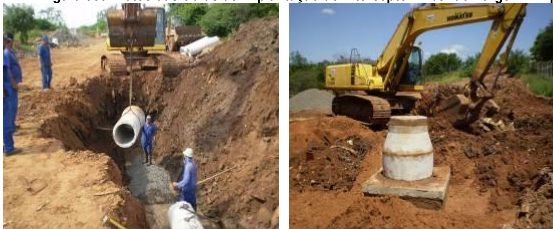
Figura 359: Fotos das obras de implantação do Interceptor Ribeirão Vargem Limpa.
