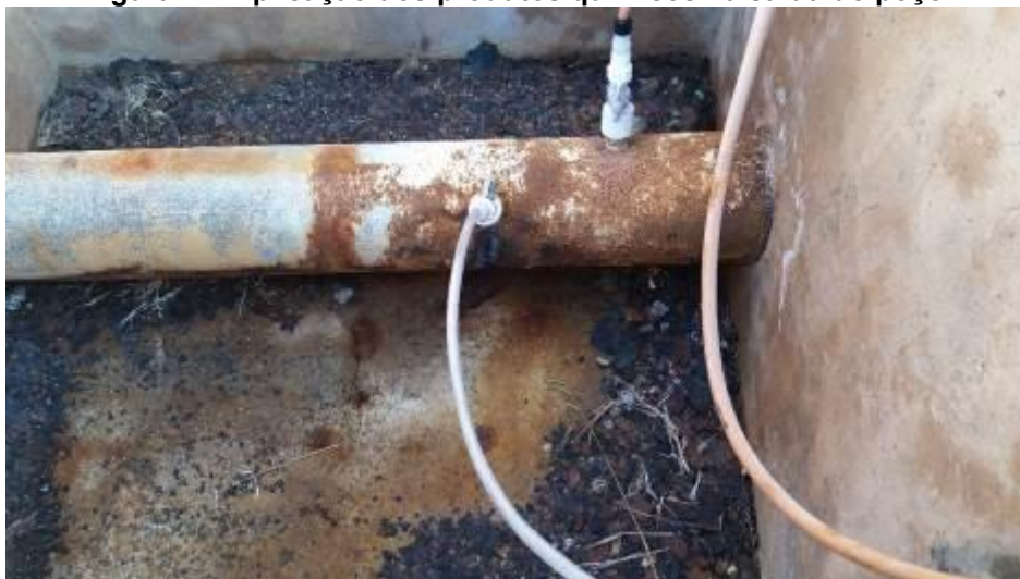
Figura 74: Aplicação dos produtos químicos na saída do poço.
