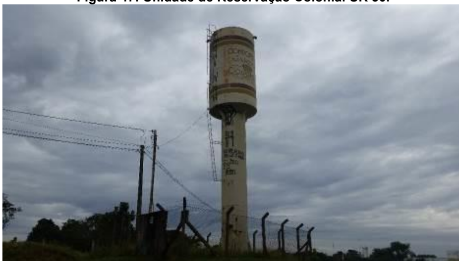
Figura 47: Unidade de Reservação Colonial UR 30.
