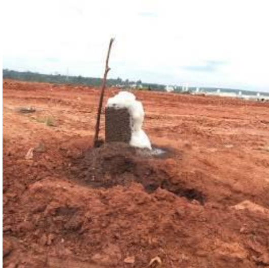
Figura 499: Chorume Extravasando pela Chaminé de Gás
