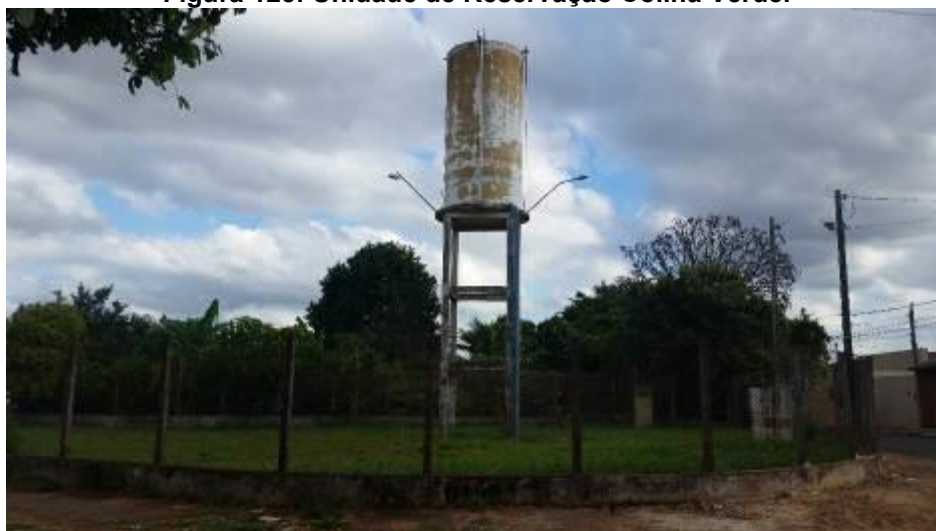
Figura 125: Unidade de Reservação Colina Verde.
