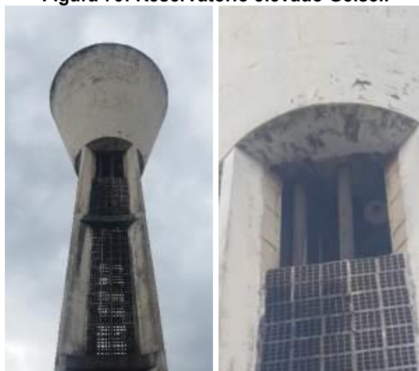
Figura 79: Reservatório elevado Geisel.
