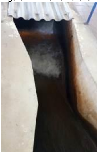
Figura 241: Calha Parshall.
