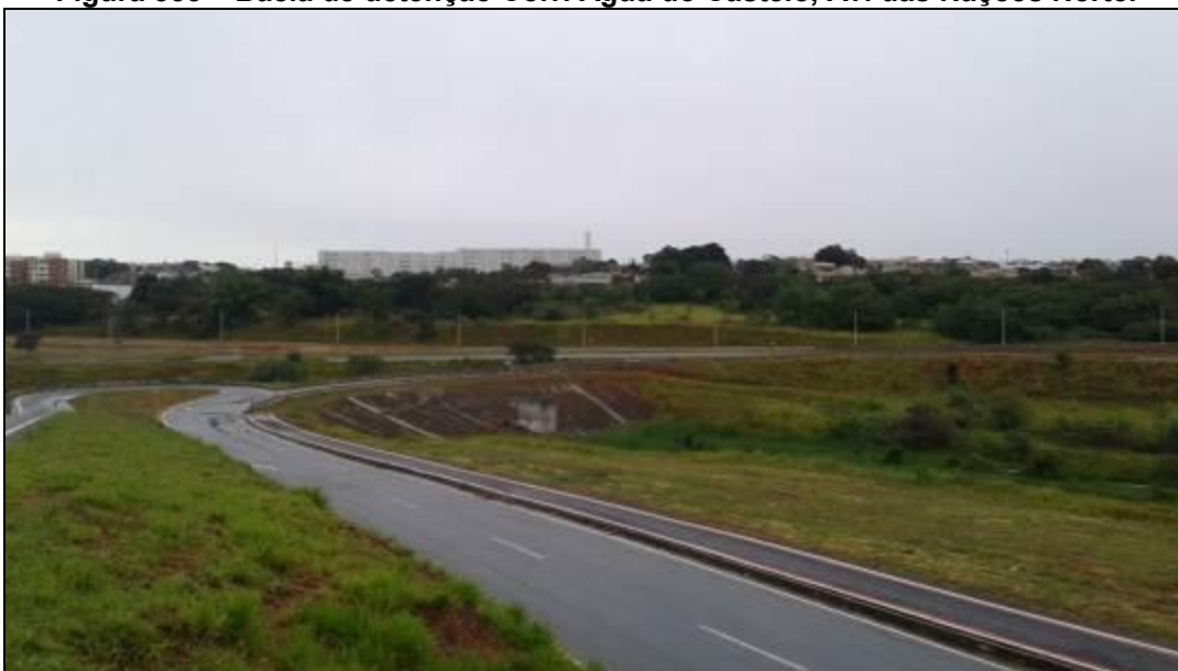
Figura 553 – Bacia de detenção Cór. Água do Castelo, Av. das Nações Norte.
