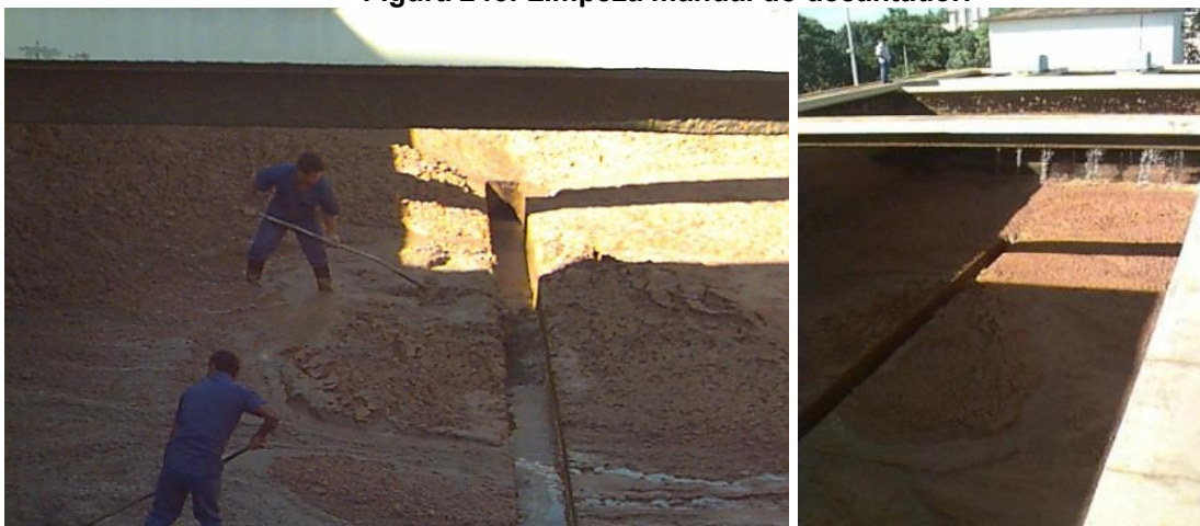
Figura 246: Limpeza manual do decantador.
