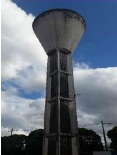
Figura 124: Reservatório elevado Ipê.
