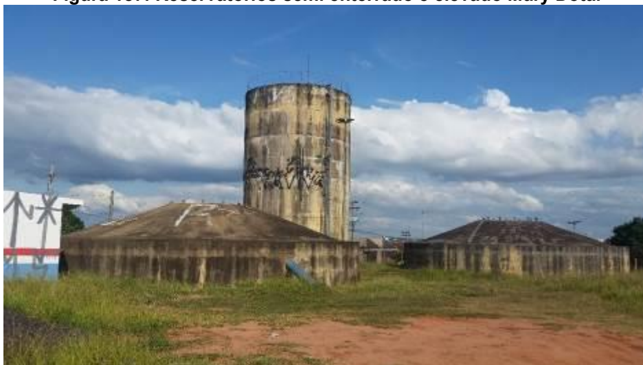
Figura 187: Reservatórios semi enterrado e elevado Mary Dota.
