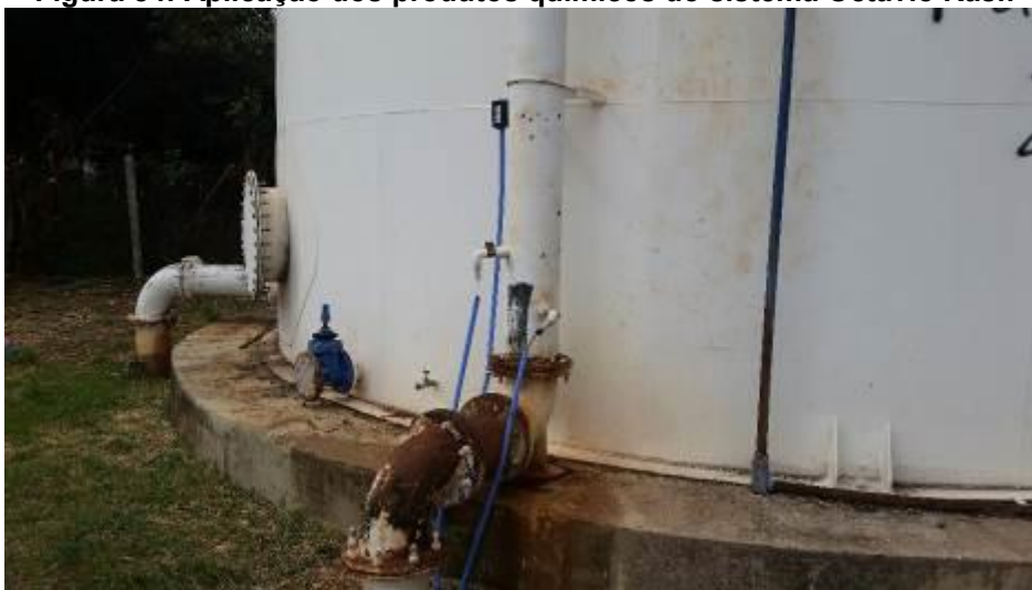
Figura 84: Aplicação dos produtos químicos do sistema Octávio Rasi.
