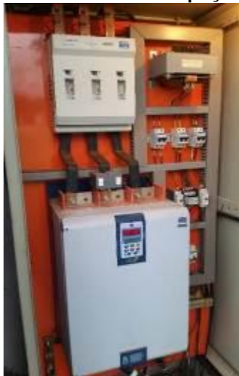
Figura 43: Acionamento do poço Marabá.
