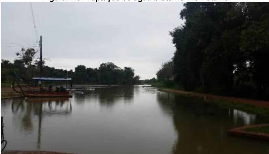
Figura 219: Captação de água bruta no Rio Batalha.
