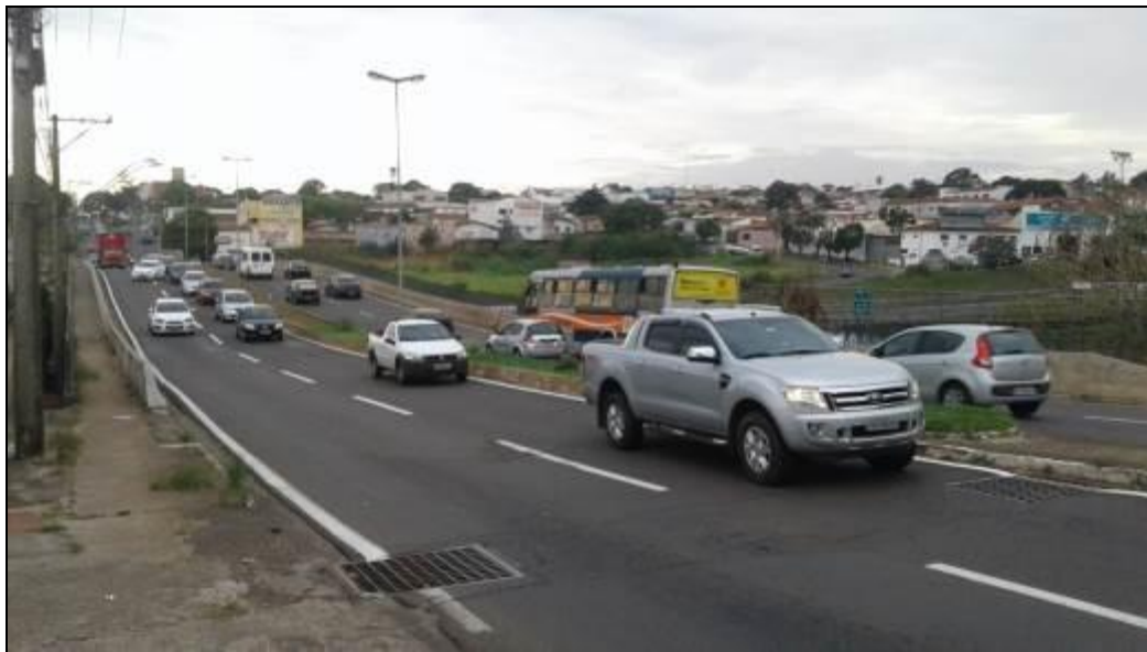
Figura 548 – Bocas-de-lobo gradeadas no viaduto Av. Rodrigues Alves sobre Rod. Mal. Rondon.
