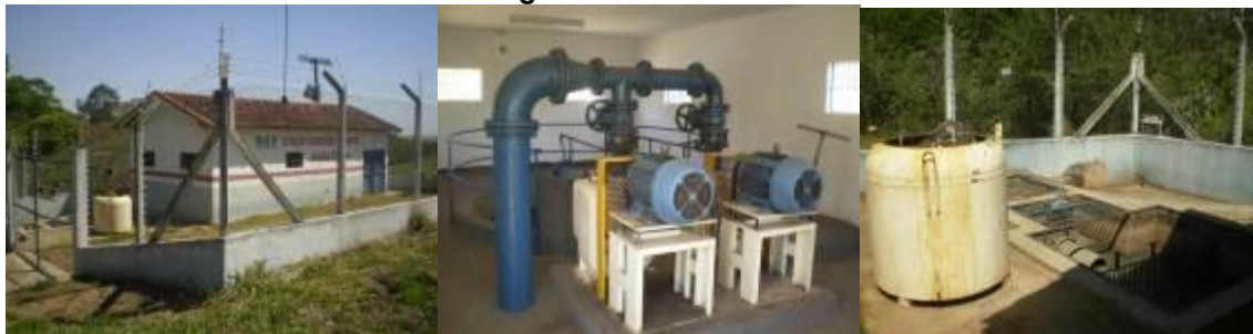
Figura 380: Estação elevatória EEE Jardim Vitória. À direita a chegada do esgoto bruto, com as unidades de gradeamento e caixa de área.
