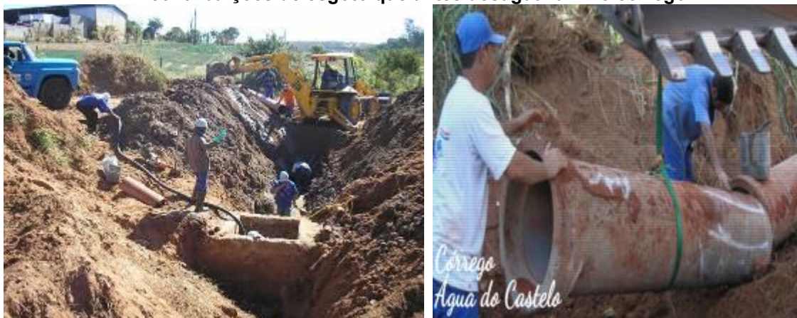
Figura 355: Fotos das obras de implantação do Interceptor Córrego Água do Castelo. Na foto à direita a travessia sobre o córrego. Na foto à esquerda a construção do PV para interceptar contribuições de esgoto que antes desaguavam no córrego.
