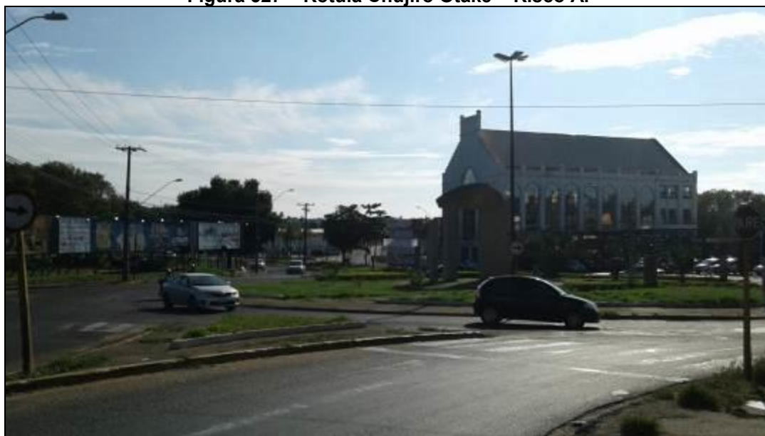
Figura 527 – Rótula Chujiro Otake – Risco A.
