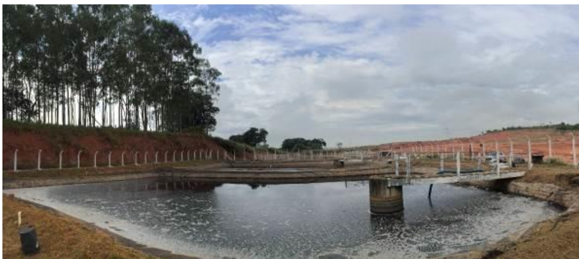
Figura 486: Lagoas de Armazenamento de Chorume
