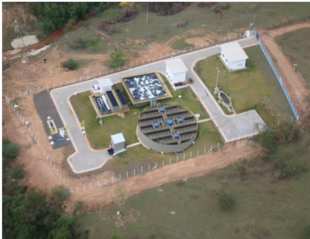
Figura 404: Vista aérea da ETE Candéia.
