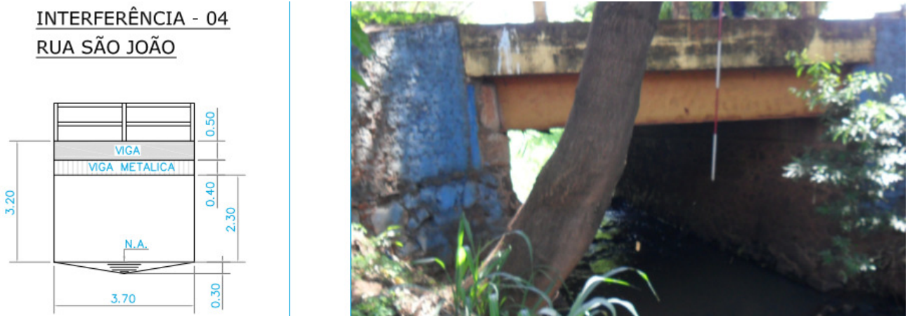
Figura 27: Vista da Ponte 12 – Rua São João
