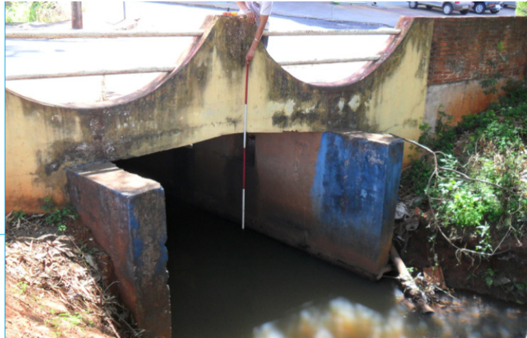
Figura 31: Vista da Ponte 14 – Rua Gonçalves Dias
