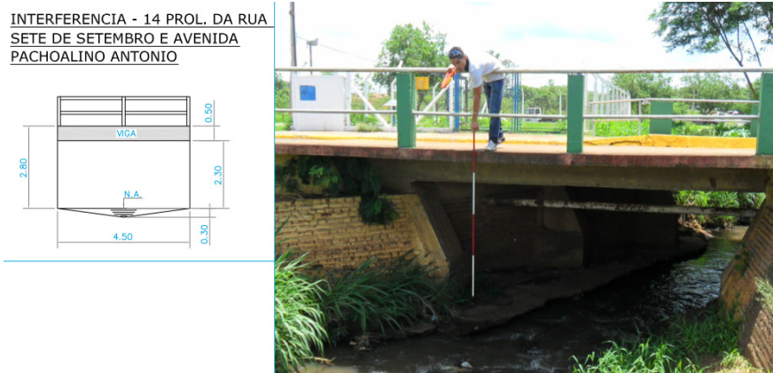
Figura 13: Vista da Ponte 05– Rua Sete de Setembro
