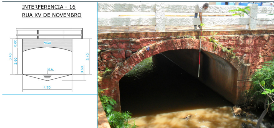
Figura 15: Vista da Ponte 07– Rua XV de Novembro
