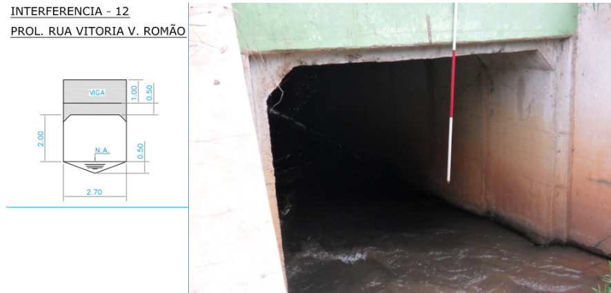
Figura 09: Vista da Ponte 03– Rua Victoria Venturini Romão
