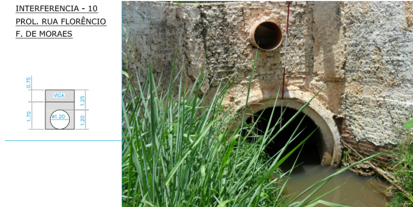
Figura 05: Vista da Ponte 01 – Prolongamento da Rua Florêncio F. Moraes.
