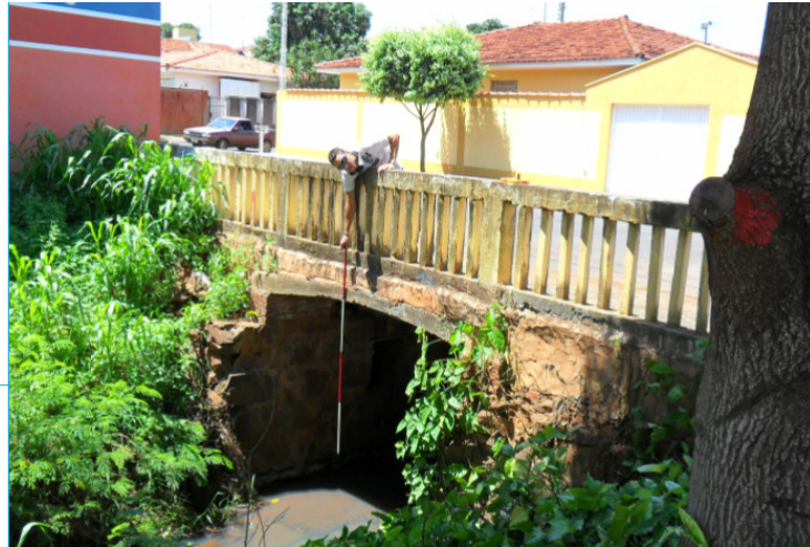
Figura 33: Vista da Ponte 15 – Rua Prudente de Moraes
