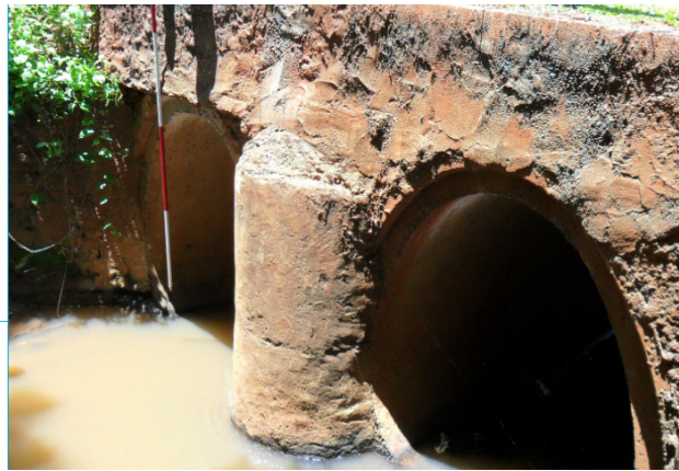
Figura 07: Vista da Ponte 02 – Prolongamento da Rua São João.
