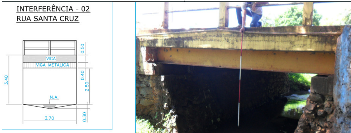
Figura 25: Vista da Ponte 10 – Rua Santa Cruz
