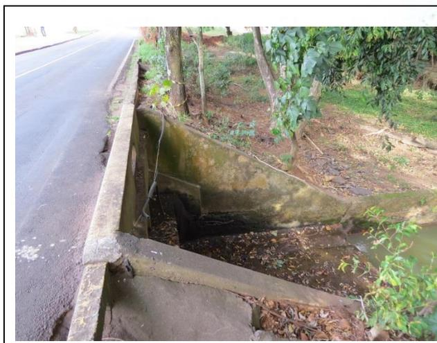
**FOTO 155** – Vista de canal de condução das águas, oriundas do lago da UFSCAR, para a bacia de dissipação.
