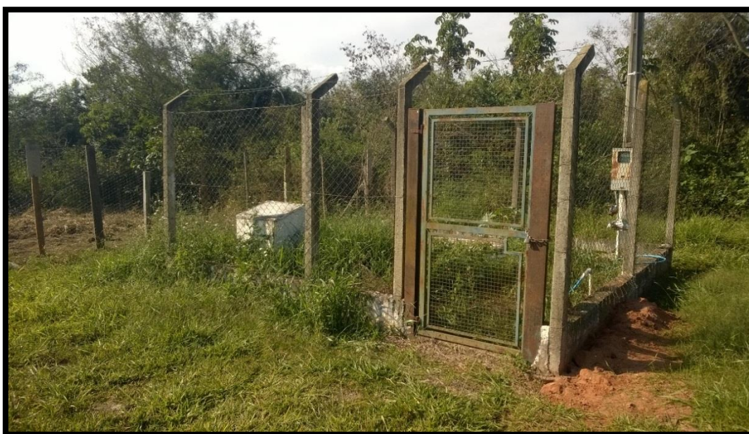
Figura 31 - Vista do local da Estação Elevatória de Esgoto 02 - Jardim Nova Itirapina
