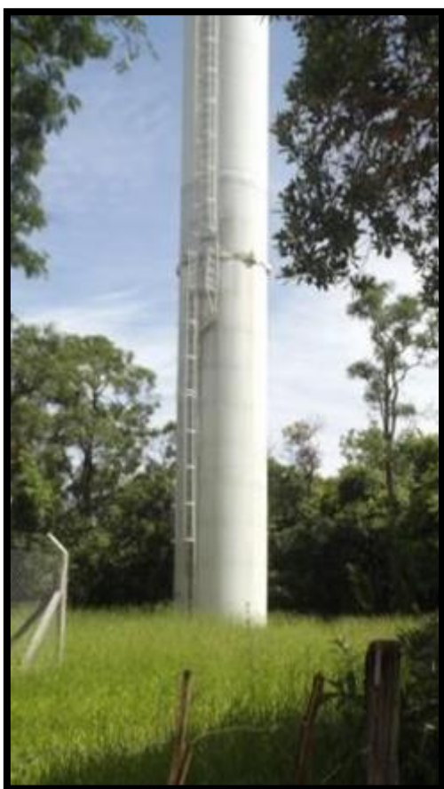
Figura 17 - Reservatório 09 - Rua 3, Estância Ubá
