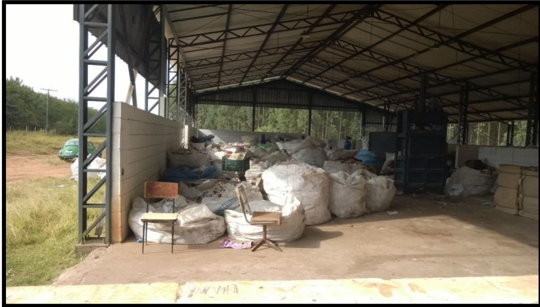
Figura 43 - Centro de Triagem Operado pela COOPEREI
