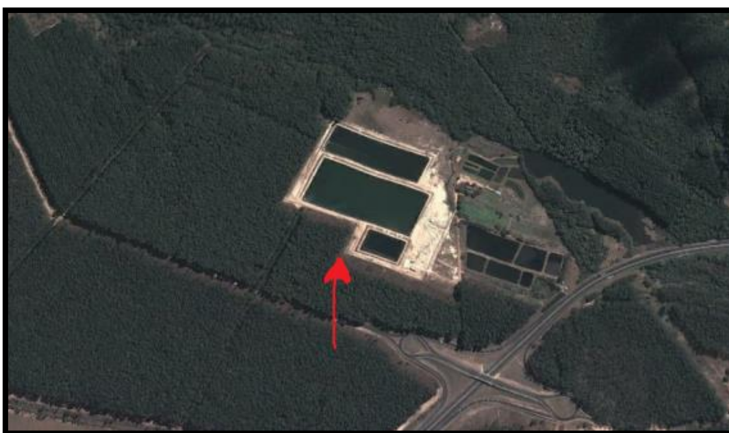
Figura 23 - Vista aérea das Lagoas de Tratamento
