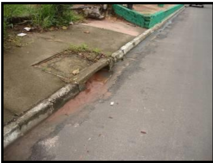
Figura 75 - Boca de lobo presente no local
