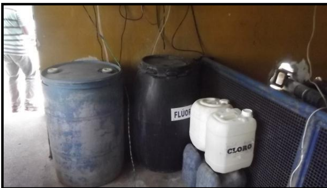
Figura 7 - Dosagem de Cloro e Flúor Poço 09, Reservatório 03
