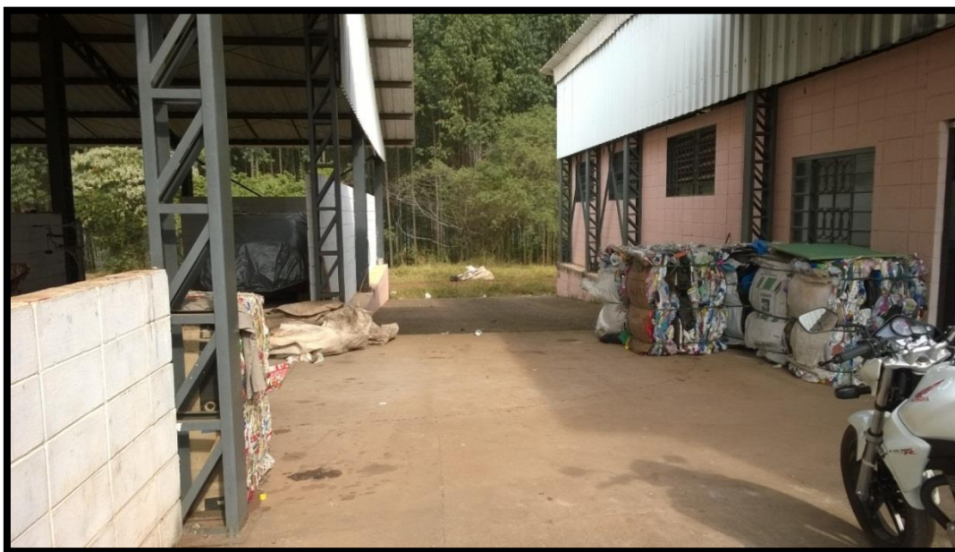
Figura 45 - Centro de Triagem Operado pela COOPEREI
