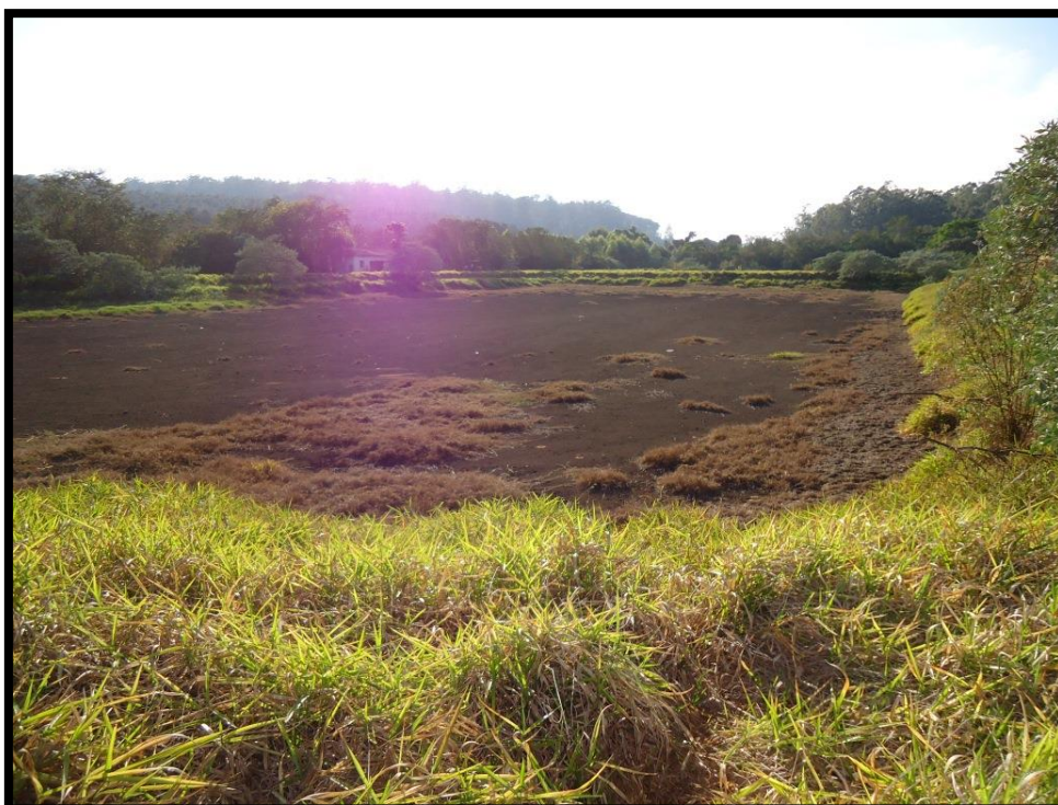
Figura 21 – Antiga ETE desativada.
