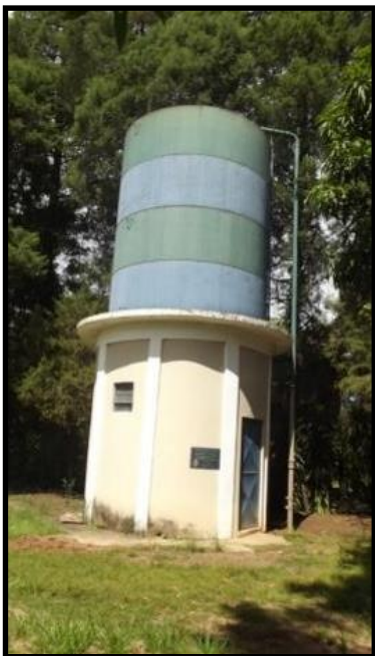
Figura 4 - Reservatório 7 Jardim Ubá –Itirapina-SP
