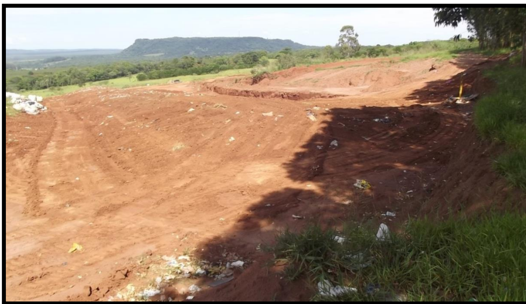
Figura 54 - Vista do Aterro Sanitário em Valas - Itirapina-SP
