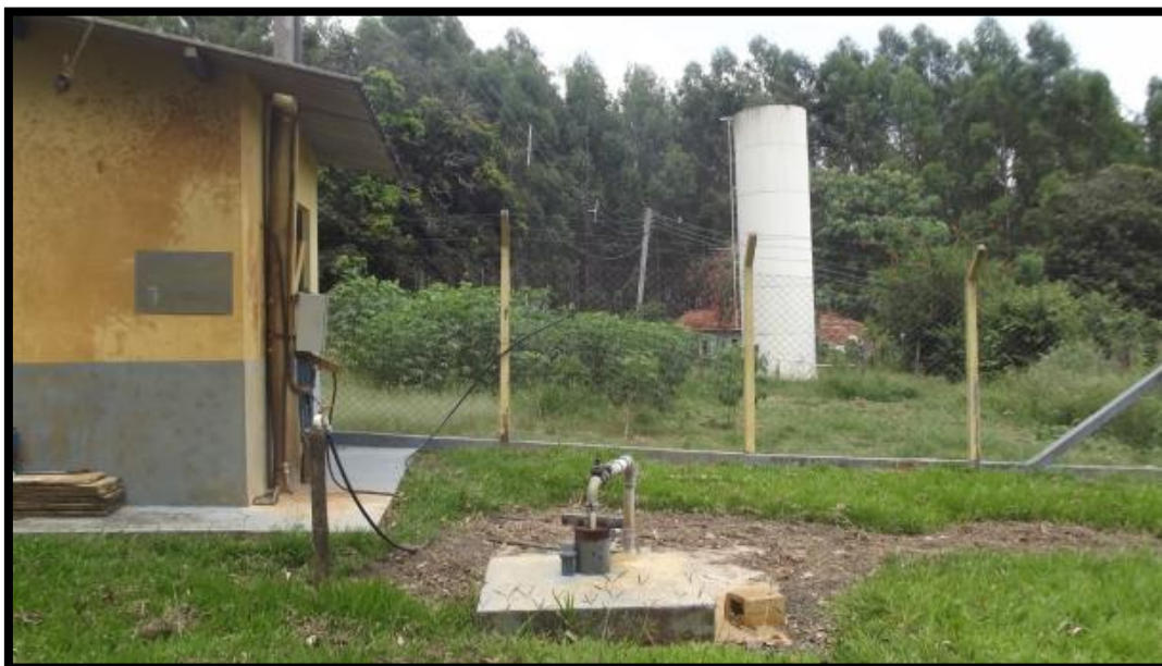
Figura 14 - Poço 07 e Reservatório 08 – Rua 02 Itaqueri da Serra
