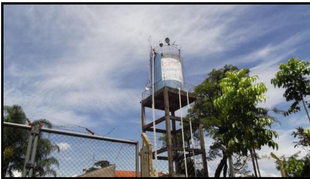
Figura 16 - Reservatório 6 - Rua 13, Balneário Santo Antônio
