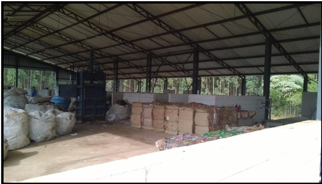
Figura 44 - Centro de Triagem Operado pela COOPEREI
