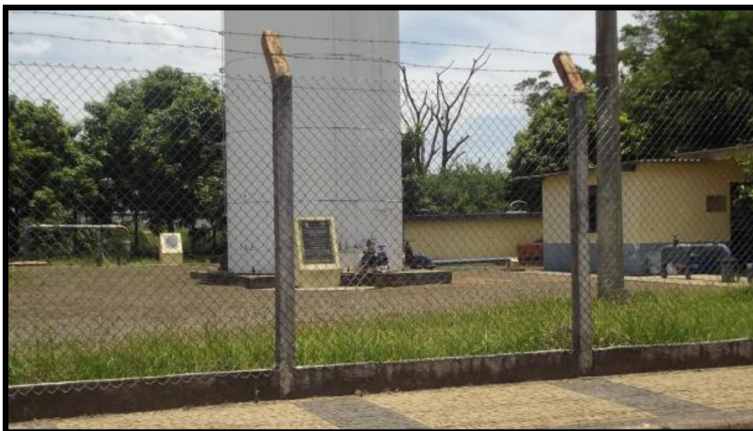
Figura 10 - Poço 02 e Reservatório 2 e Poço 01– Rua 5- Vila Garbi
