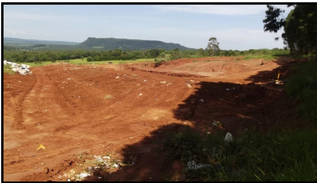
Figura 50 - Vista do Aterro Sanitário em Valas – Itirapina-SP
