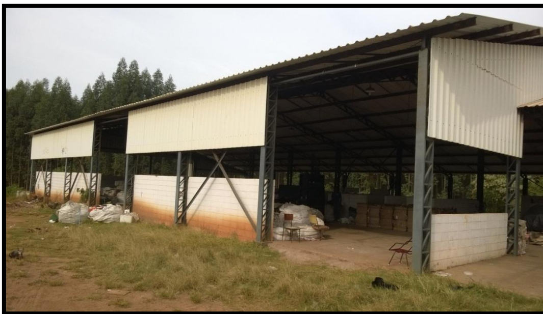
Figura 47 - Centro de Triagem Operado pela COOPEREI
