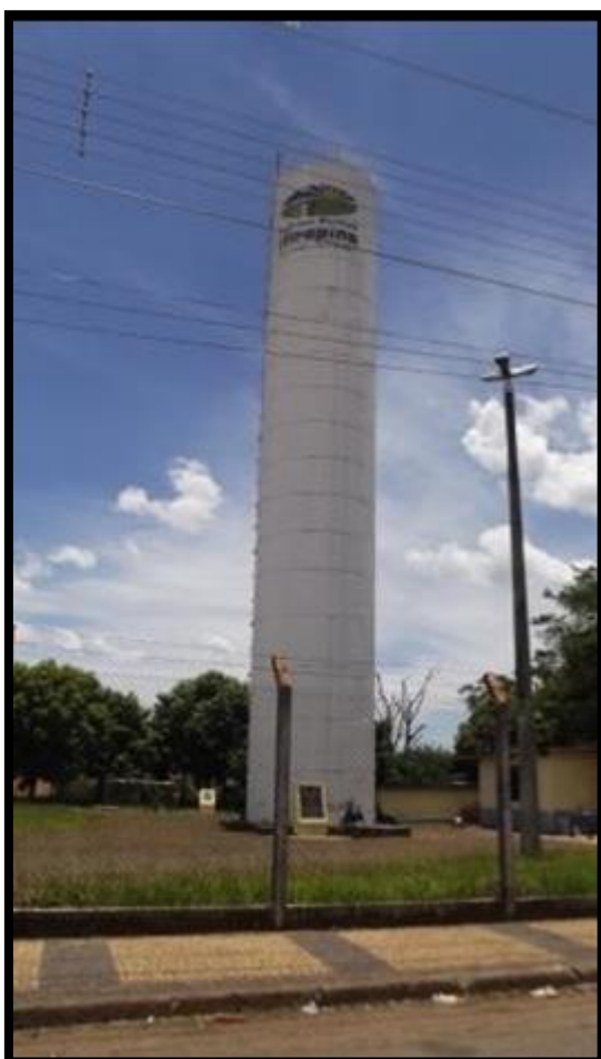
Figura 13 - Reservatório 02 - Rua 5 – Vila Garbi
