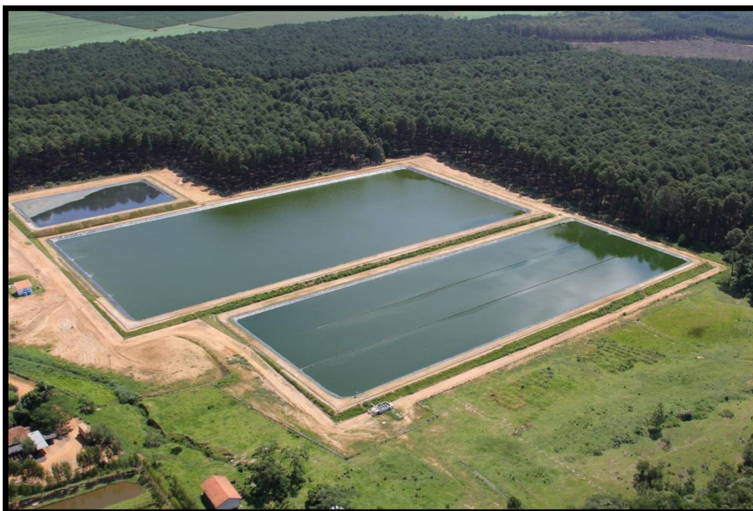
Figura 22 - Vista Aérea das lagoas de tratamento da estação de tratamento
