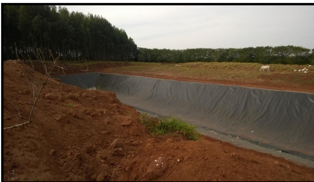
Figura 55 - Vala com Manta PEAD no Aterro Sanitário em Valas de Itirapina-SP
