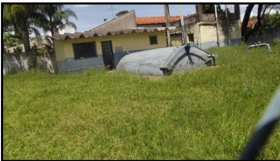
Figura 15 - Poço 05 - Rua 13, Balneário Santo Antônio
