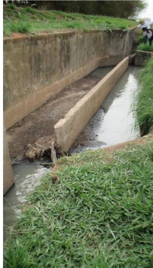
Figura 89 - Calha parshall de entrada da ETE São José das Correntes, parcialmente obstruída
